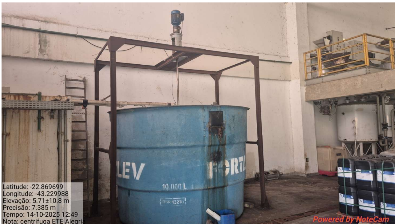
Foto 55: Misturador de polímeros em condições precárias.
