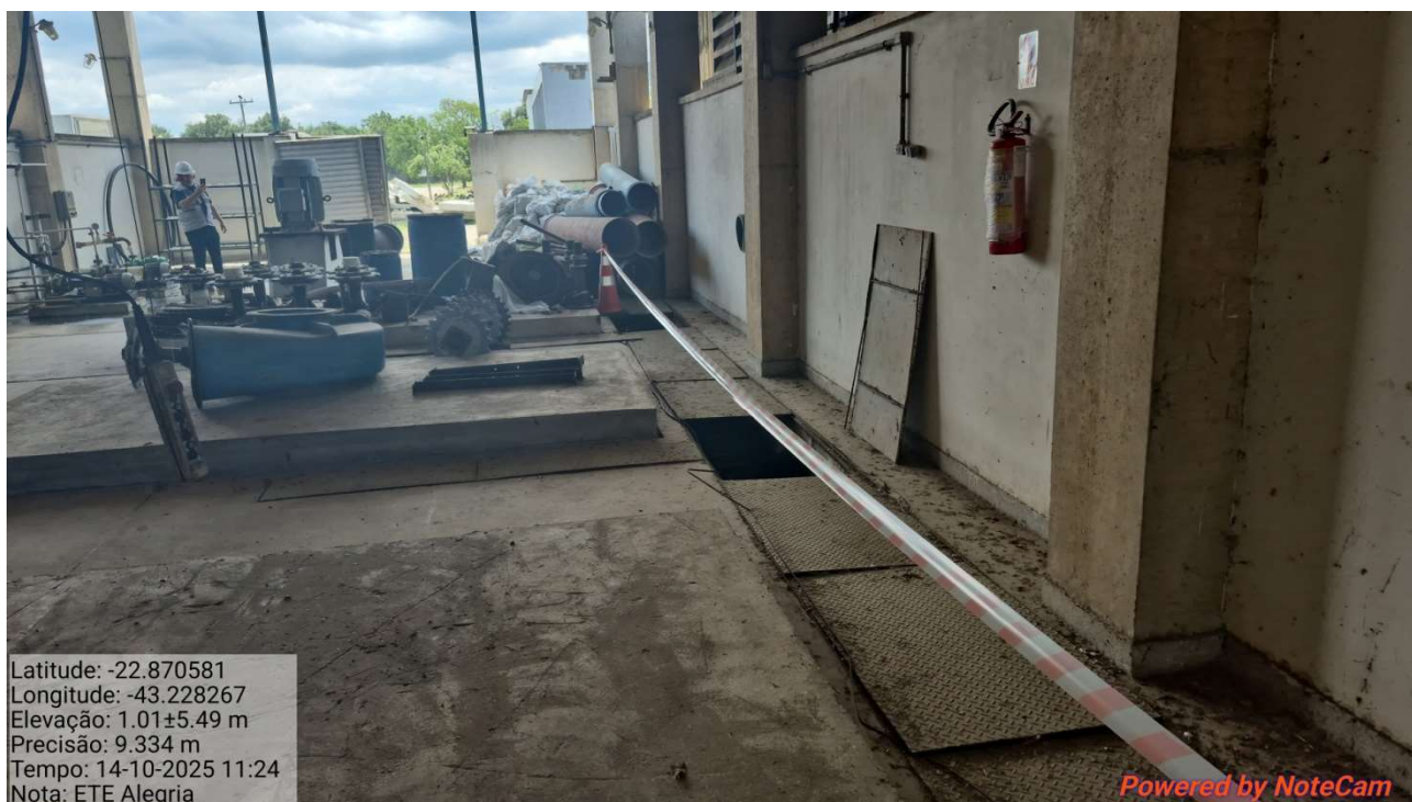
Foto 41: Acúmulo de materiais na área e isolamento precário.
