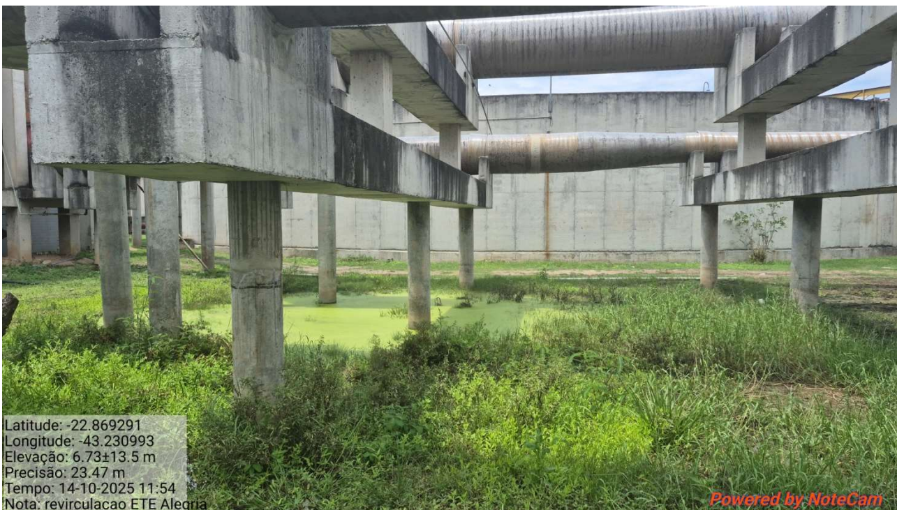
Foto 29: Acúmulo de águas pluviais no entorno das estruturas já com indícios de eutrofização.
