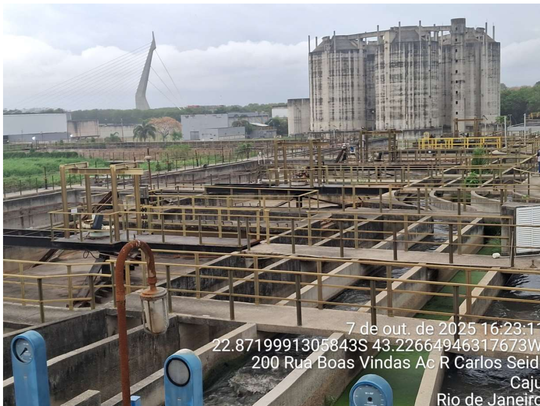
Foto 12: Caixas de Areia.
