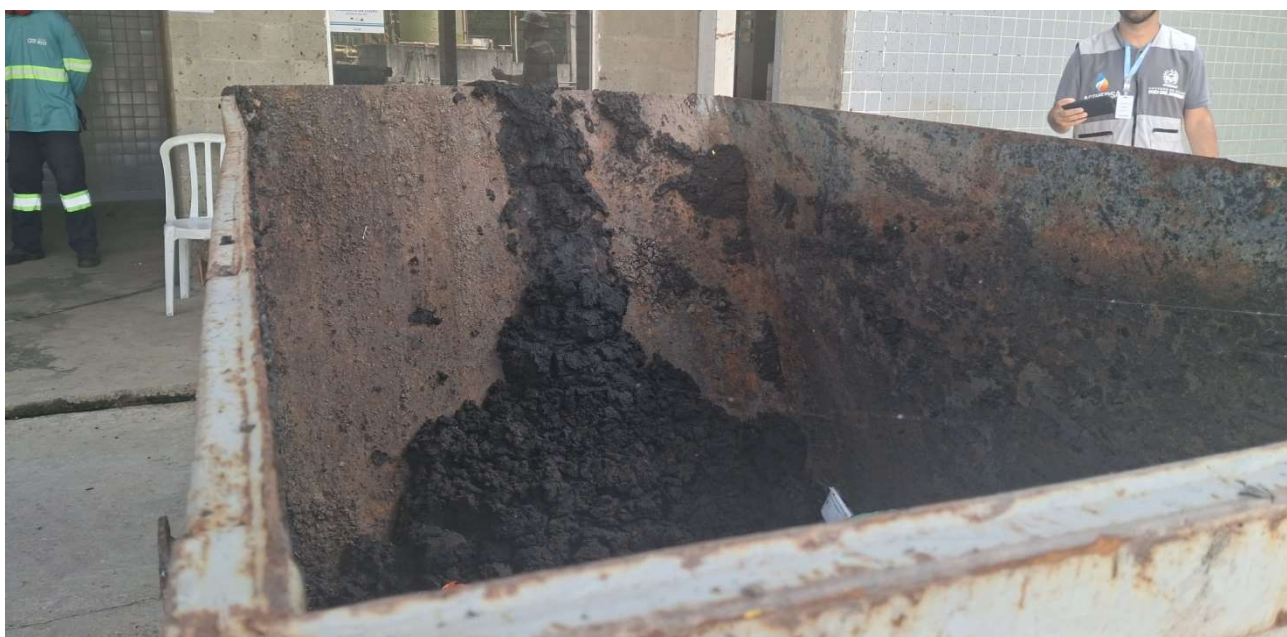
Foto 57: Saída do lodo. Aspecto úmido, indicando baixa eficiência de estabilização e de desaguamento.
