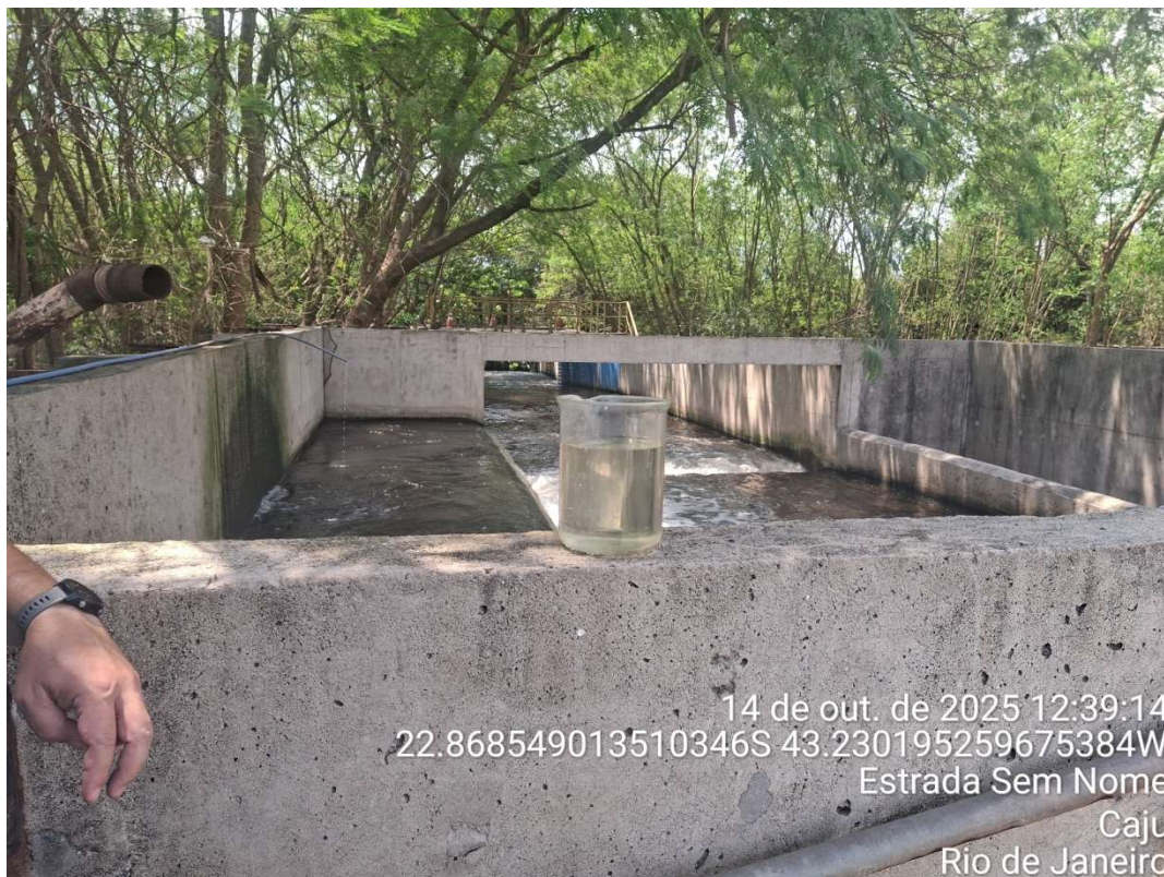
Foto 64: Efluente tratado com coloração com leve tom marrom, sugerindo clarificação incompleta.
