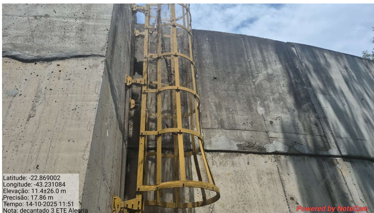
Foto 27: Índios de falta de manutenção na escada de acesso.
