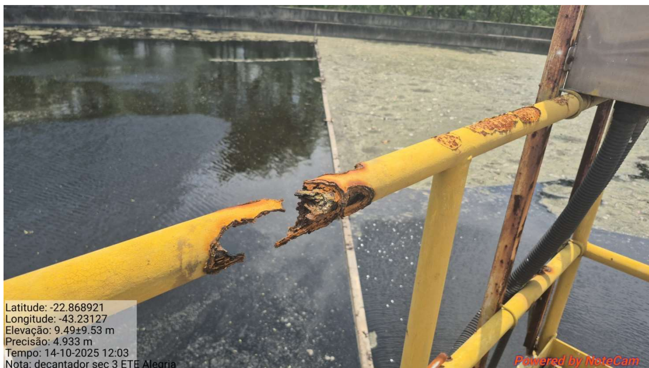
Foto 26: Guarda corpo danificado.
