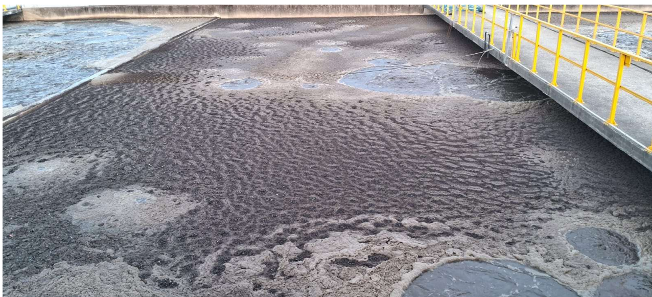
Foto 23: Zona morta sem aeração suficiente.
