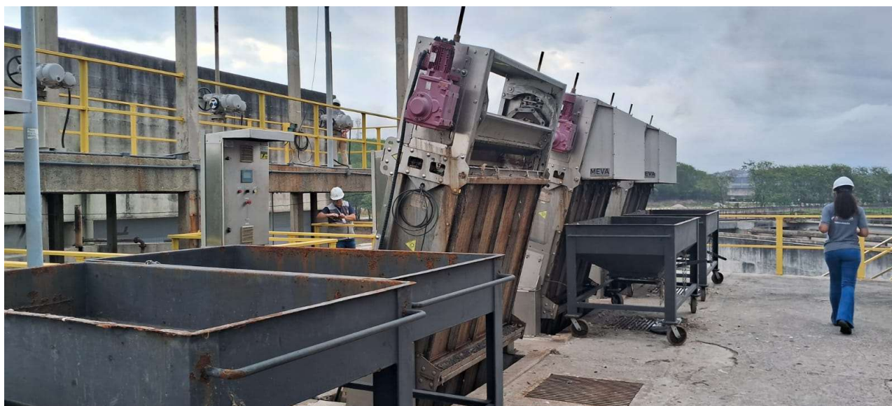
Foto 9 – Sistema de gradeamento mecanizado.
