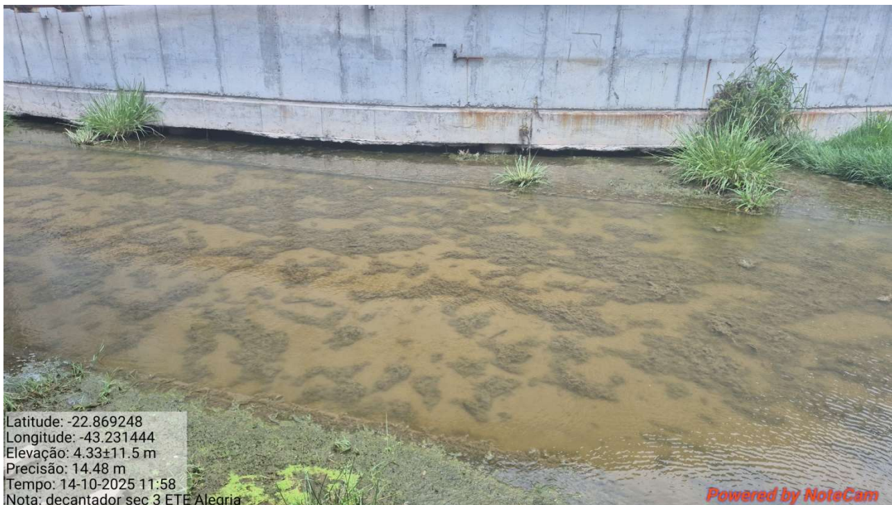
Foto 28: Acúmulo de água pluvial nos arredores do decantador. Possibilidade de danificar estruturas adjacentes.
