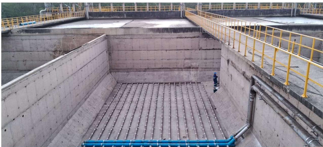
Foto 25: Tanque de aeração em manutenção. Difusores sendo instalados.
