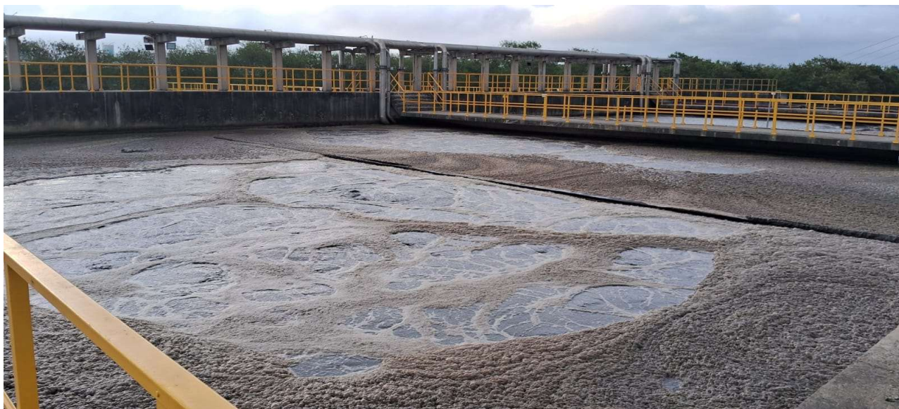
Foto 24: Tanque sem mistura homogênea.
