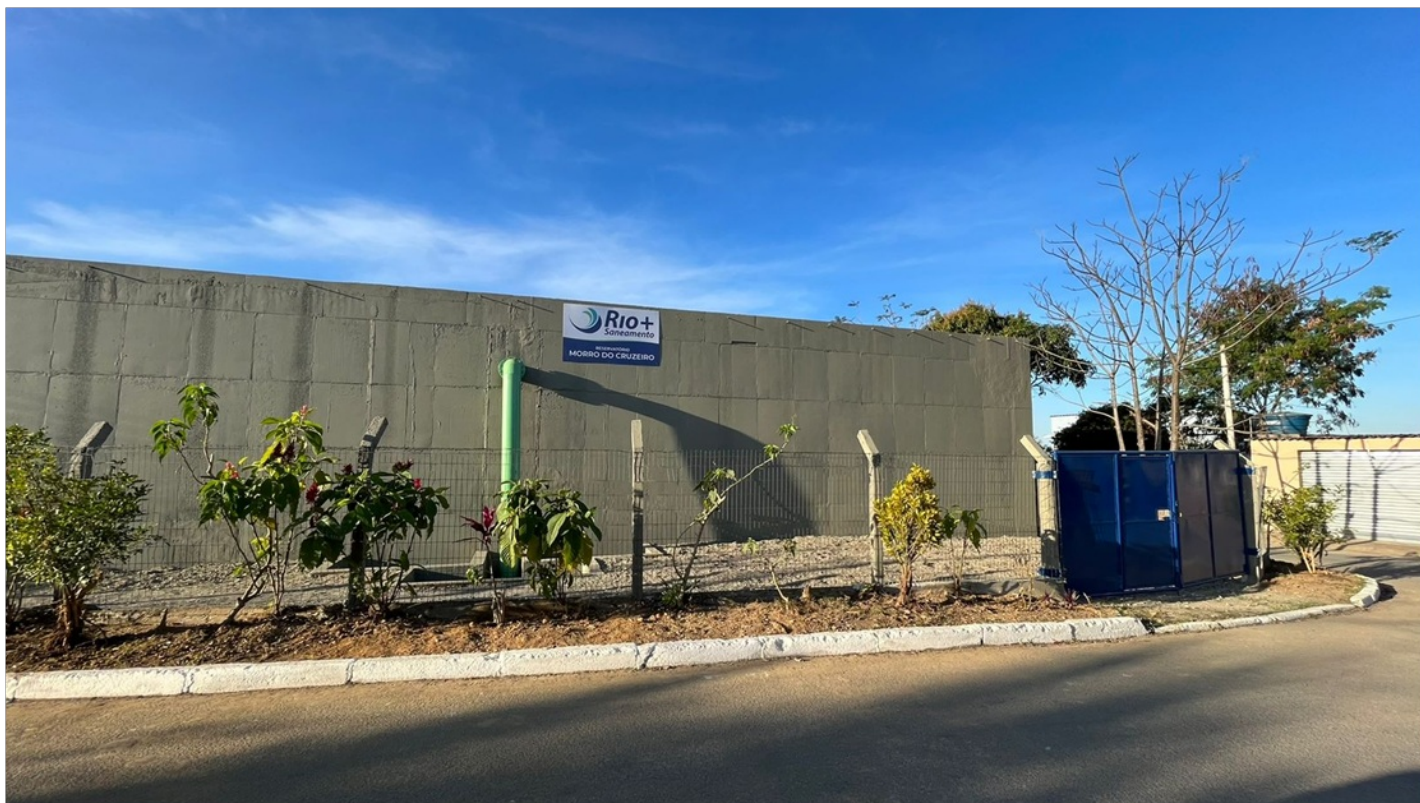
Foto 07 – Reservatório reformado recentemente.
