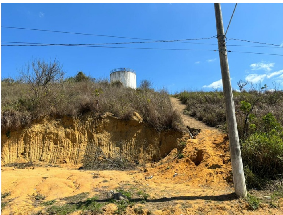
Foto 04 – Acesso ao Reservatório, feito por trilho em meio a vegetação.
