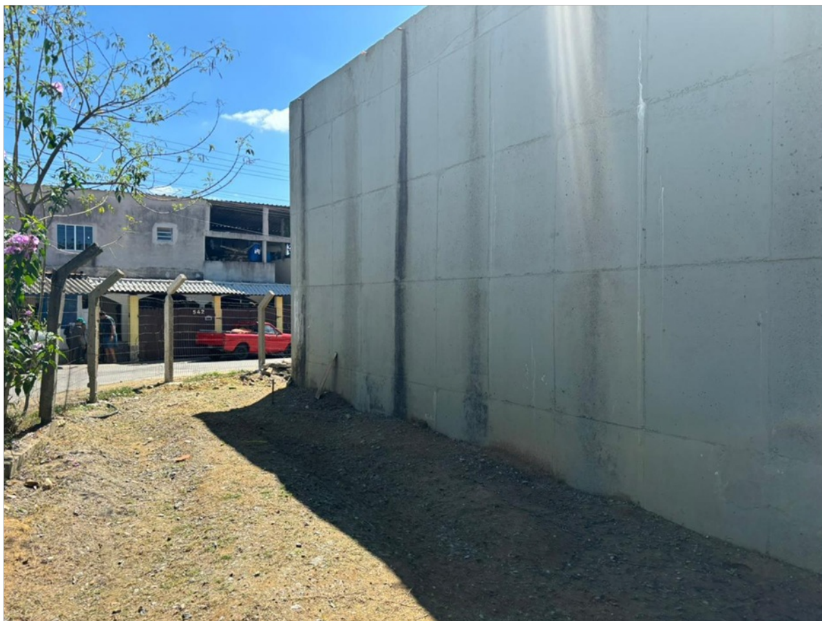
Foto 09 – Cercamento feito com mourões de concreto e tela alambrado.
