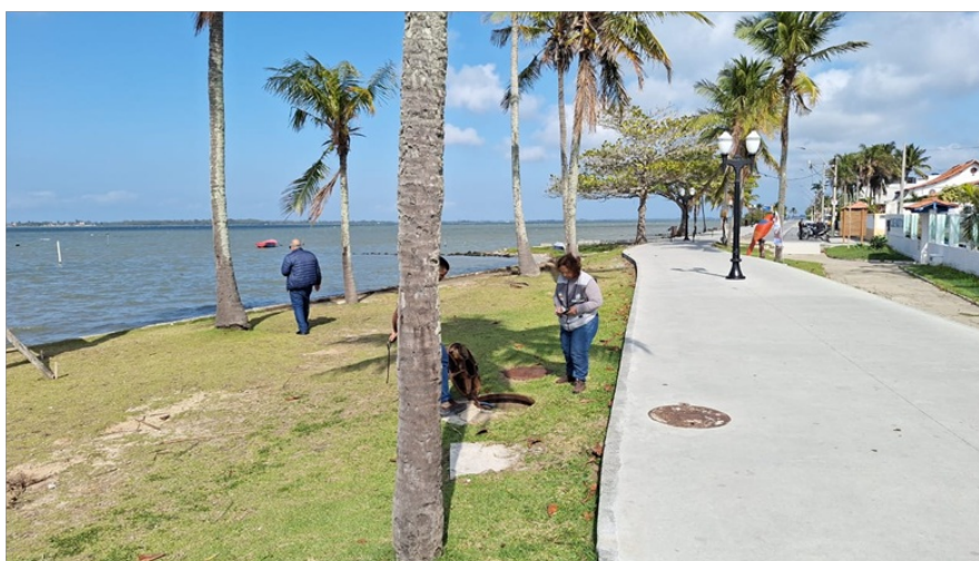
Foto 3 – Abertura do poço da EEE para verificação.
