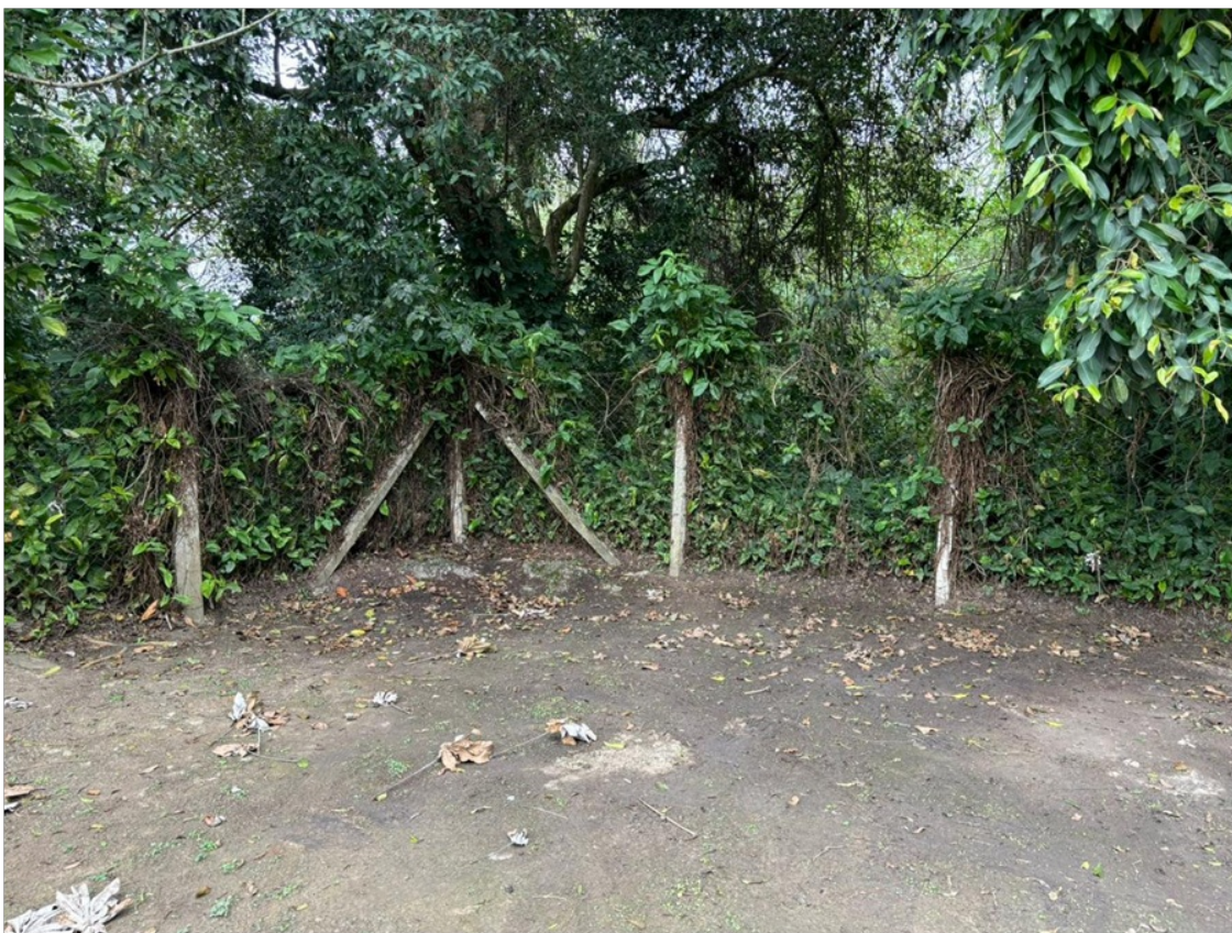
Foto 10 - Cercamento feito com mourões de concreto e alambrado, encontra-se em bom estado de conservação.
