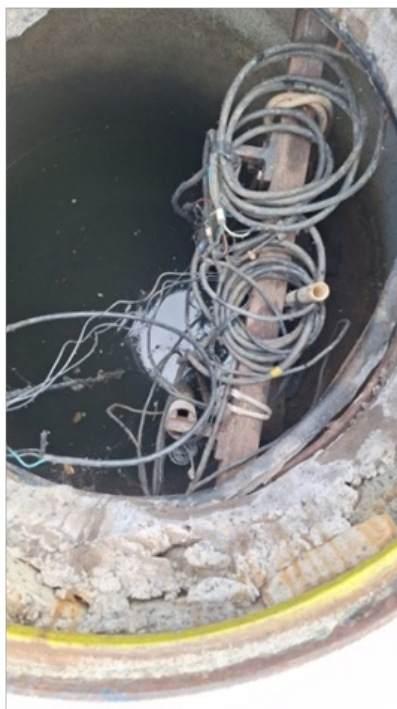
Foto 5 – Poço da EEE Dinossauro.
