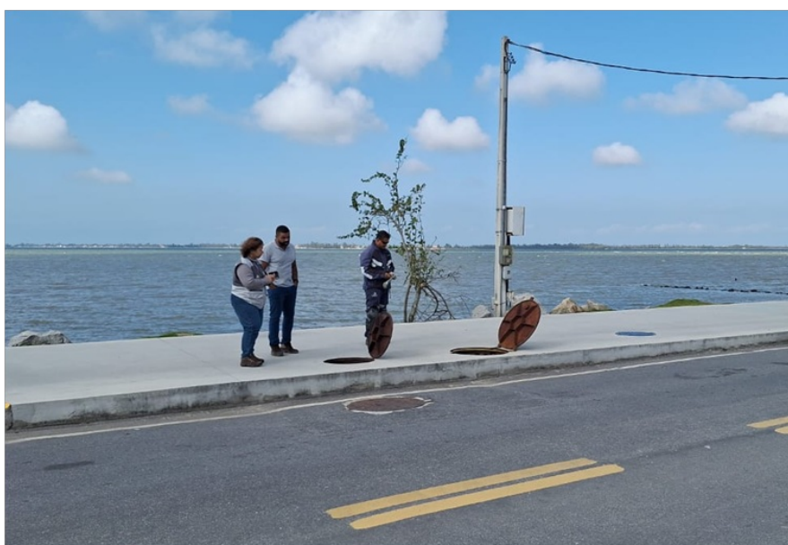
Foto 2 – Vista externa da EEE Kait Surf.
