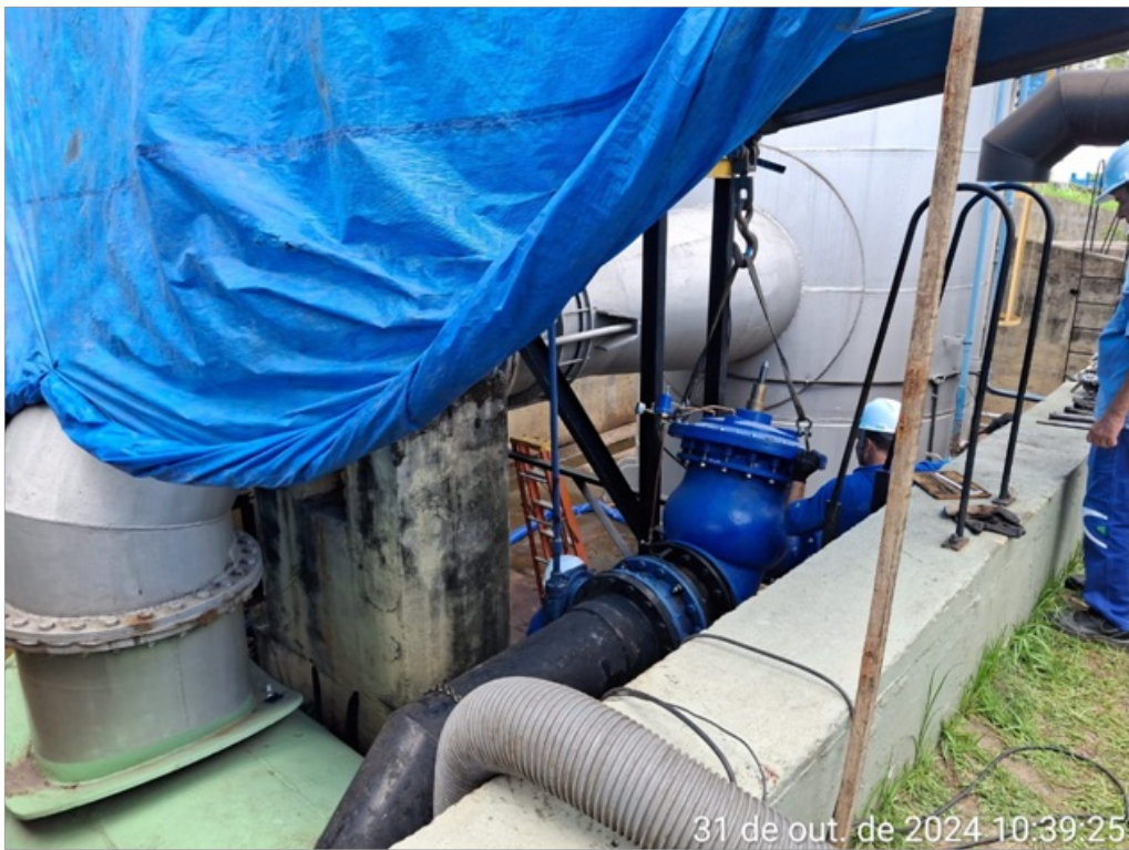
Foto 2 – Válvula antecipadora de ondas do tanque pulmão (Anexo – Item 9)
