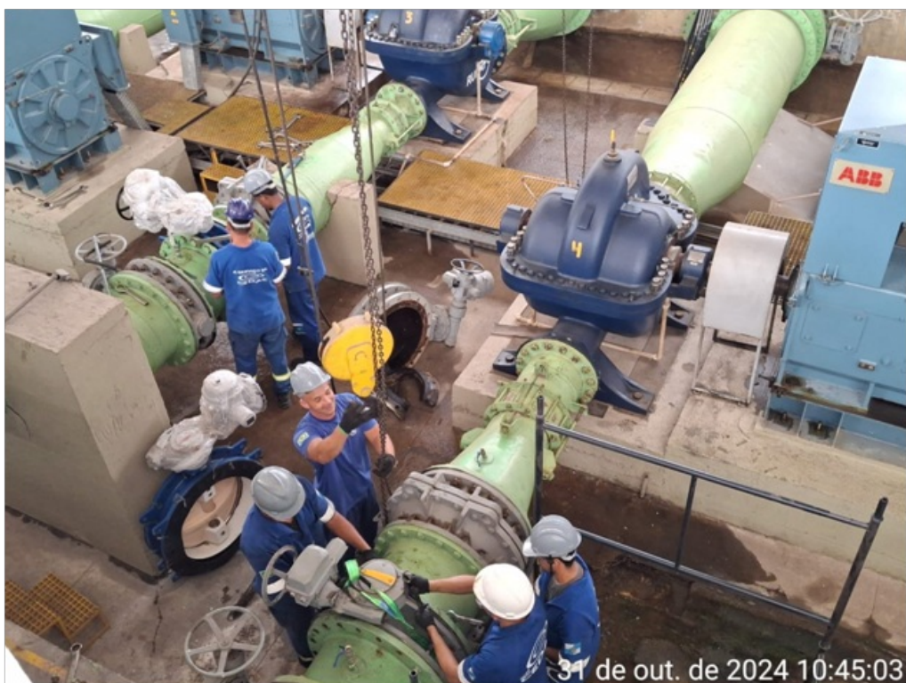
Foto 4 – Instalação de válvulas DN 600 bombas elevatória 1 (Anexo – Item 14)
