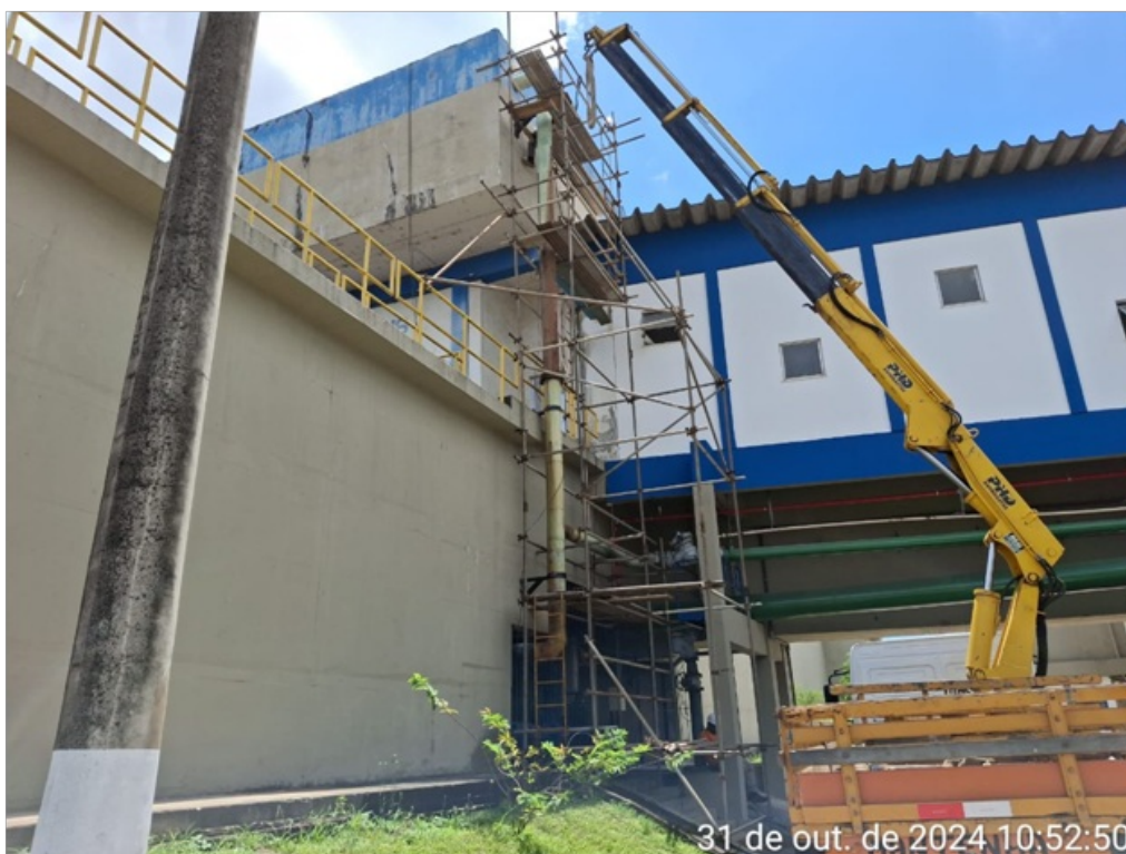
Foto 6 – Substituição tubulação de recalque DN 250 reservatório lavagem dos filtros ETA 3 (Anexo – Item 27)
