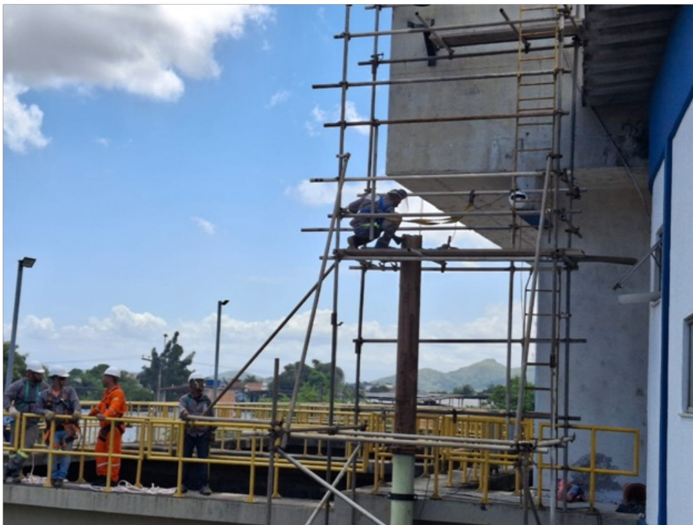
Foto 8 – Execução substituição de tubulação de recalque
