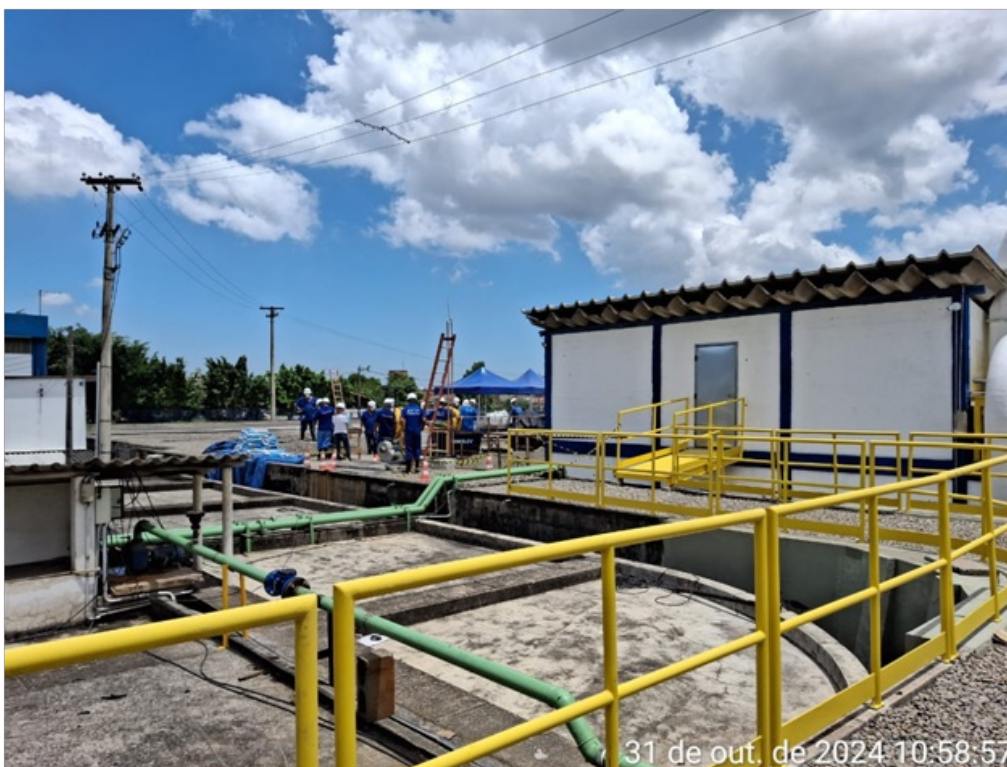
Foto 9 – Execução revestimento piso caixa de contato
