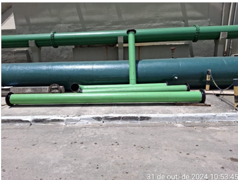
Foto 7 – Tubulação DN 250 para substituição
