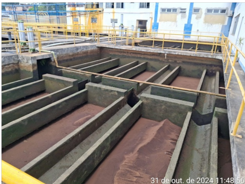
Foto 16 – Filtros durante a manutenção ETA 2
