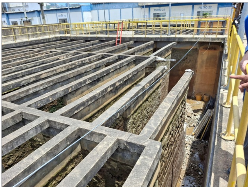
Foto 15 – Floculadores em obra ETA 3
