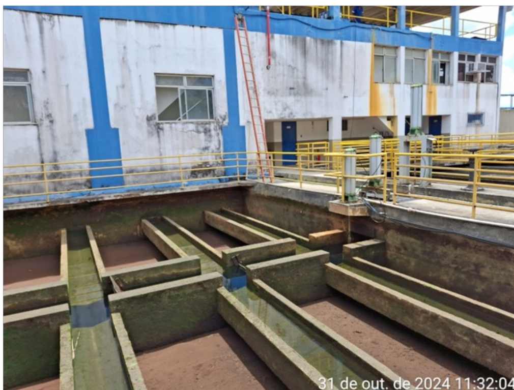
Foto 19 – Filtros durante a manutenção ETA 2
