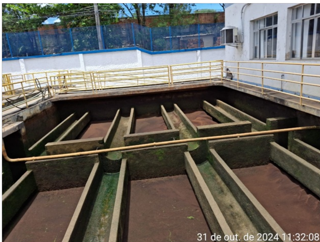
Foto 17 – Filtros durante a manutenção ETA 1
