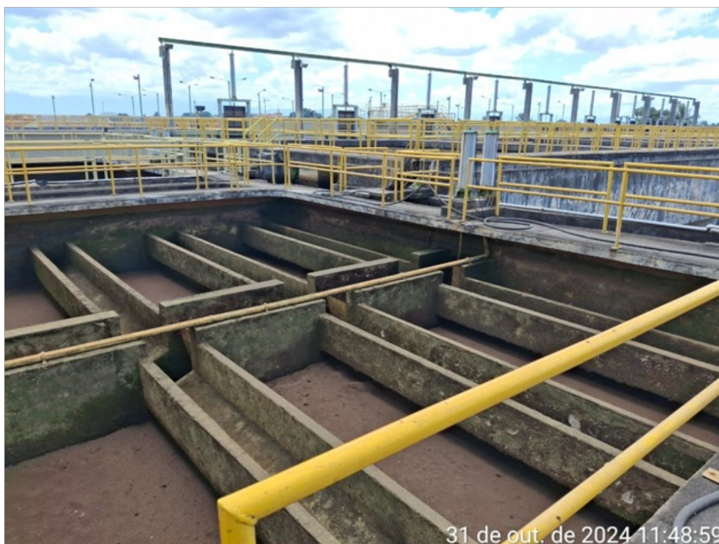
Foto 18 – Filtros durante a manutenção ETA 3
