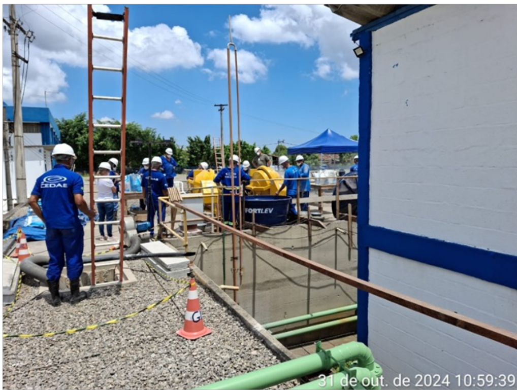
Foto 10 – Execução revestimento piso caixa de contato (Anexo – Item 34)
