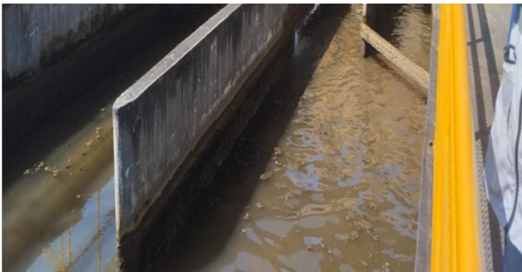
Foto 11 - Revisão e limpeza das estruturas da ETA
