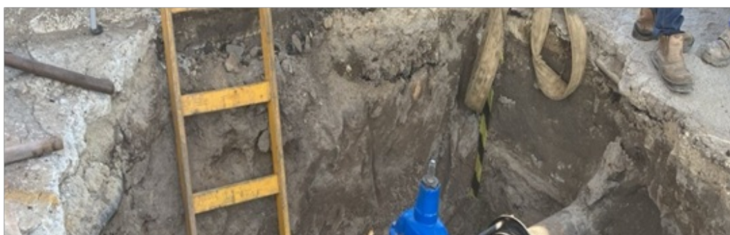
Foto 9 - Substituição de uma válvula borboleta com atuador elétrico DN-600 no grupo 6 da Elevatória Laranjal 1
