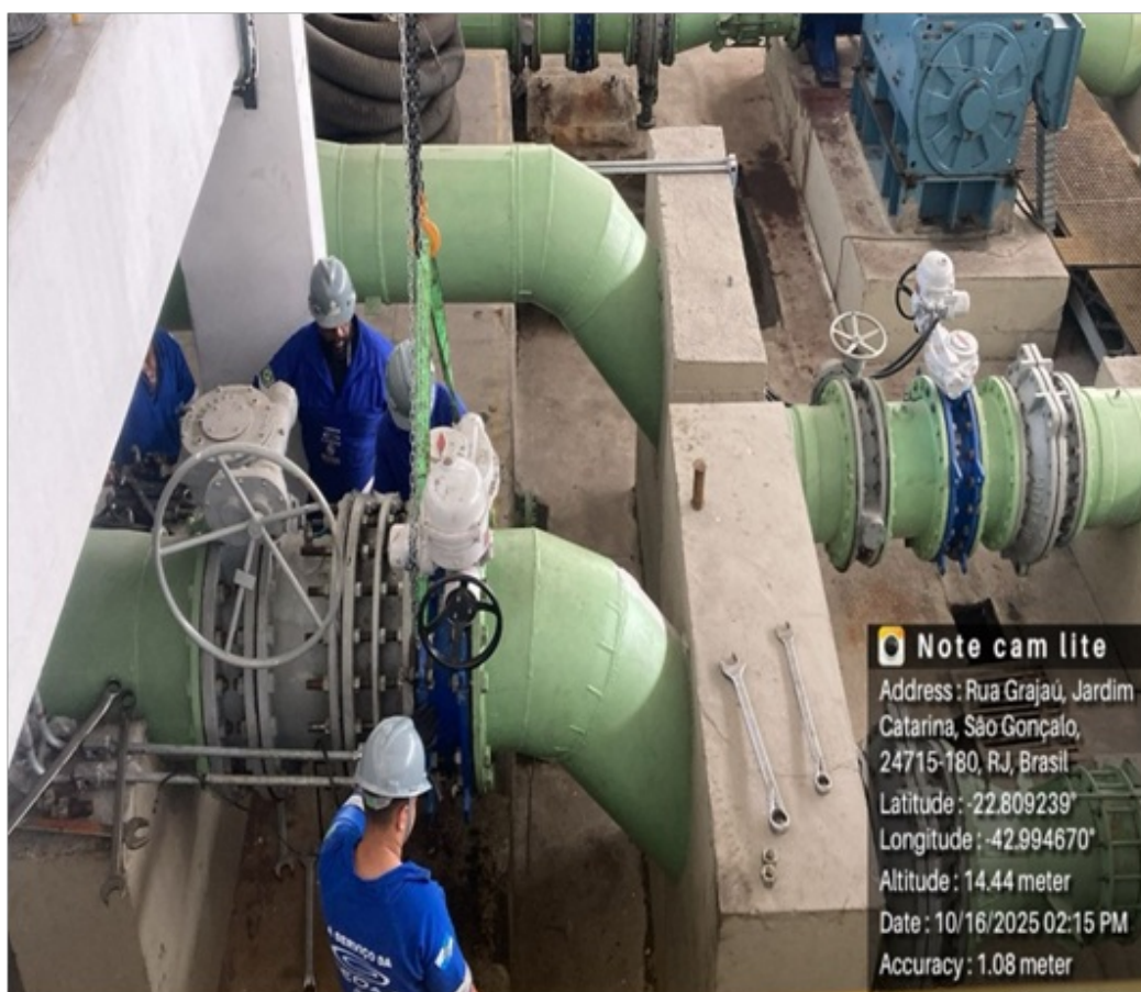
Foto 9 - Substituição de uma válvula borboleta com atuador elétrico DN-600 no grupo 6 da Elevatória Laranjal 1
