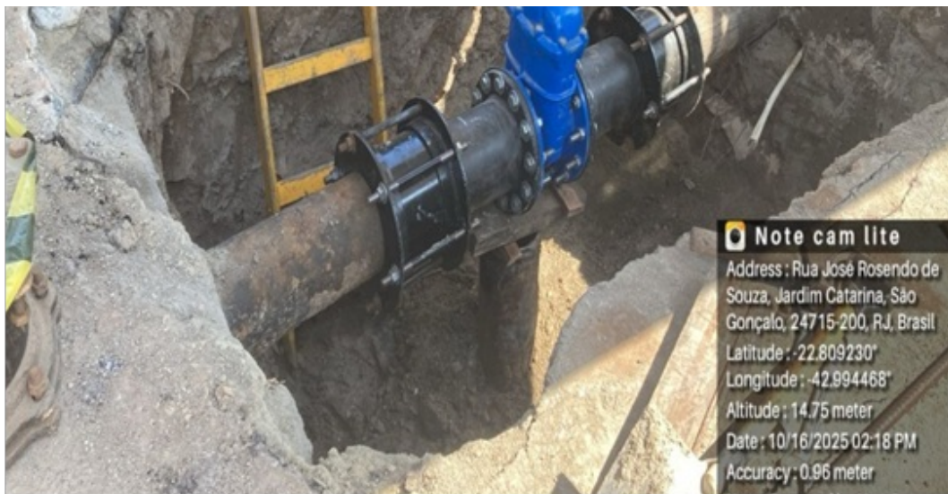
Foto 10 - Instalação de válvula gaveta DN 200, saída do DN 2000 tomada de serviços ETA
