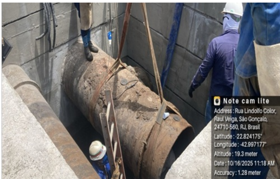
Foto 3 - Local a ser instalado o macro medidor 5ª linha adutora DN1000
