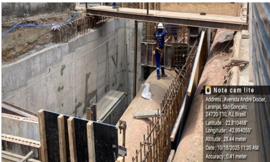
Foto 5- Local que seria instalado o maço medidor DN 2000
