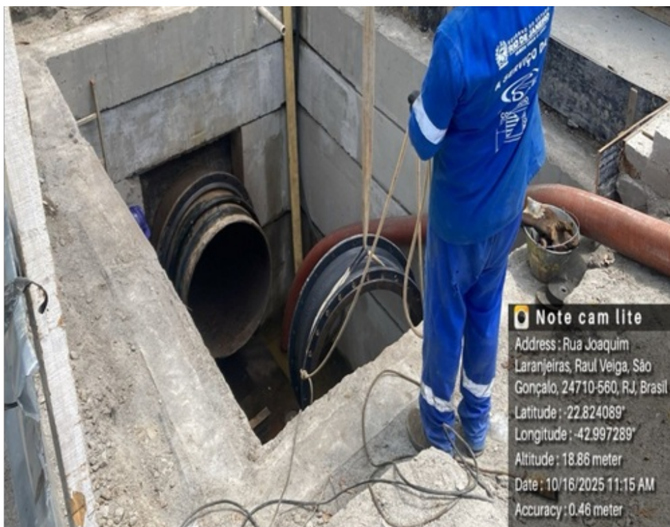
Foto 1 – Local a ser instalado o macro medidor 4ª linha adutora DN1000
