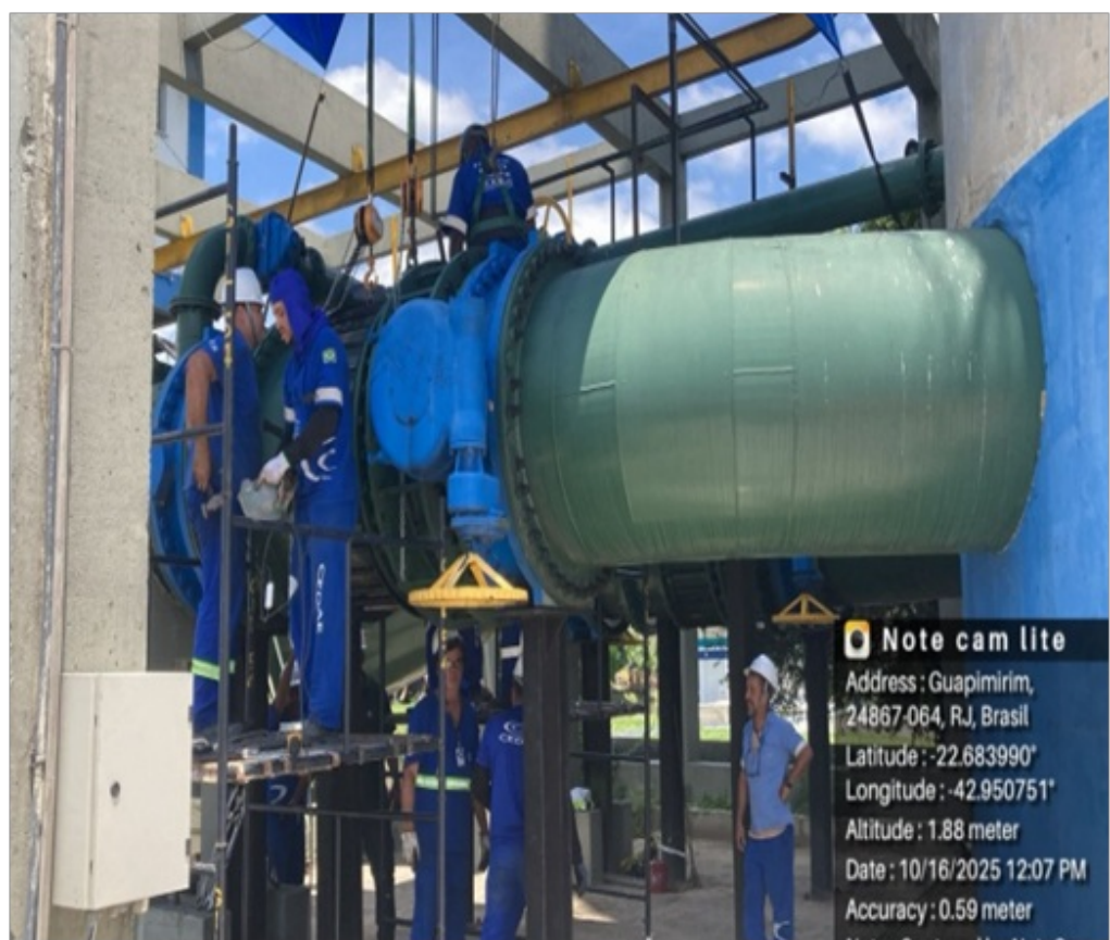
Foto 6 – Substituição das juntas de uma das válvulas de retenção DN – 1200 do TAU da EEAB Imunana
