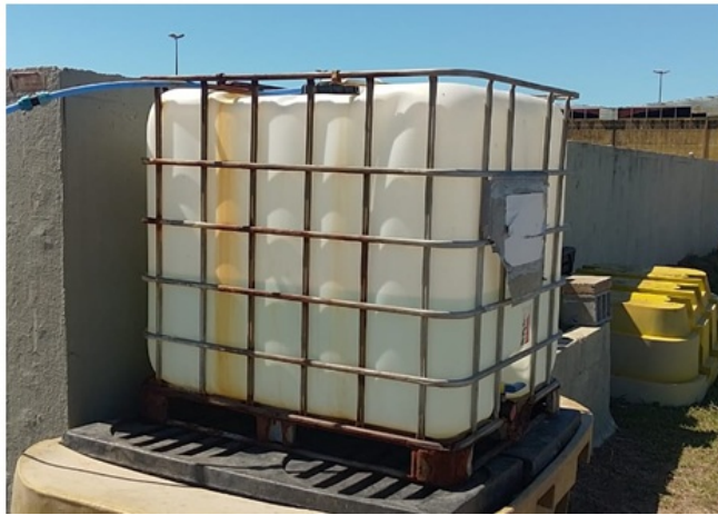
Foto 11 e 12 – Tanque de hipoclorito de sódio com baia de contenção; Dosadores operando para desinfecção do efluente tratado.
