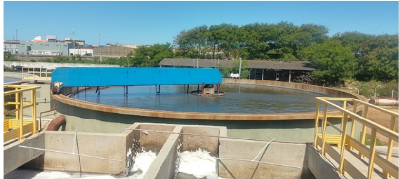
Foto 7 e 8 - Dosagem de PAC para formação de flocos ; Decantador onde os flocos sedimentam e são removidos.
