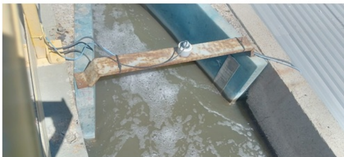
Foto 3 e 4 - Módulo de tratamento preliminar; Módulo que seria içado posteriormente sobre o pipe-rack.
