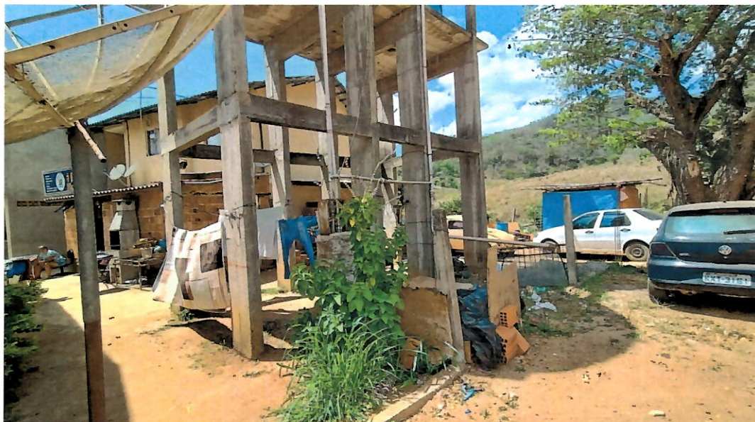
Foto 5 : Área sob o reservatório sendo utilizada por moradores.
