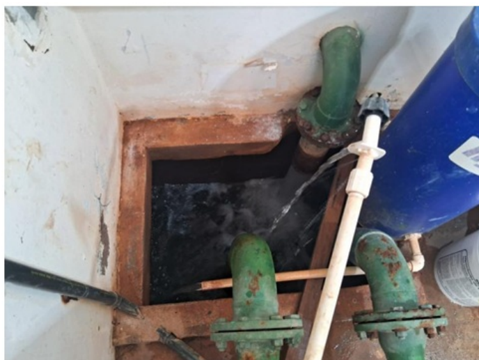
Foto 13: visita do reservatório enterrado e ponto de aplicação do cloro
