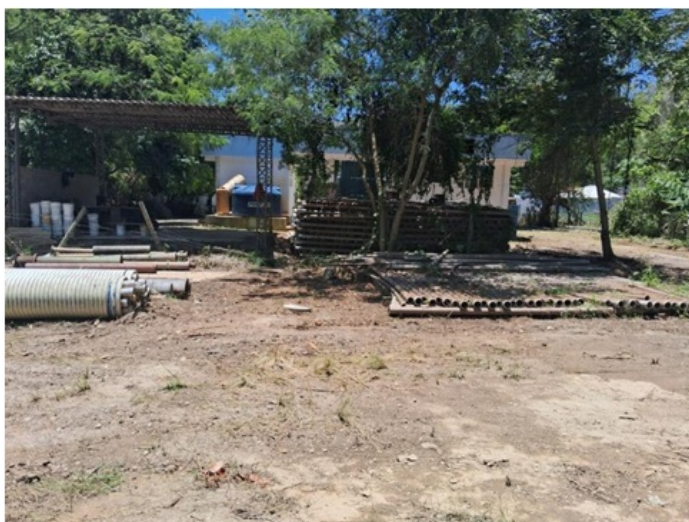
Foto 7: Área do terreno usada como depósito de materiais hidráulicos.
