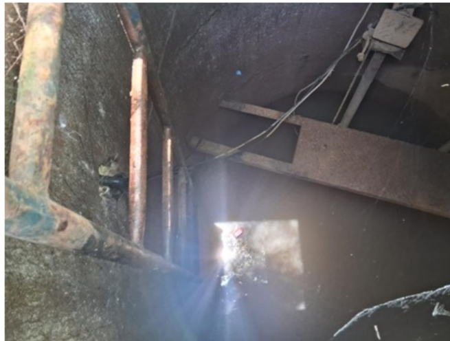
Foto 3: Vista do interior do poço de captação.
