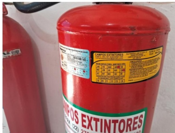
Foto 18: Extintor de incêndio fora da validade.
