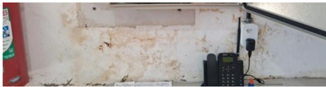
Foto 16: Vista interna do painel elétrico da Casa de Bombas.
