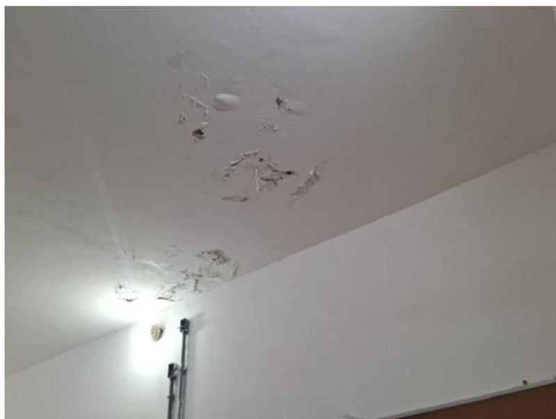
Figura 14: vista da laje do reservatório elevado da retrolavagem (teto do laboratório), que apresenta infiltração de água, inclusive com gotejamento no laboratório.
