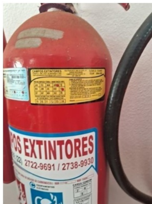
Figura 24: extintor de incêndio fora da validade.
