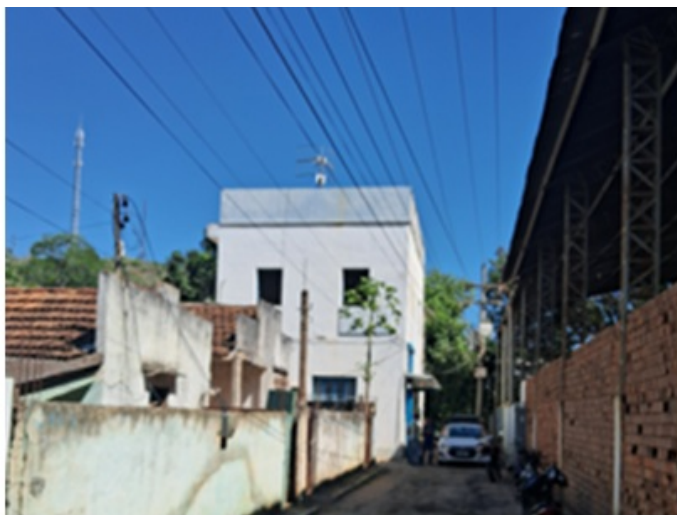
Foto 1: fachada lateral da ETA. Nota-se que a placa de identificação não está mais legível.
