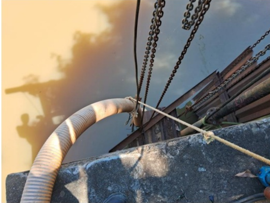
Foto 4: detalhe das tubulações de tomada de água.
