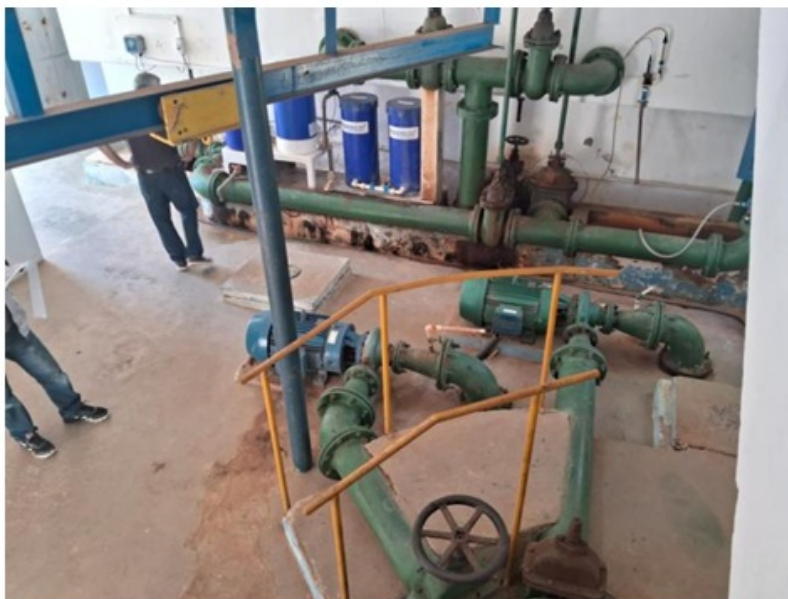
Figura 18: vista da área onde ficam a estação elevatória, o sistema de desinfecção e barrilete do filtro .
