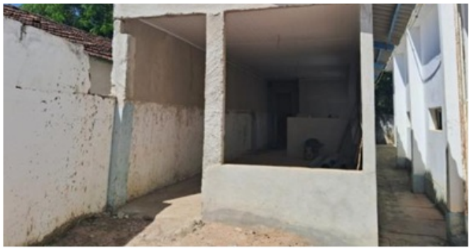
Figura 25: obra de nova loja de atendimento, que estava paralisada.
