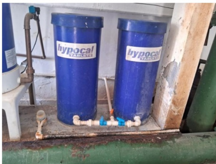
Figura 17: sistema de ajuste manual que estava operando em substituição ao automatizado. Destaca-se a maior imprecisão, insegurança e ineficiência desse sistema em relação ao automático.
