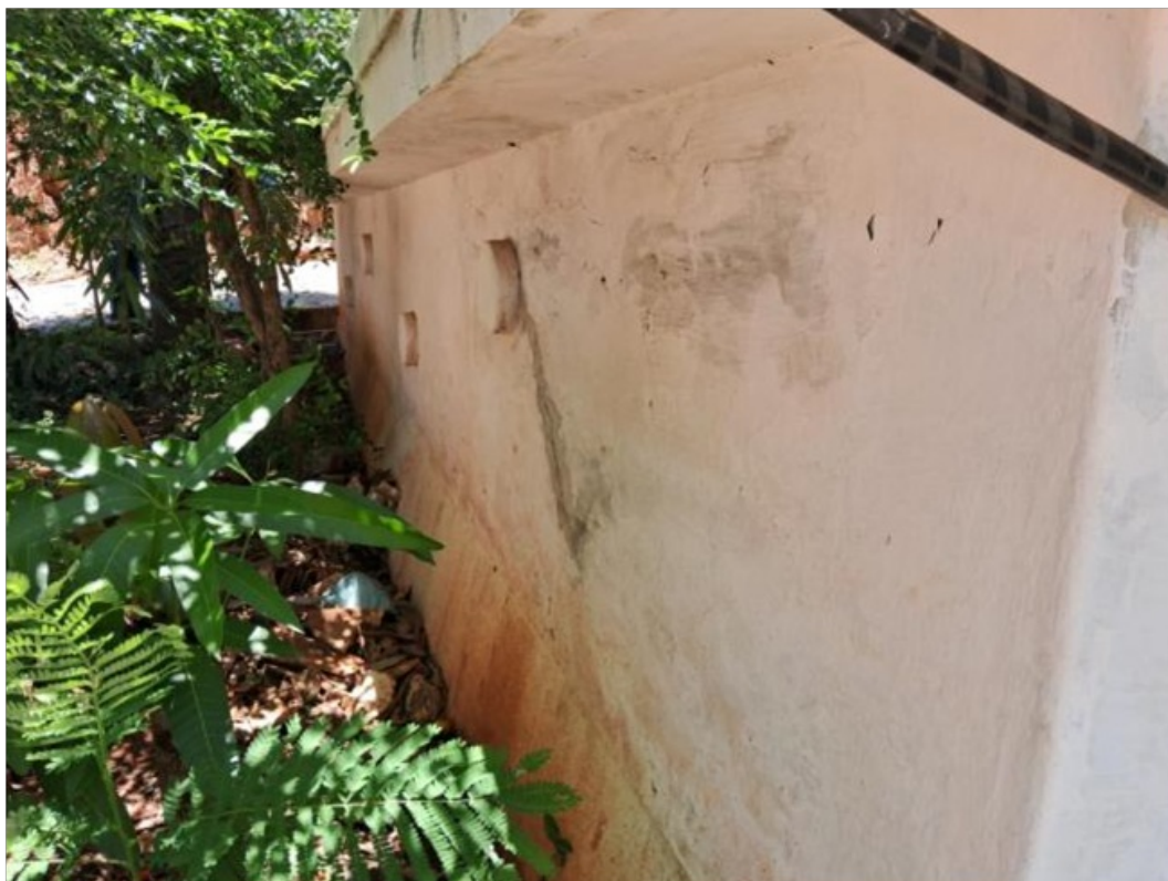
Foto 2: Vista da lateral direita do reservatório.
