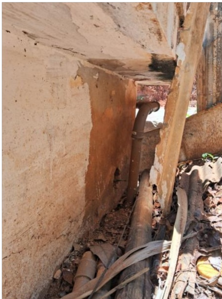
Foto 4: Vista da lateral esquerda do reservatório. Nota-se tubulação metálica que recalca água do reservatório para comunidade que mora em área a cima. Foi informado que a operação do abastecimento dessa comunidade é feito pela prefeitura.
