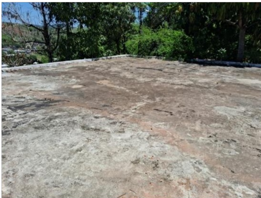
Foto 1: Vista superior da laje do reservatório.
