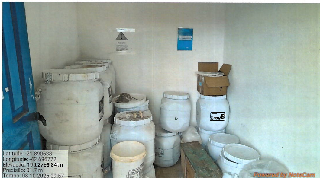
Foto 28: Armazenamento inadequado de hipoclorito de cálcio.
