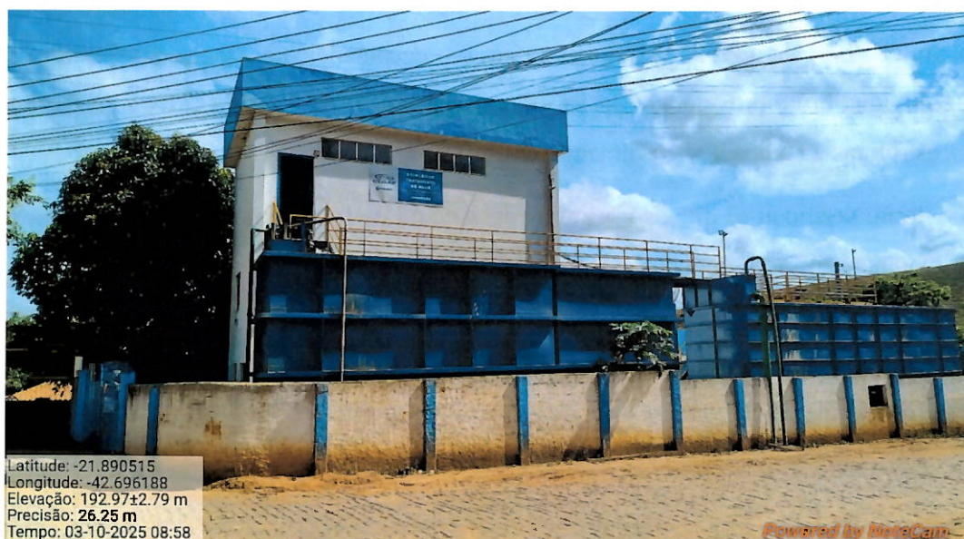
Foto 9: Fachada da ETA.
