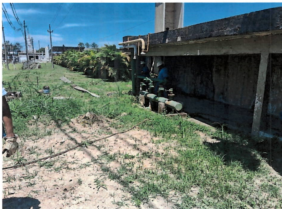
Foto 5: Equipe realizando troca de barrilete ao lado do tanque de floculação da VETA.
