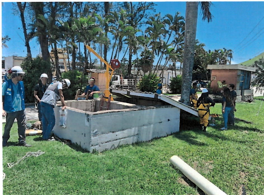
Foto 8: Equipe, estrutura e equipamentos montados para inspeção no Canal da Zona Rural.
