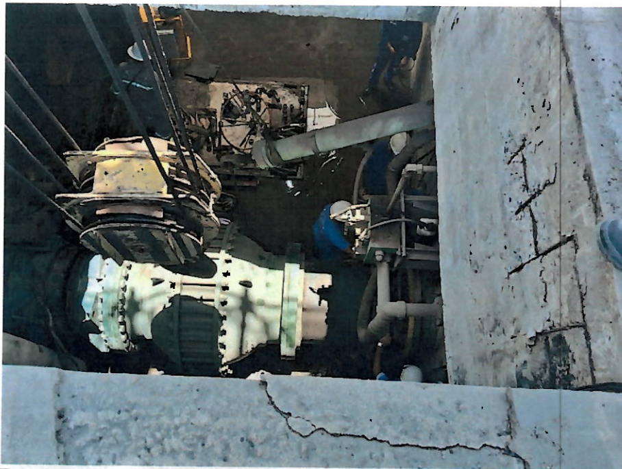
Foto 6: Reparo sendo realizado na tubulação de recalque de um dos CMBs do NARG.
