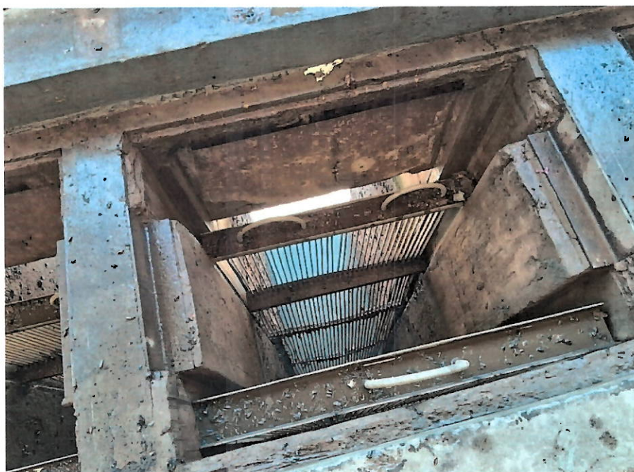
Foto 13: Uma das grandes após a limpeza.
