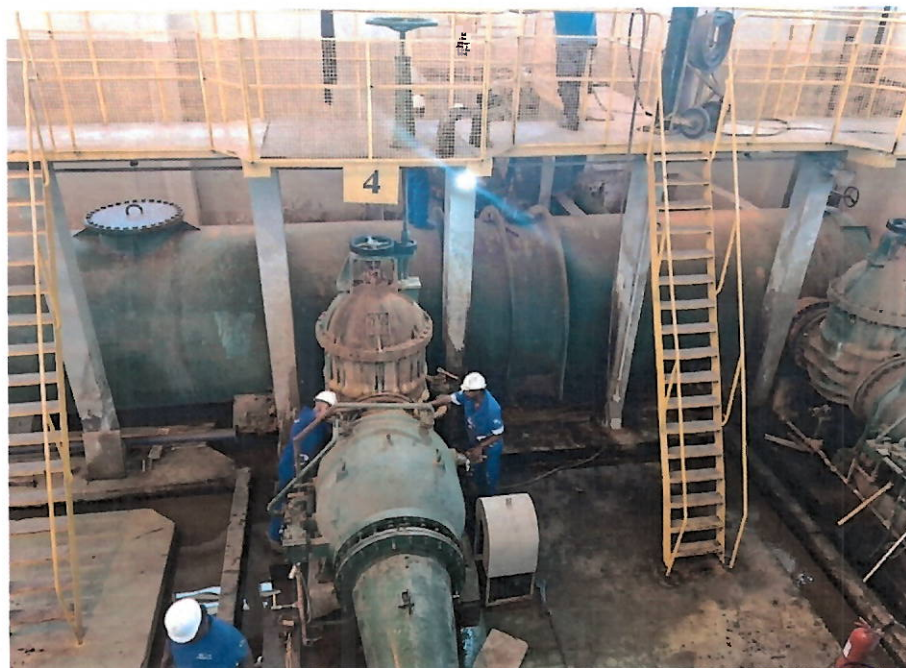
Foto 9: Reparos sendo realizado no conjunto 4 do ARG.
