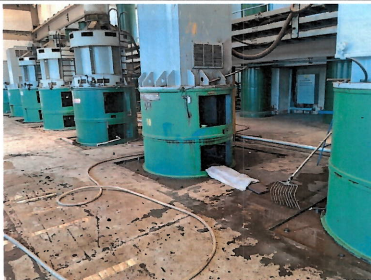
Foto 12: Conjunto motobomba que estava passando por manutenção no BRG.
