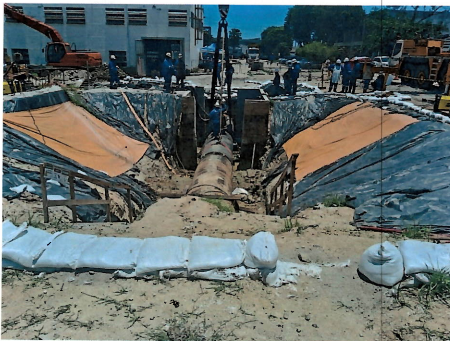
Foto 10: Trecho 1 da obra para instalação de válvulas nas linhas de água tratada, para viabilizar futura instalação de macromedidor.
