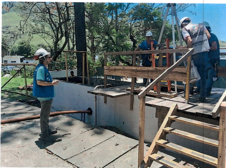
Foto 7: Equipe, estrutura e equipamentos montados para inspeção no Canal da Zona Rural.
