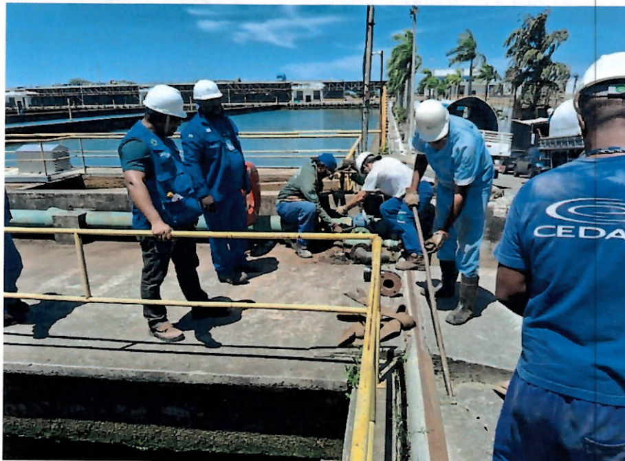
Foto 3: Equipe realizando a troca de registro no final da linha de 200 de pressão entre o decantador e o floculador da VETA
