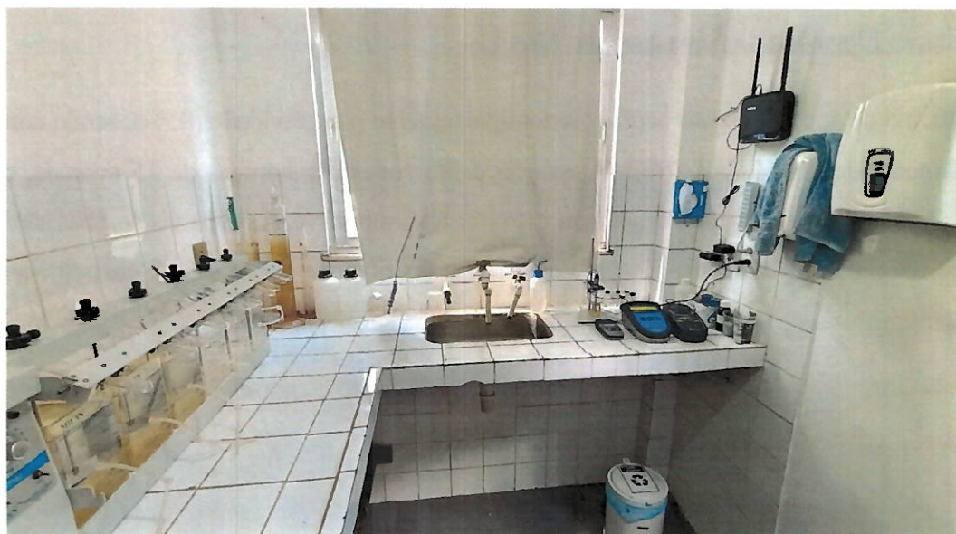
Foto 13: Laboratório da ETA.
