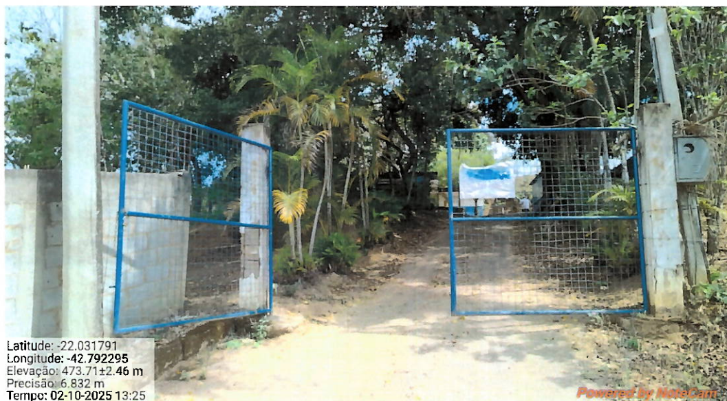
Foto 4: Entrada da ETA.
