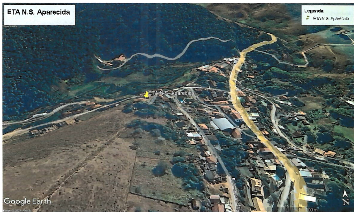
Imagem 1: Localização da ETA N.S. Aparecida ( 22^{\circ} 1'53.95''S 42^{\circ}47'32.22''O ).
