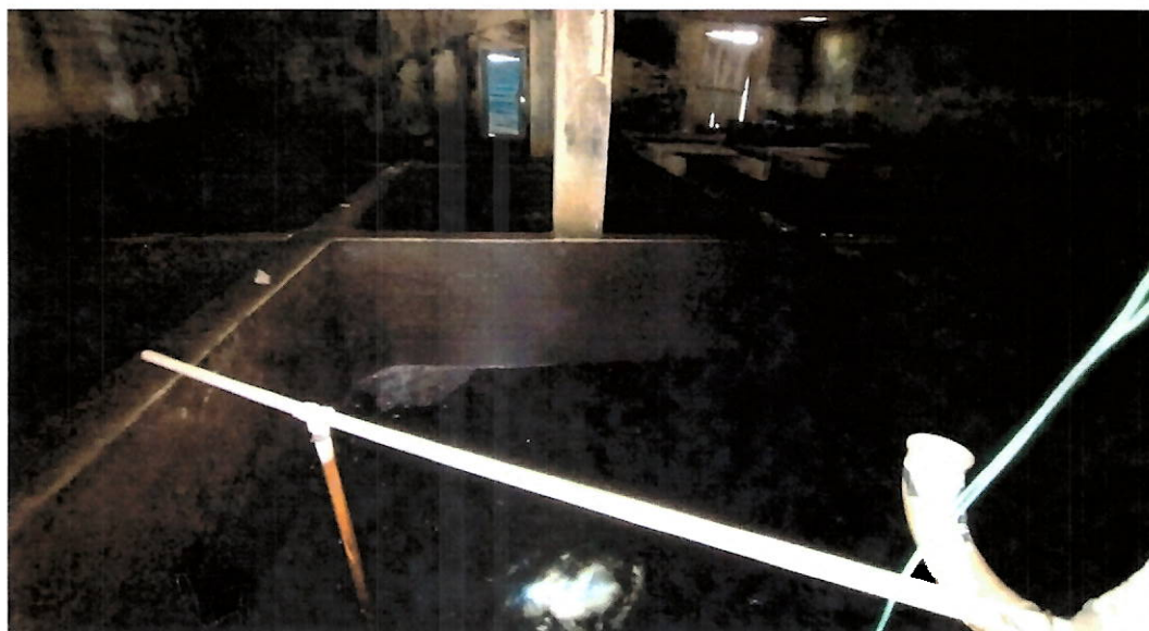
Foto 11: Interior do reservatório de água tratada
