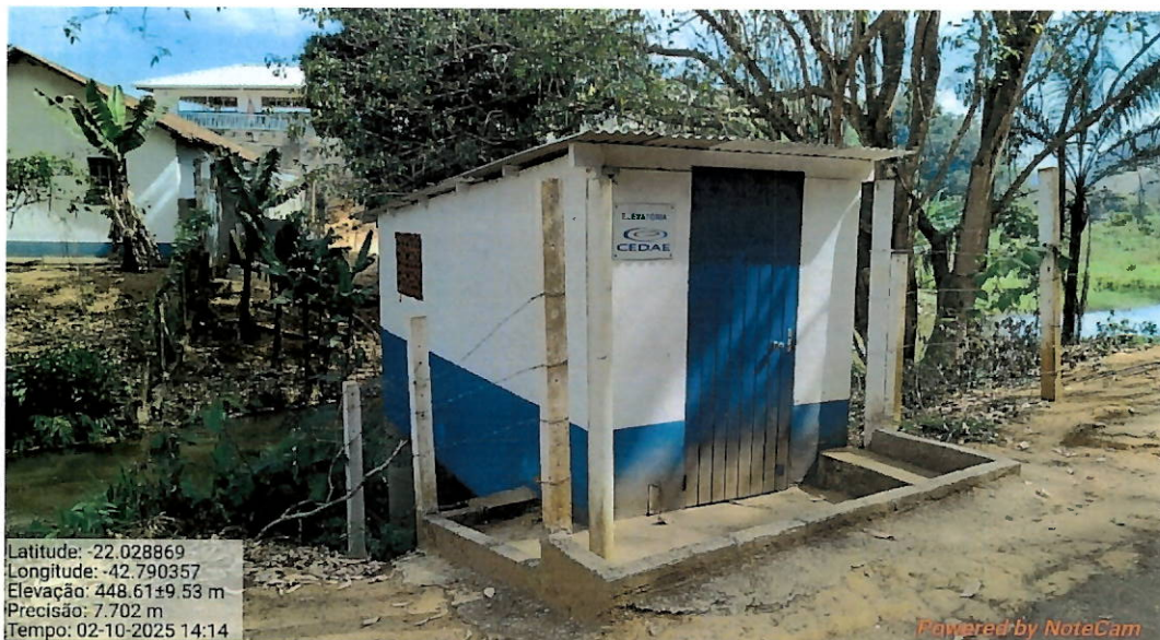
Foto 2: Estação Elevatória de água Bruta.
