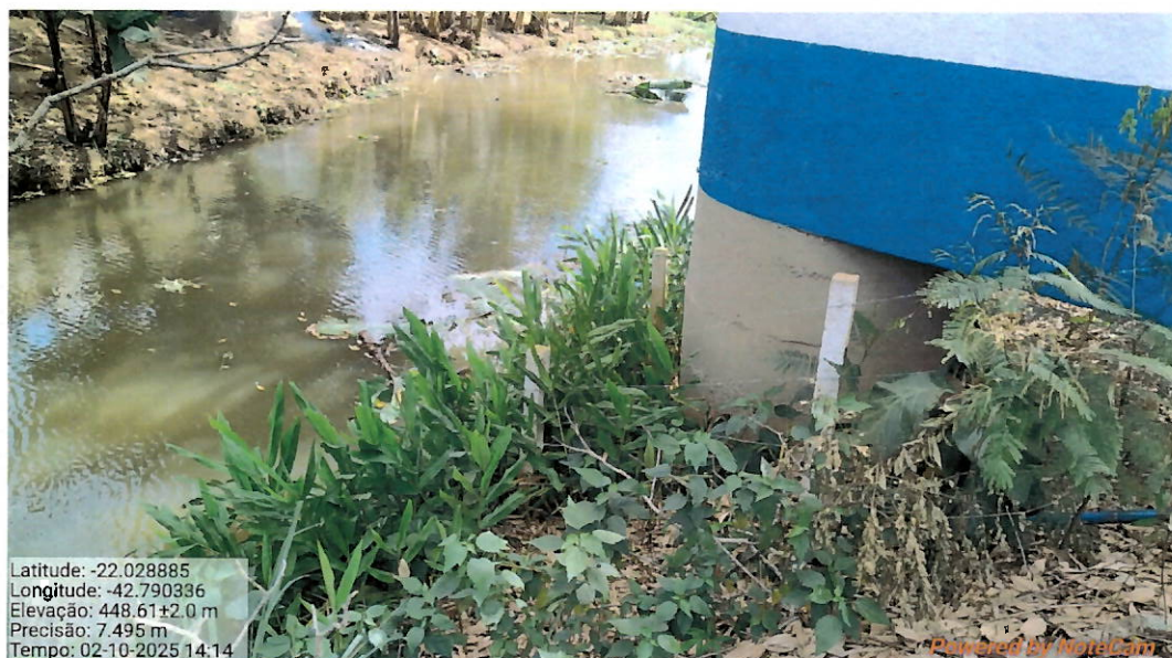
Foto 1: Ponto de captação – Rio Santa Rita (ausência de placa de identificação do manancial, com aviso indicando que o mesmo é utilizado para o abastecimento humano) .
