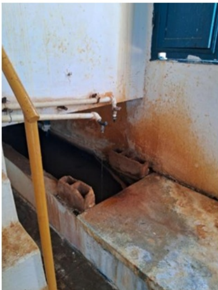
Foto 7: ponto de aplicação de coagulante. Nota-se que não há dispositivo de medição da dosagem de aplicação.
