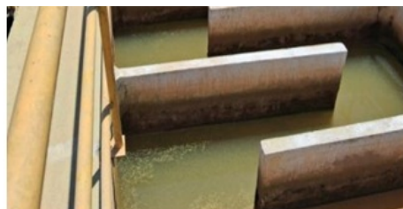
Foto 10: vista superior, de jusante para montante, do tanque de floculação.
