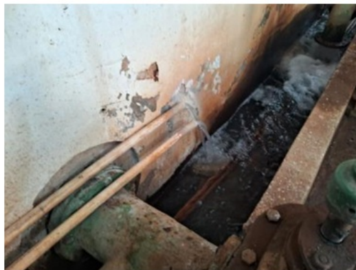
Figura 18: Ponto de aplicação da solução de hipoclorito de cálcio na água pós-filtração.
