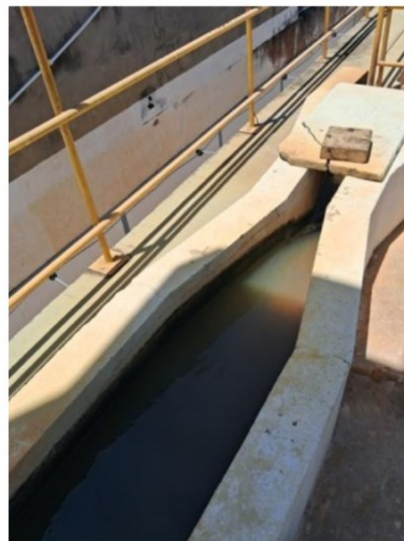
Foto 8: Calha Parshall utilizada na coagulação.
