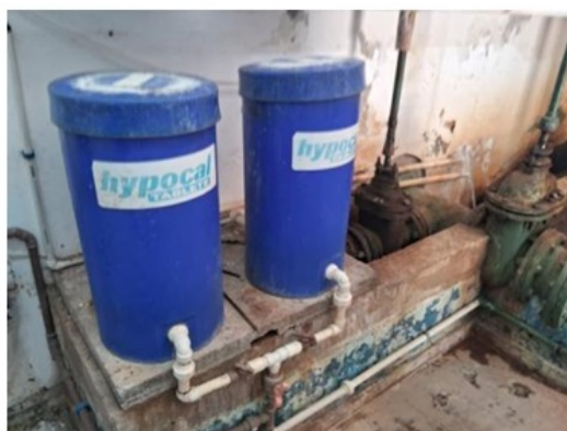
Figura 20: sistema de ajuste manual que estava operando em substituição ao automatizado. Destaca-se a maior imprecisão, insegurança e ineficiência desse sistema em relação ao automático.
