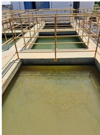
Foto 12: vista superior dos tanques de decantação, de montante para jusante.
