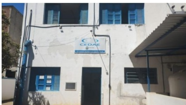
Foto 1: fachada da ETA.
