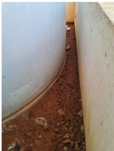
Figura 31: detalhe de resíduos de sulfato de alumínio acumulados no tanque de contenção devido a extravasamento.
