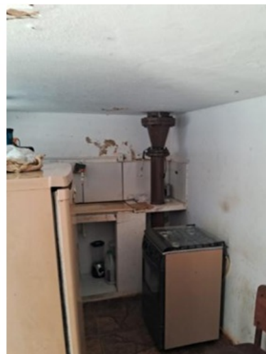
Figura 42: copa dos funcionários em instalação inadequada.
