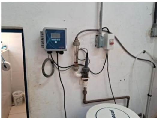
Figura 19: vista do sistema automatizado de medição e controle da dosagem. Esse sistema estava inoperante e aguardava conserto por empresa terceirizada segundo informações.
