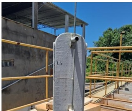
Foto 7: ponto de aplicação de coagulante. Nota-se que não há dispositivo de medição da dosagem de aplicação.
