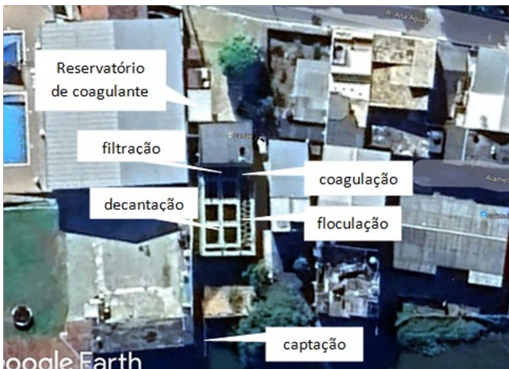
Imagem 2: Vista superior da ETA.
