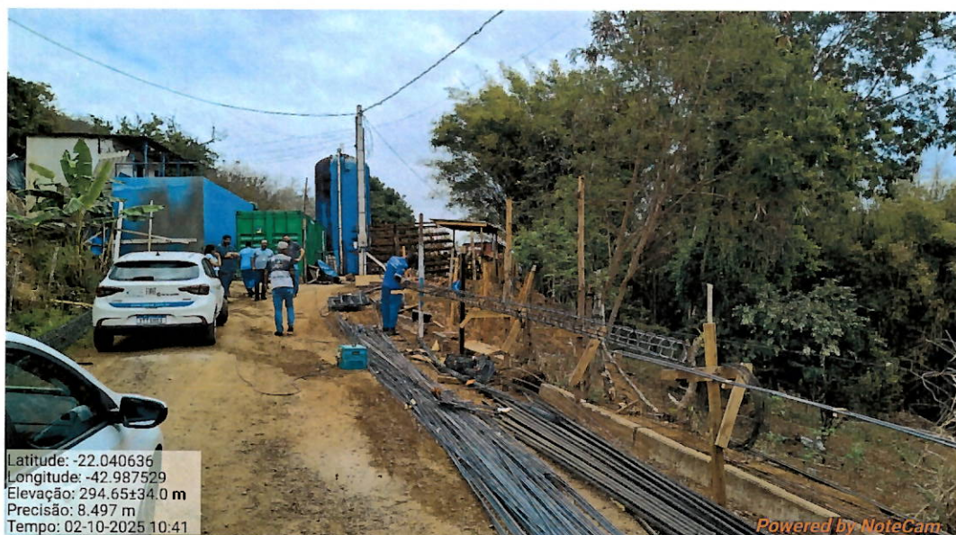
Foto 5: Acesso à ETA.
