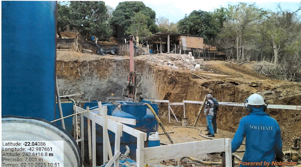
Foto 7: Obras sendo realizadas.
