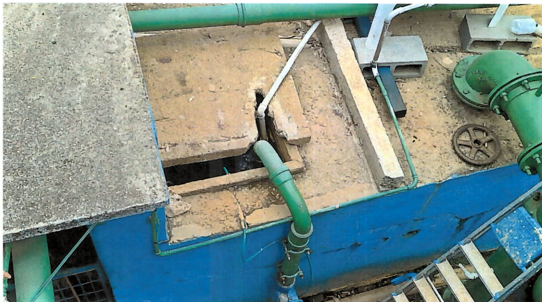
Foto 14: Tampa de inspeção do tanque de contato parcialmente descoberta.
