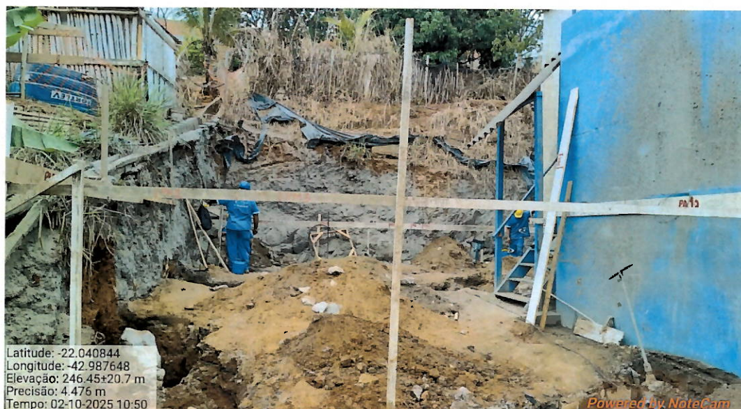
Foto 6: Obras sendo realizadas.
