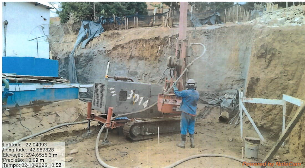
Foto 8: Obras sendo realizadas.
