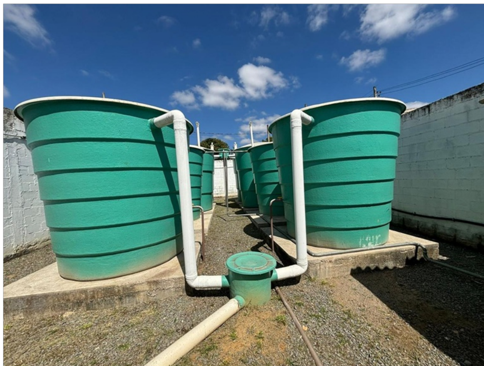
ETE composta por 4 (quatro) Reatores UASB + 2 ( dois ) Biofiltros Aerados Submersos + 2(dois) Decantadores secundários.
