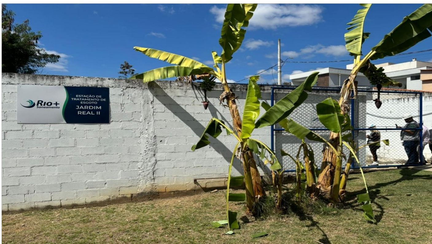
Muro com placa de identificação da Unidade
