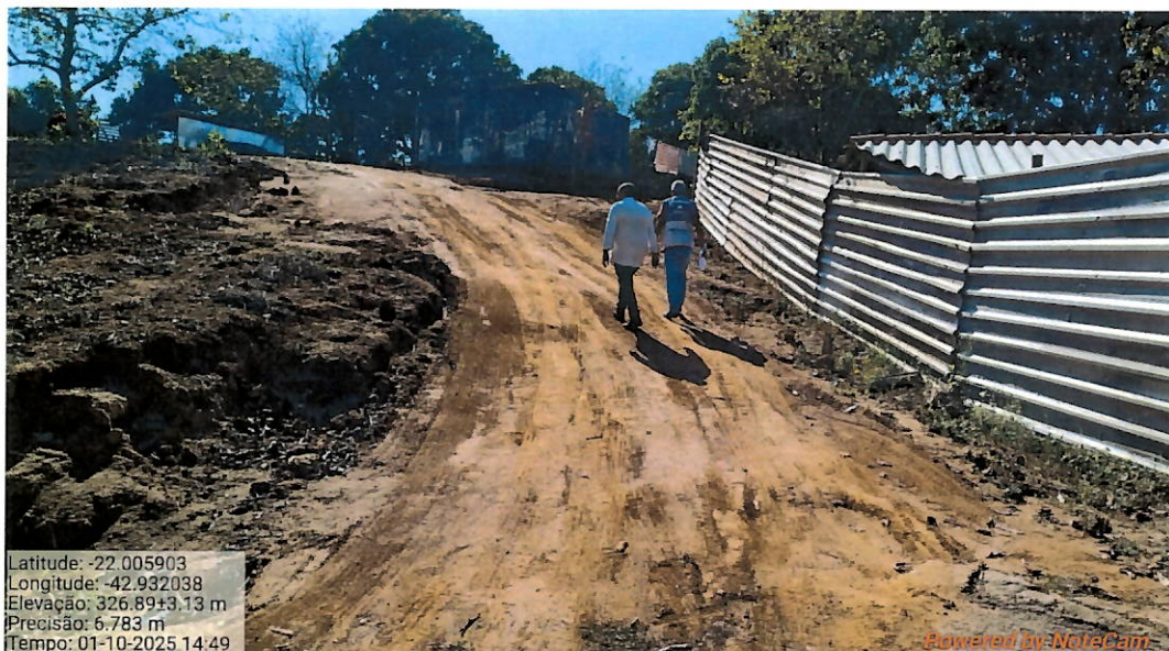
Foto 1: Acesso ao reservatório.
