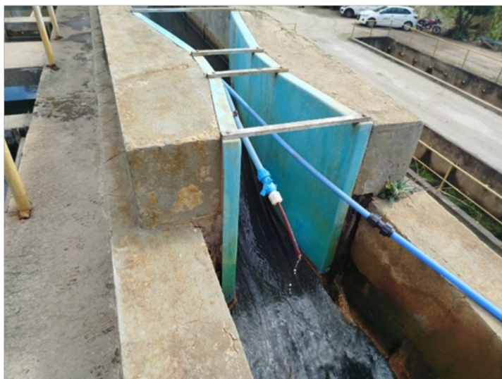
Foto 03–Régua graduada conforme norma
