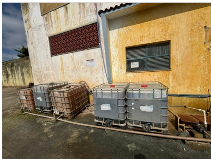
Foto 05 – Bombonas de sulfato sem bacia de contenção.
