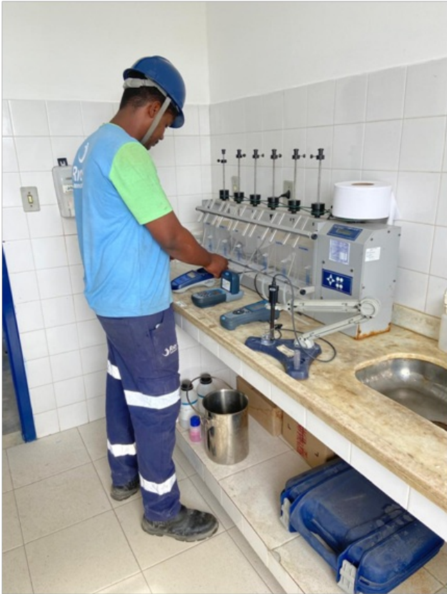
Foto 15 – Laboratório Operacional da ETA.
