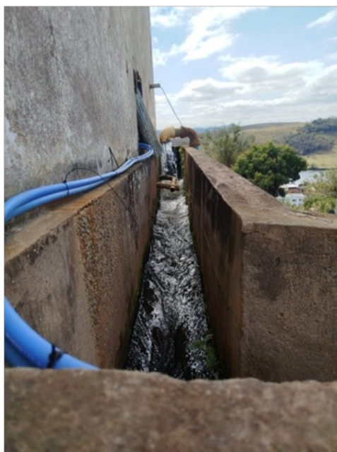
Foto 02 - Canal de chegada da água bruta na ETA
