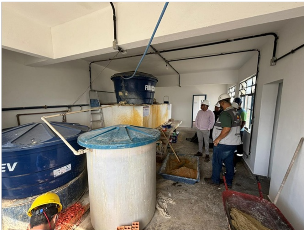
Foto 19 – Casa de química sendo reformada.
