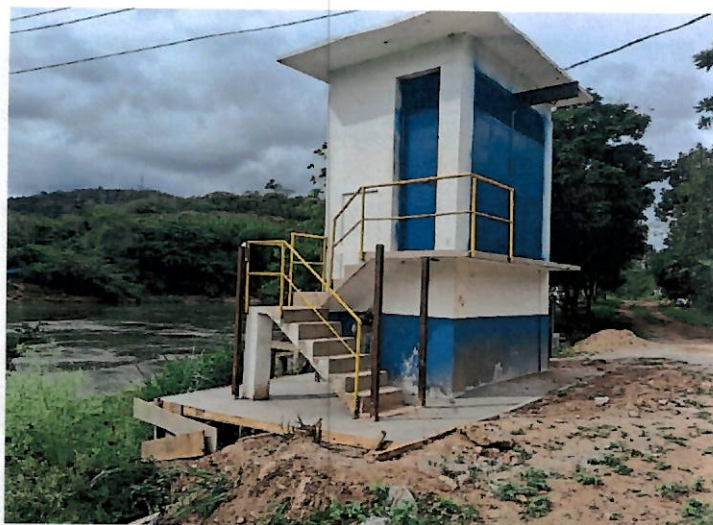
Foto 20: Vista do exterior da casa de bombas da unidade de captação que está em fase final de obras.
