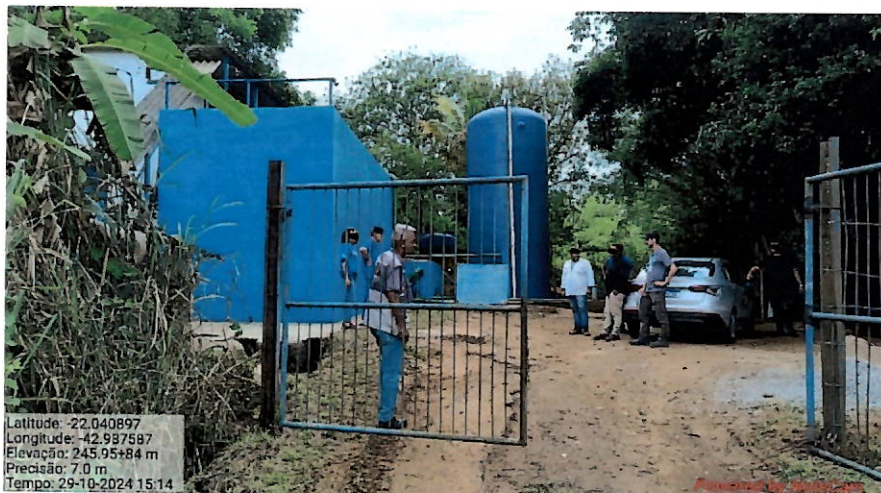
Foto 1: Portão de acesso à ETA (cercada por arame farpado). Destaca-se a necessidade de melhorar e atualizar a placa de identificação.
