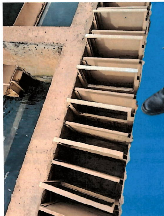
Foto 6: Vista do floculador.
