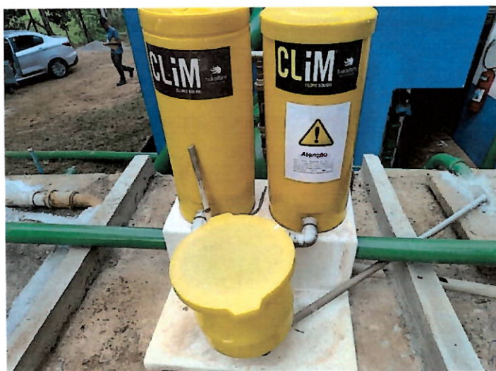
Foto 16: Dispositivo de aplicação de solução hipoclorito de cálcio.
