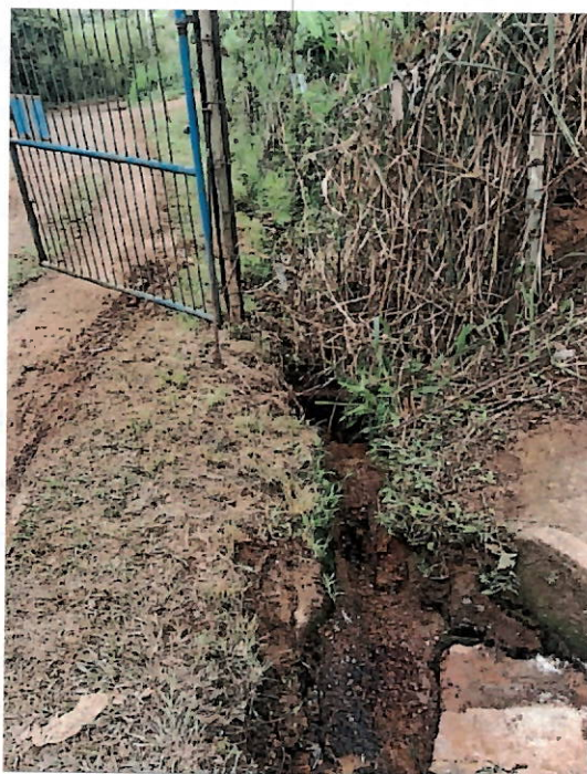
Foto 28: Vista da calha de drenagem onde são lançados os efluentes da estação, que seguem diretamente para rede de drenagem do município.
