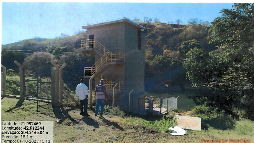
Foto 1: Entrada para o ponto de captação e EEAB (área cercada sem placa de identificação da unidade).
