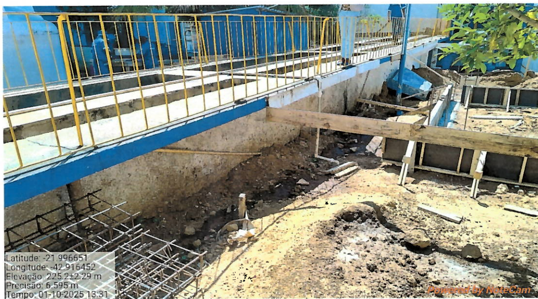
Foto 28: Área externa em obras.
