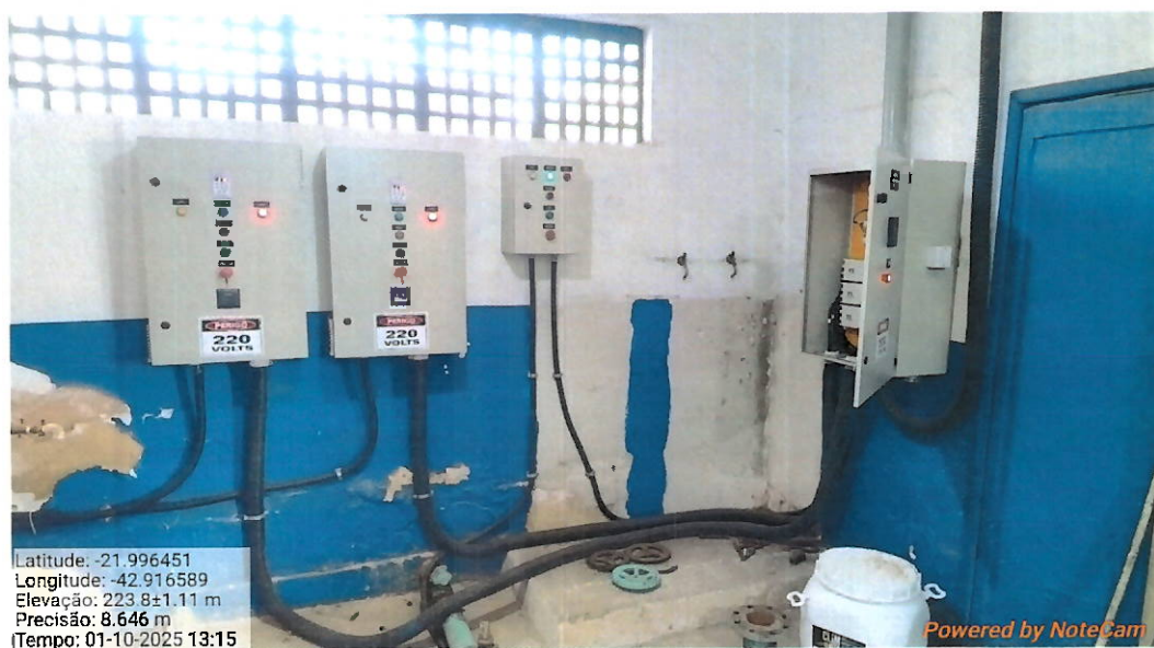
Foto 14: Novo quadro elétrico instalado.
