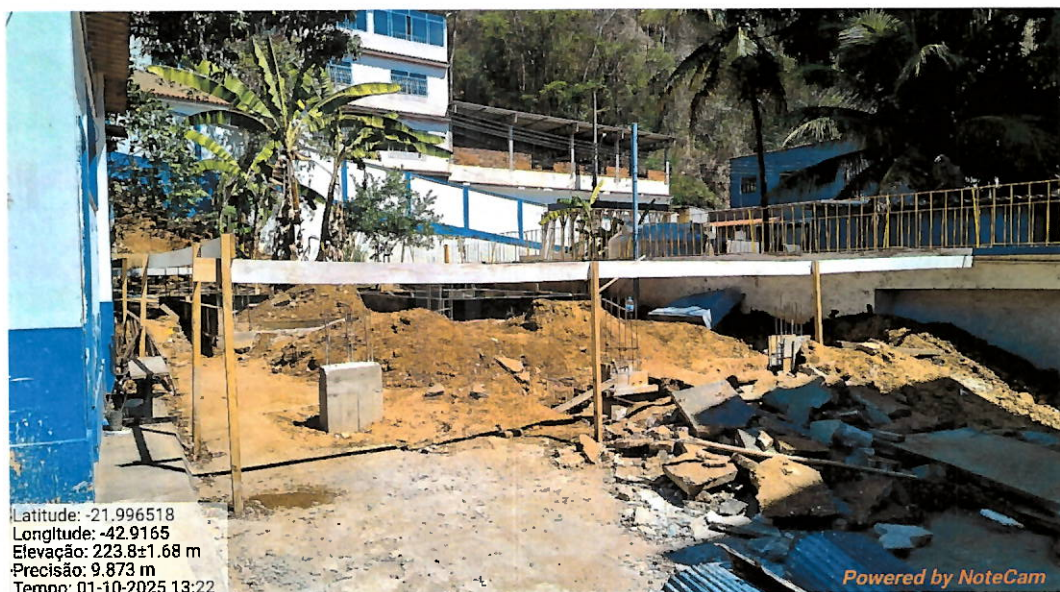
Foto 27: Área externa em obras.
