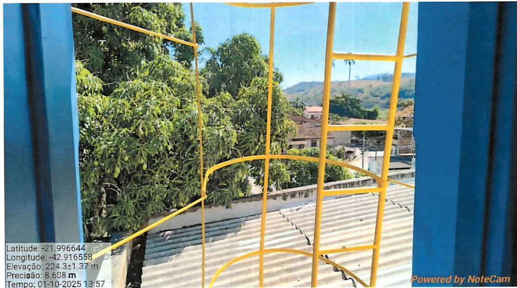
Foto 31: Escada com gaiola de proteção.
