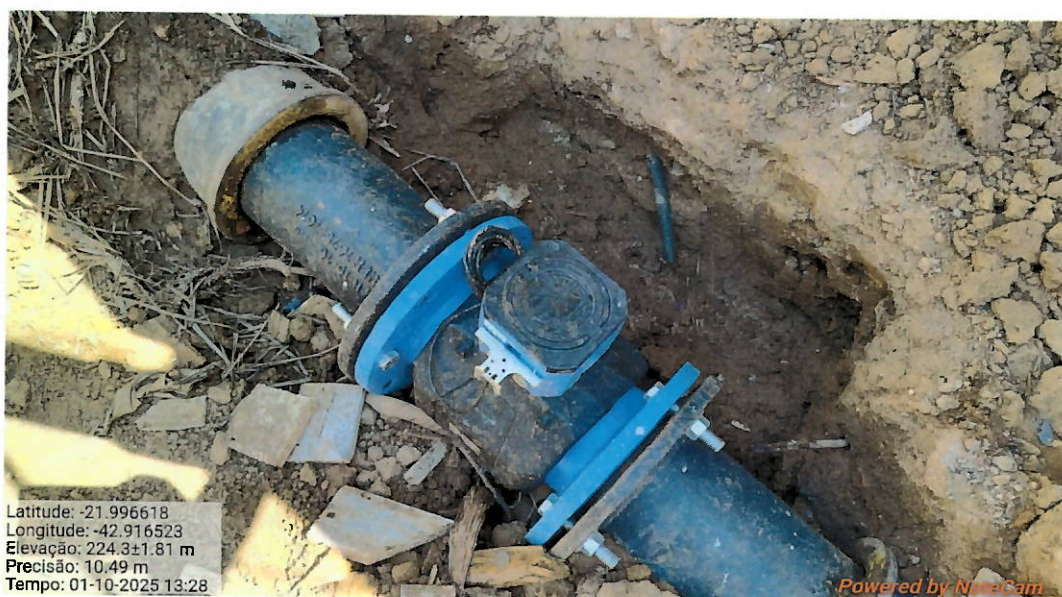
Foto 26: Novo macromedidor instalado na saída da ETA.
