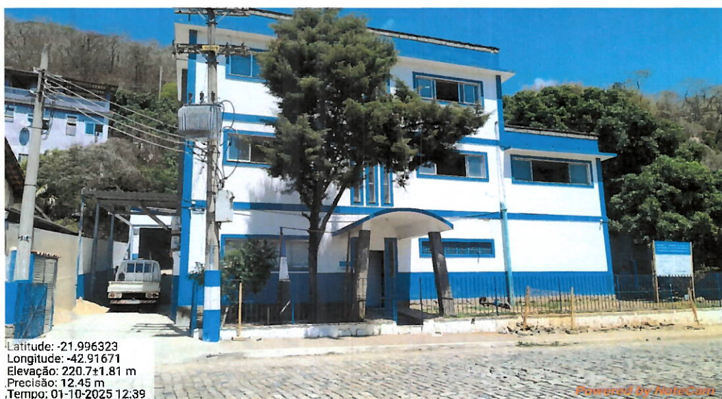
Foto 4: Fachada da ETA.
