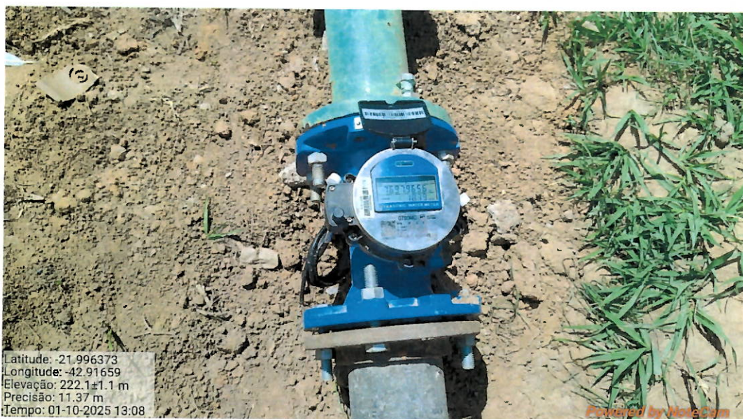
Foto 25: Novo macromedidor instalado na saída da ETA.
