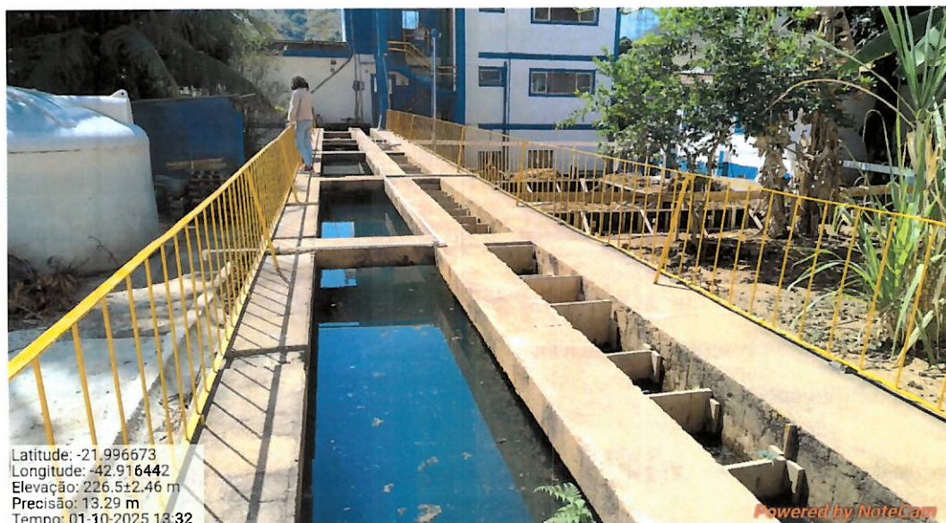
Foto 7: Floculador (à direita) e decantador (à esquerda).
