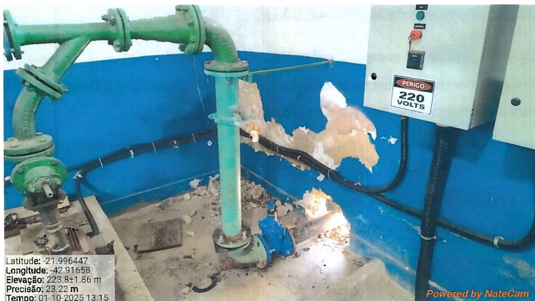
Foto 13: Conjuntos motobombas da elevatória que abastece o bairro São João (potência de 12,5 cv cada) com novo quadro elétrico instalado.
