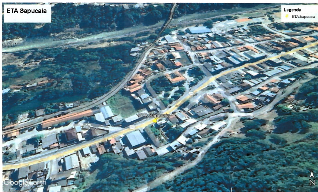
Imagem 1: Localização da ETA Sapucaia (21°59'47.38"S 42°55'0.09"O).
