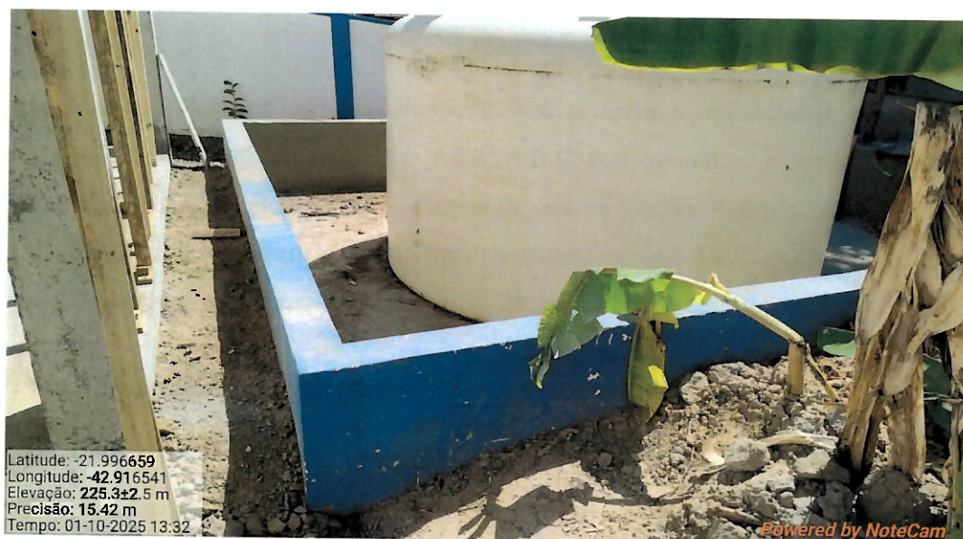
Foto 23: Armazenamento de sulfato de alumínio.
