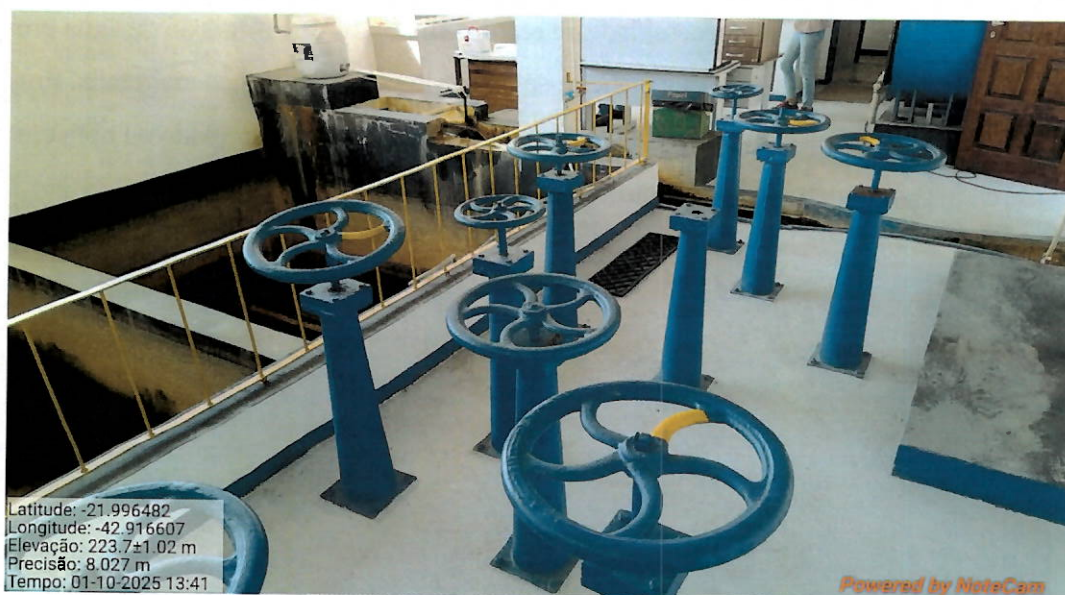
Foto 9: Registros de controle de entrada de água reformados.
