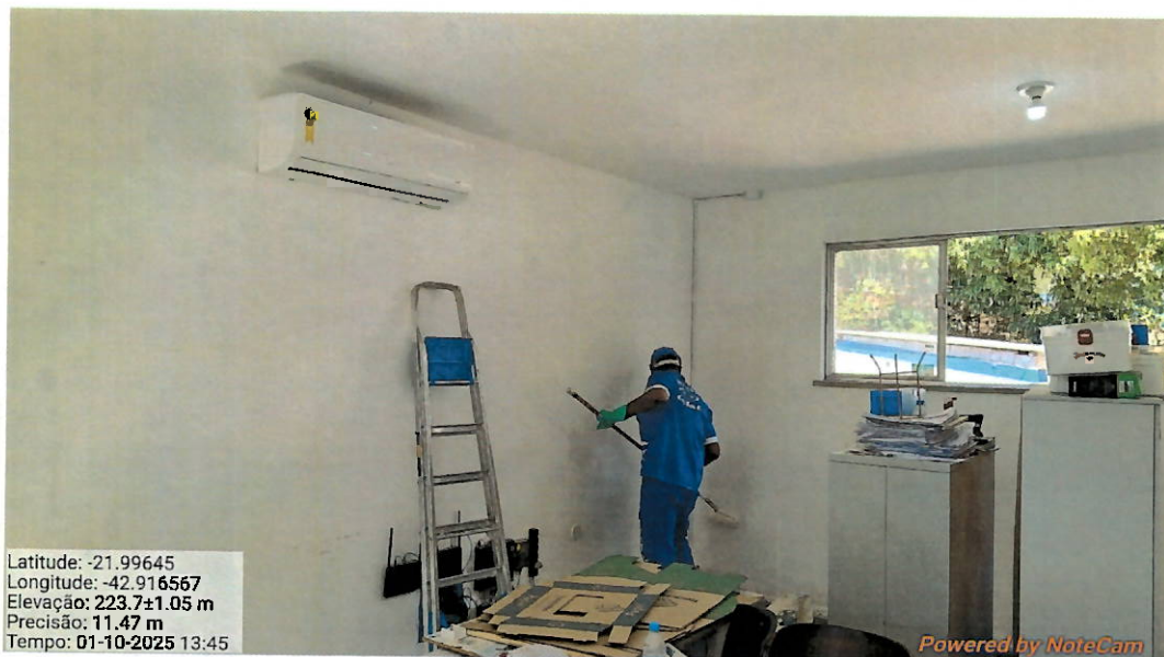
Foto 29: Área interna em obras.
