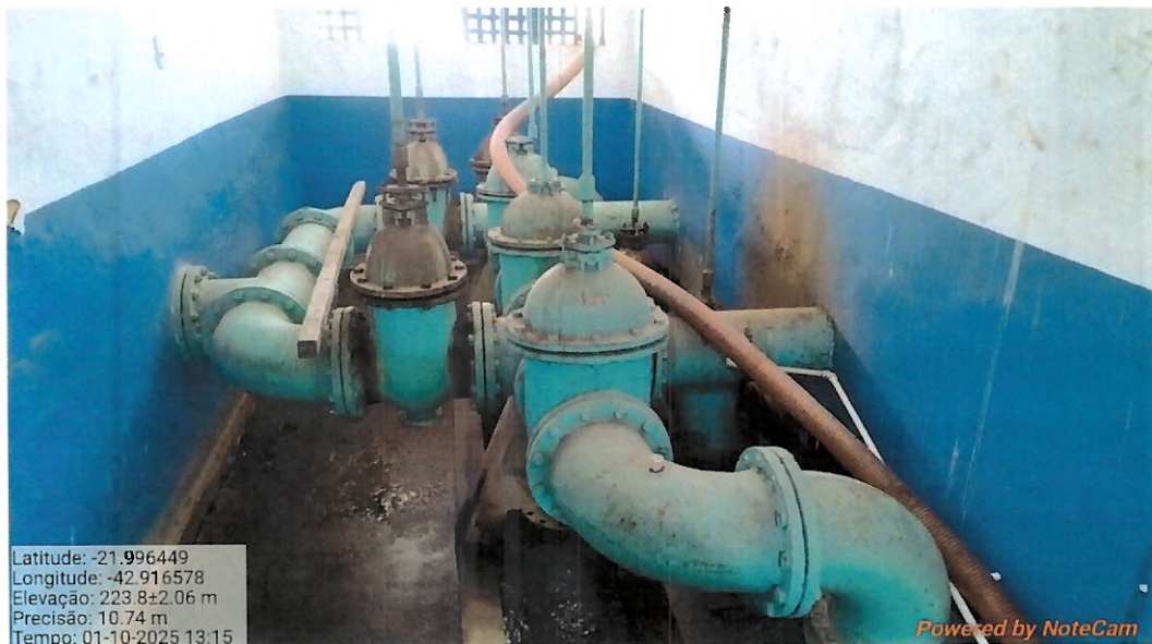
Foto 17: Barrilhete de água de lavagem dos filtros (ausência de vazamentos identificados na vistoria anterior).
