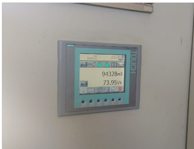
Foto 3 - Vazão de esgoto do dia 12/11/2024
