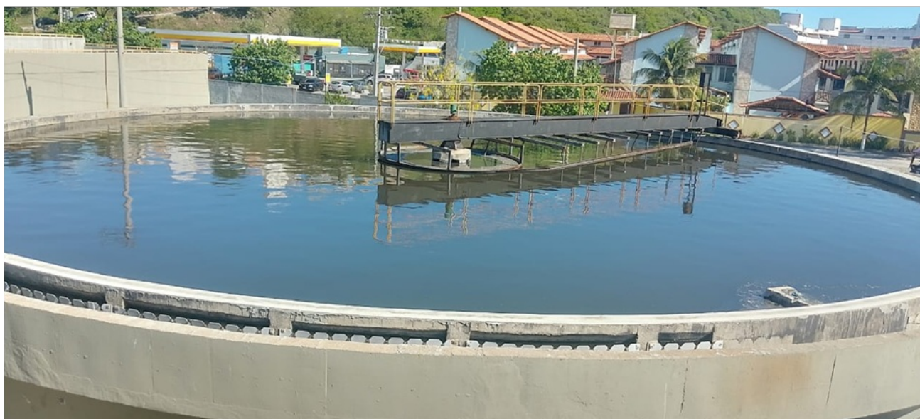
Foto 9- Decantador operando normalmente, parte do lodo é recirculada para o reator
