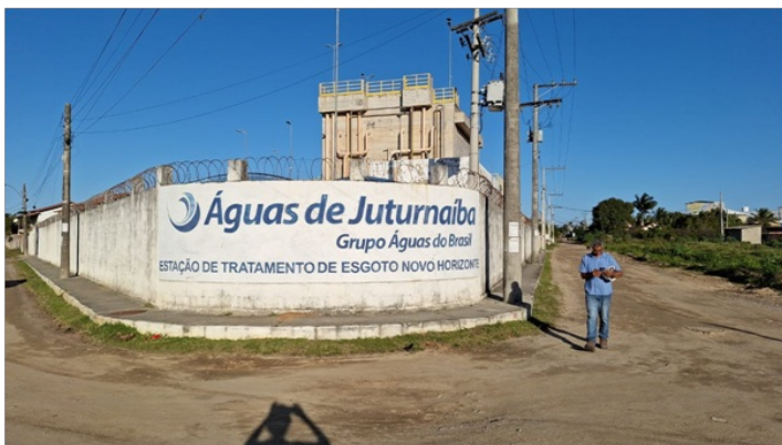
Foto 3 – Vista externa da ETE ( Confluência da rua Ari Barroso com rua do Encantado)
