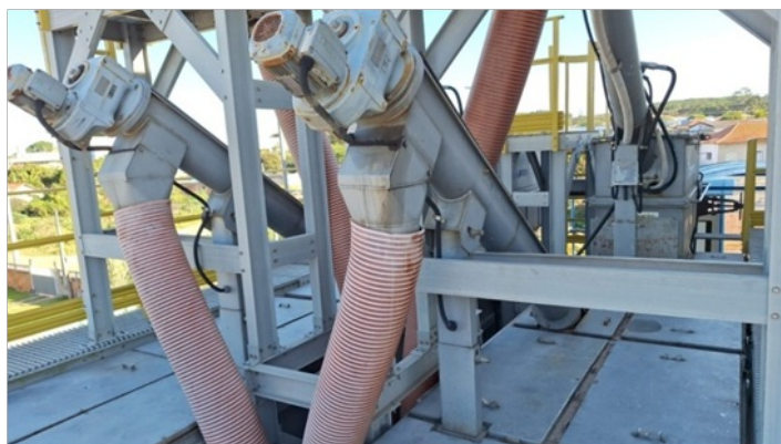
Foto 8 – Sistema de Tratamento preliminar ( PTRAT) :remoção de resíduos sólidos,gordura e areia.
