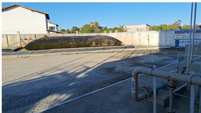
Foto 20 – Armazenamento do lodo em bag para drenagem e destinação.
