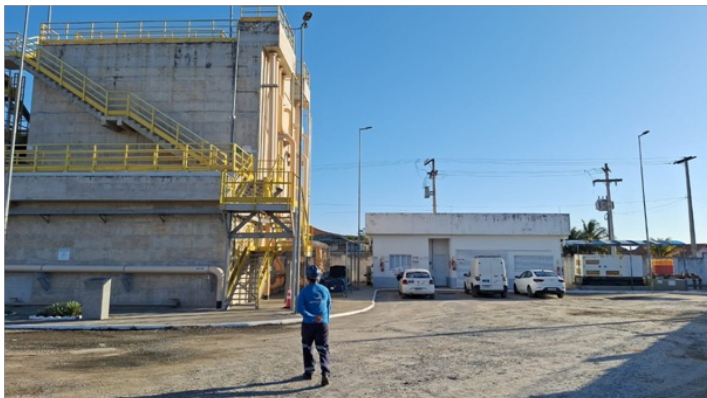
Foto 4 – Vista interna da ETE com prédio anexo para laboratório/sala de controle operacional/ Gerador ao lado.
