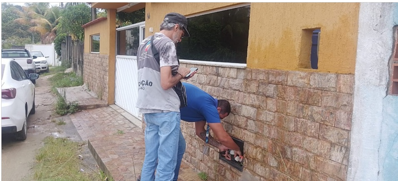
Foto 3 – Verificação de abastecimento pelo hidrômetro.
