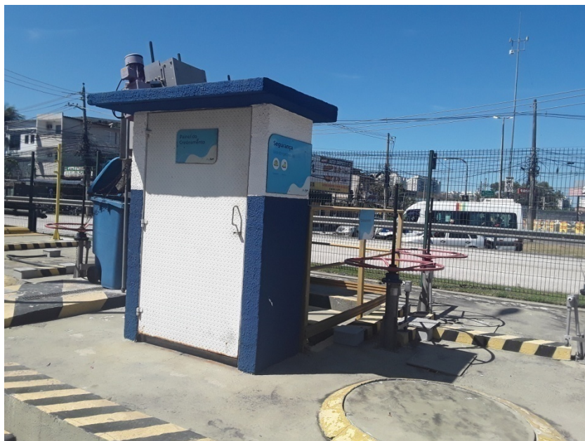
Foto 13 – Abrigo de alvenaria
