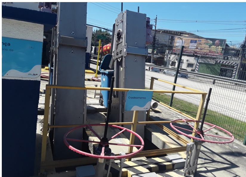
Foto 15 – Guarda corpos em volta do gradeamento
