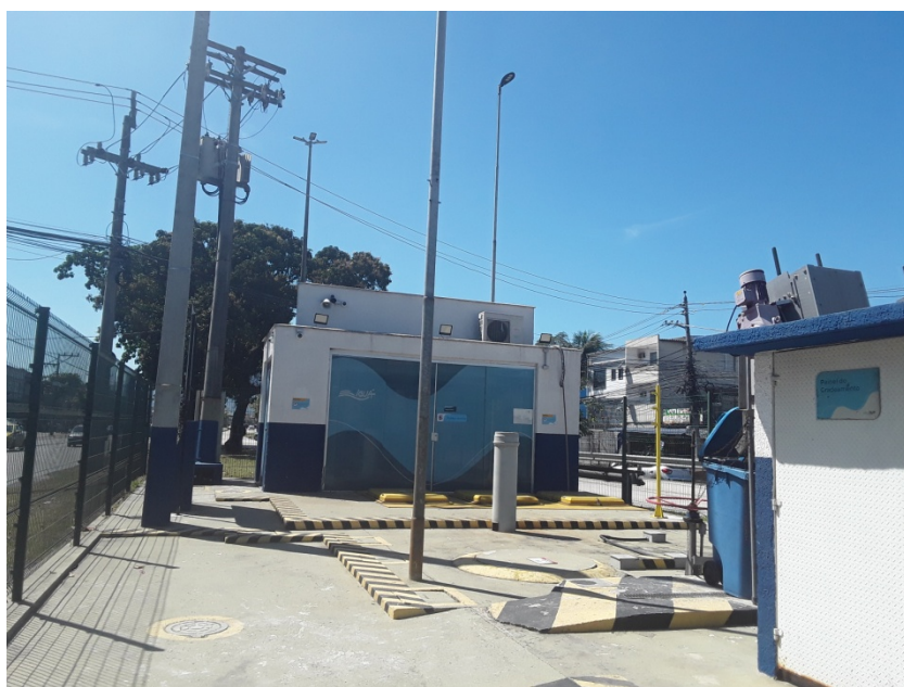
Foto 4 – Sinalização de segurança
