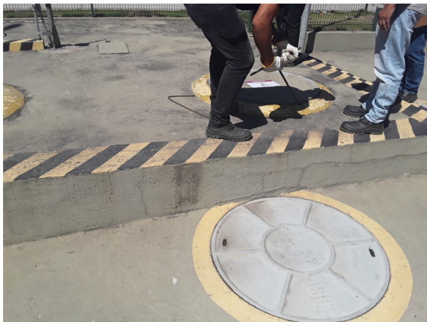
Foto 5 – Tampões do poço de visita e caixa receptora
