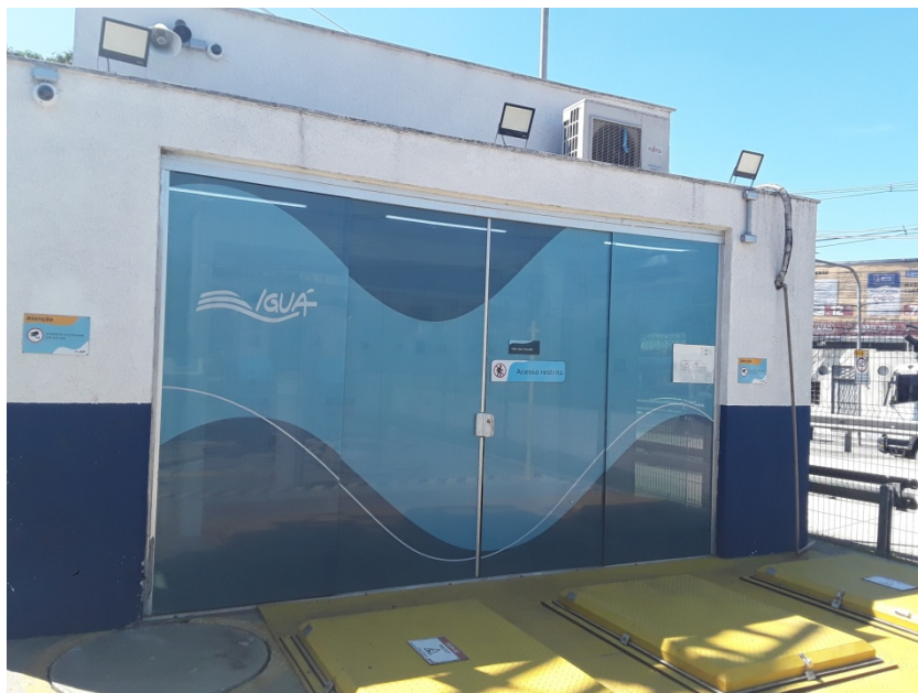
Foto 17 – Abrigo onde estão localizados os painéis elétricos de controle das motobombas da EEEB
