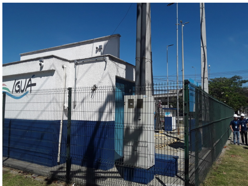
Foto 2 – Acesso restrito com grades no entorno da unidade
