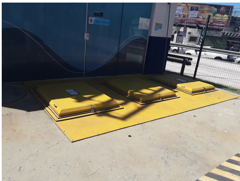
Foto 6 – Tampões do poço das motobombas
