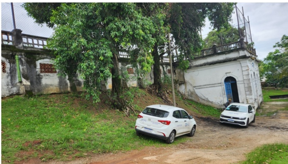
Foto 1 – Entrada do Reservatório
