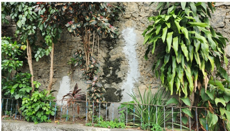
Foto 2 – Reparos feitos nas fissuras em uma lateral do muro
