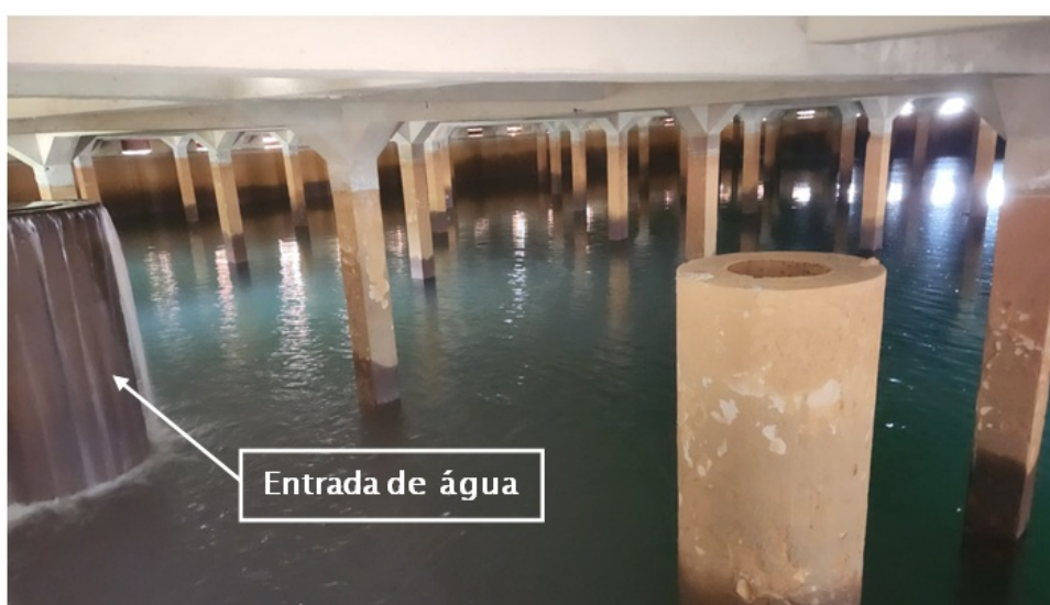
Foto 11 – Parte interna do reservatório
