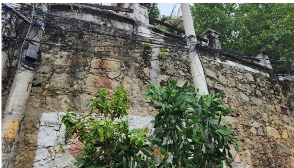
Foto 3 – Reparo feito na fissura em uma lateral do muro
