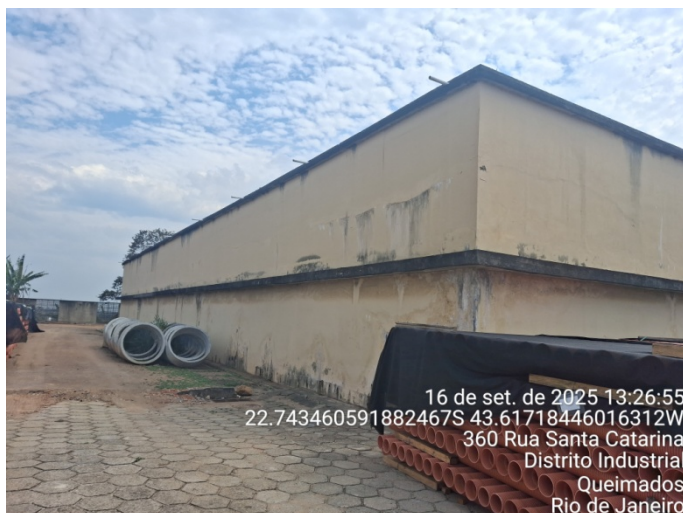
Foto 3: Vista externa reservatório
