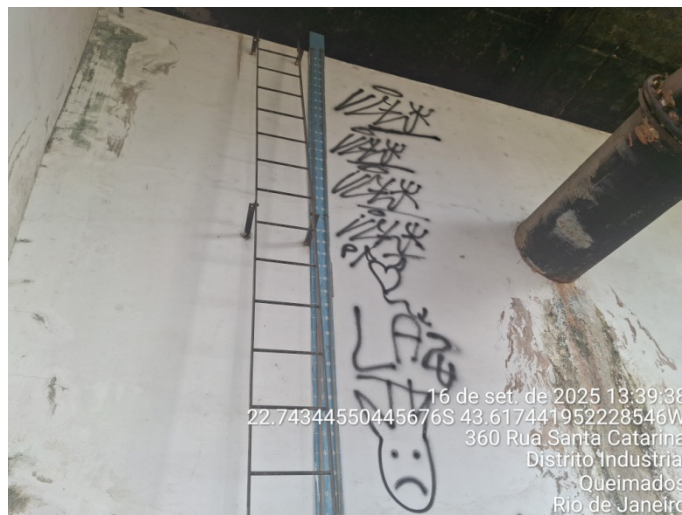
Foto 7: Escada de acesso a laje e régua de nível
