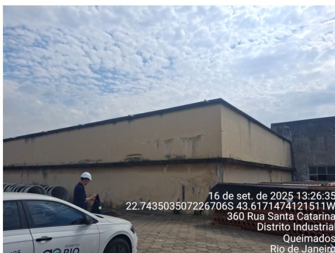
Foto 2: Vista externa reservatório
