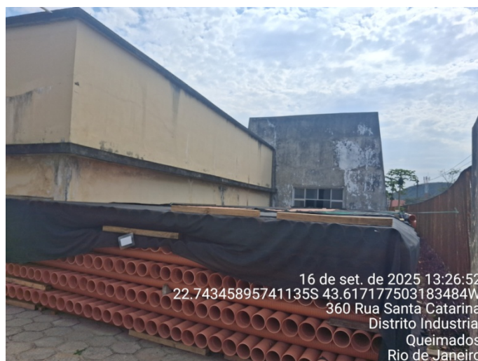
Foto 8: Material estocado no terreno
