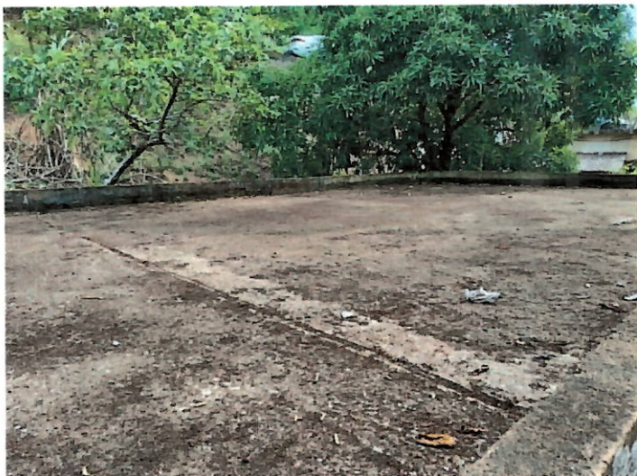
Foto 13: Vista superior da laje do reservatório.
