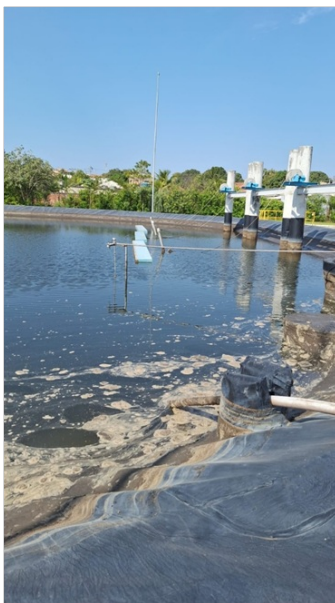
Foto 12 – Tubulações de sucção do lodo que operam durante a intermitência do fluxo de vazão afluente de esgoto.
