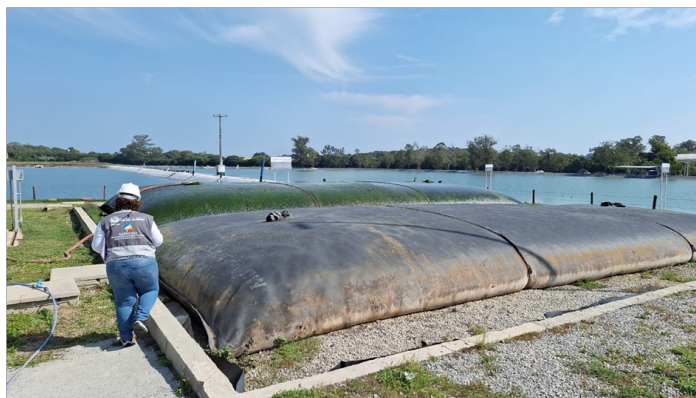
Fotos 17 - Lodo aspirado do reator, armazenado em Bags para desidratação.
