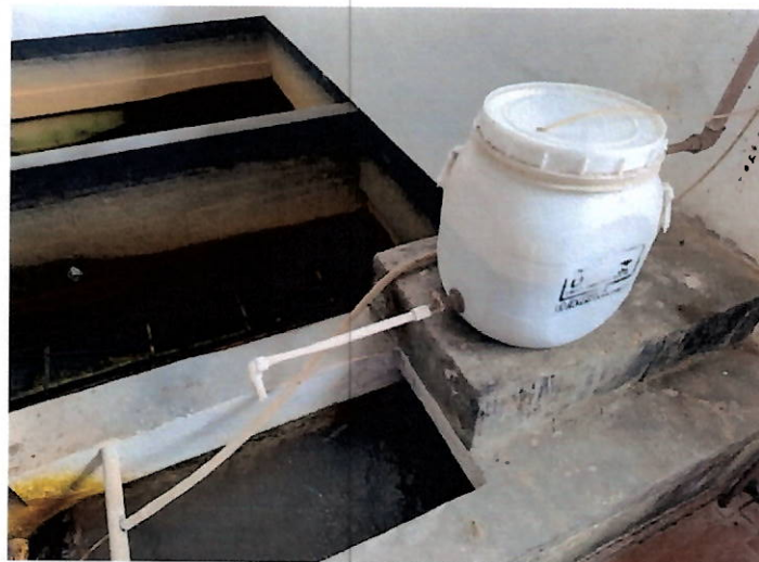
Foto 38: Ponto de aplicação do sulfato de alumínio.
