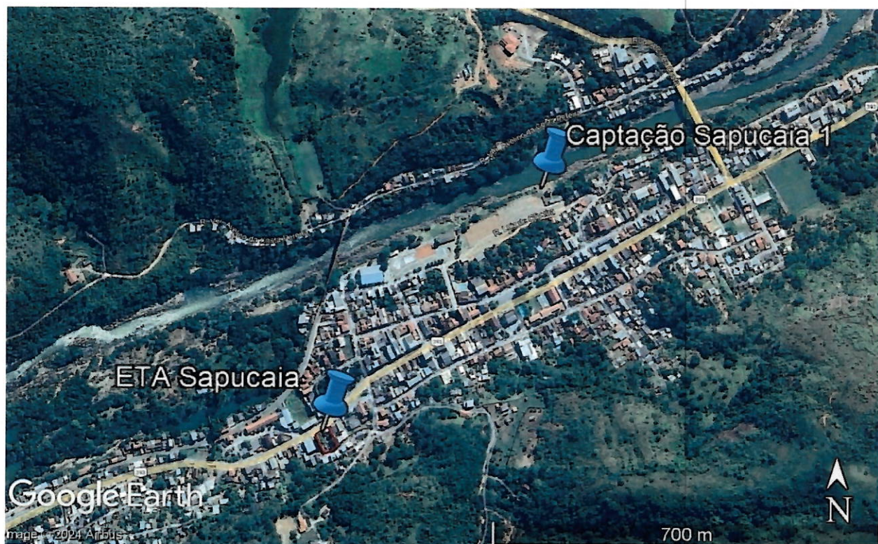
Imagem 2: Localização da captação em uso da ETA Sapucaia.
