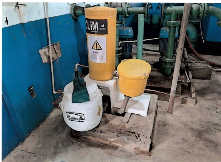
Foto 15: Dispositivo de cloração da água.
