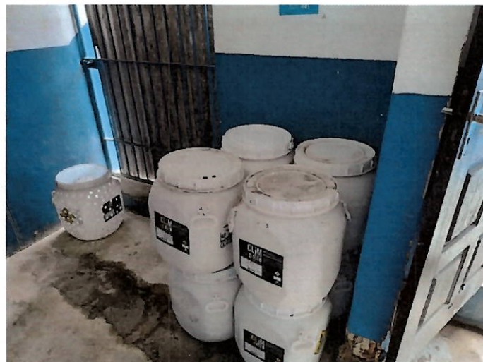
Foto 18: Depósito de produtos químicos.
