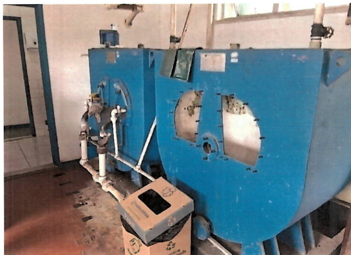
Foto 41: Equipamento desativados para preparação de cal.
