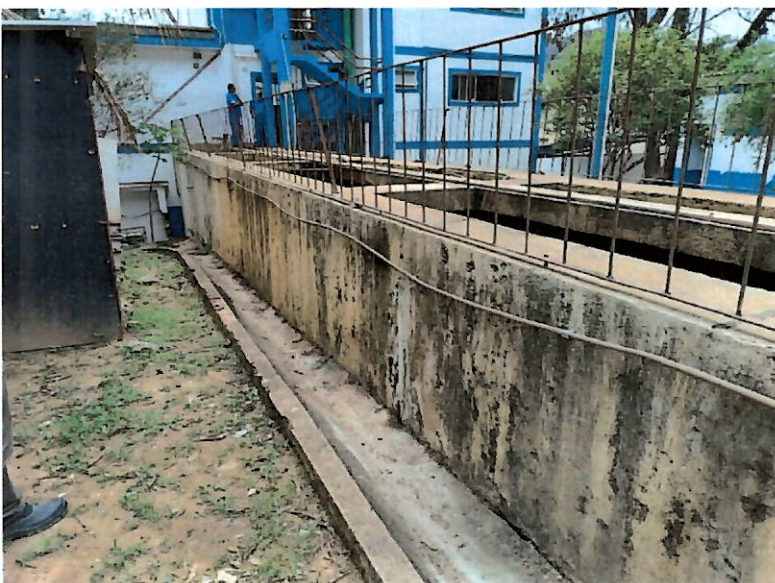
Foto 12: Lateral externa do tanque de decantação.
