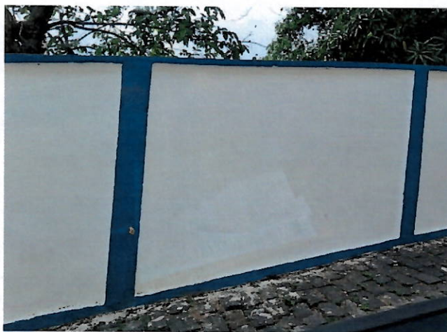
Foto 7: Muro de alvenaria que cerca a ETA.
