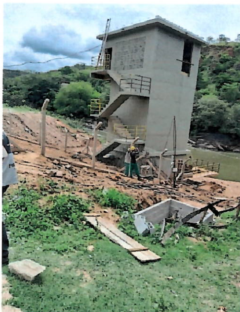
Foto 5: Vista da obra da nova estrutura de captação.
