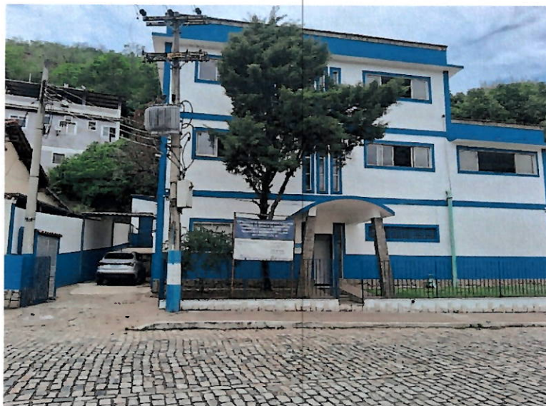
Foto 6: Vista da fechada da ETA.
