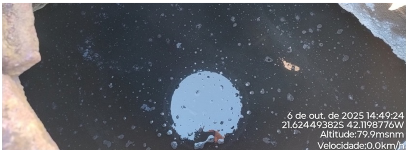
Foto 04 – Poço de visita (PV) do filtro.
