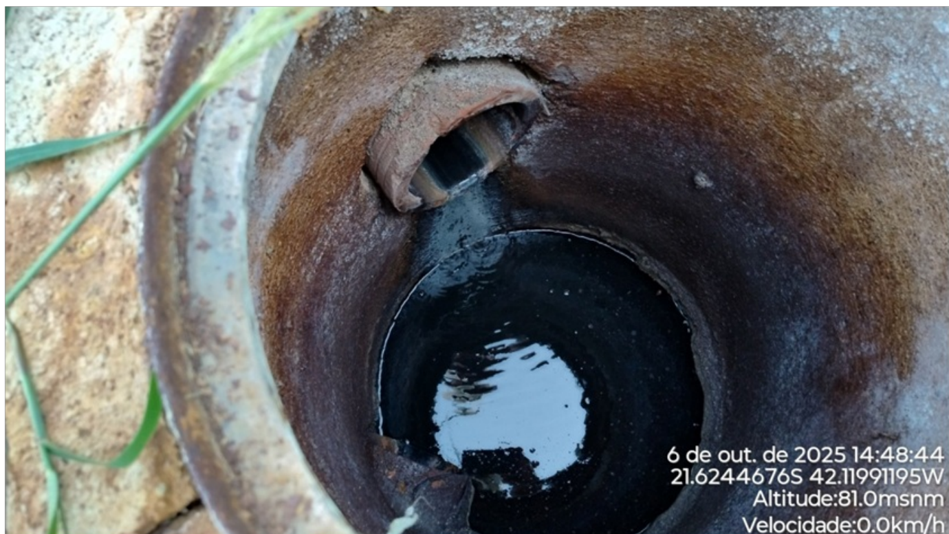
Foto 05 – Lançamento do efluente pós tratamento.
