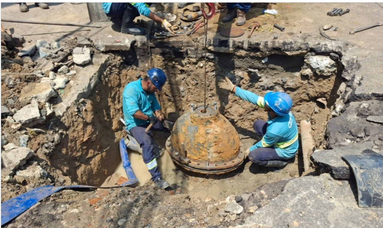
Foto 3 – Recolocação da “cabeça” da válvula após remoção da “cunha” e da haste
