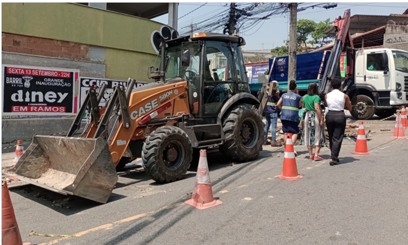
Foto 11 – Retro escavadeira, caminhão munck e gerador
