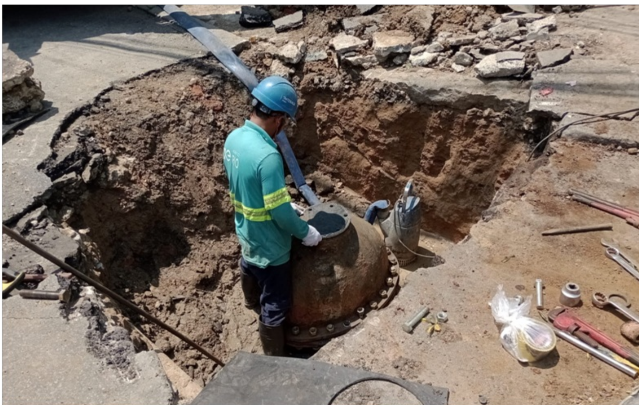
Foto 6 – Tamponamento da parte superior
