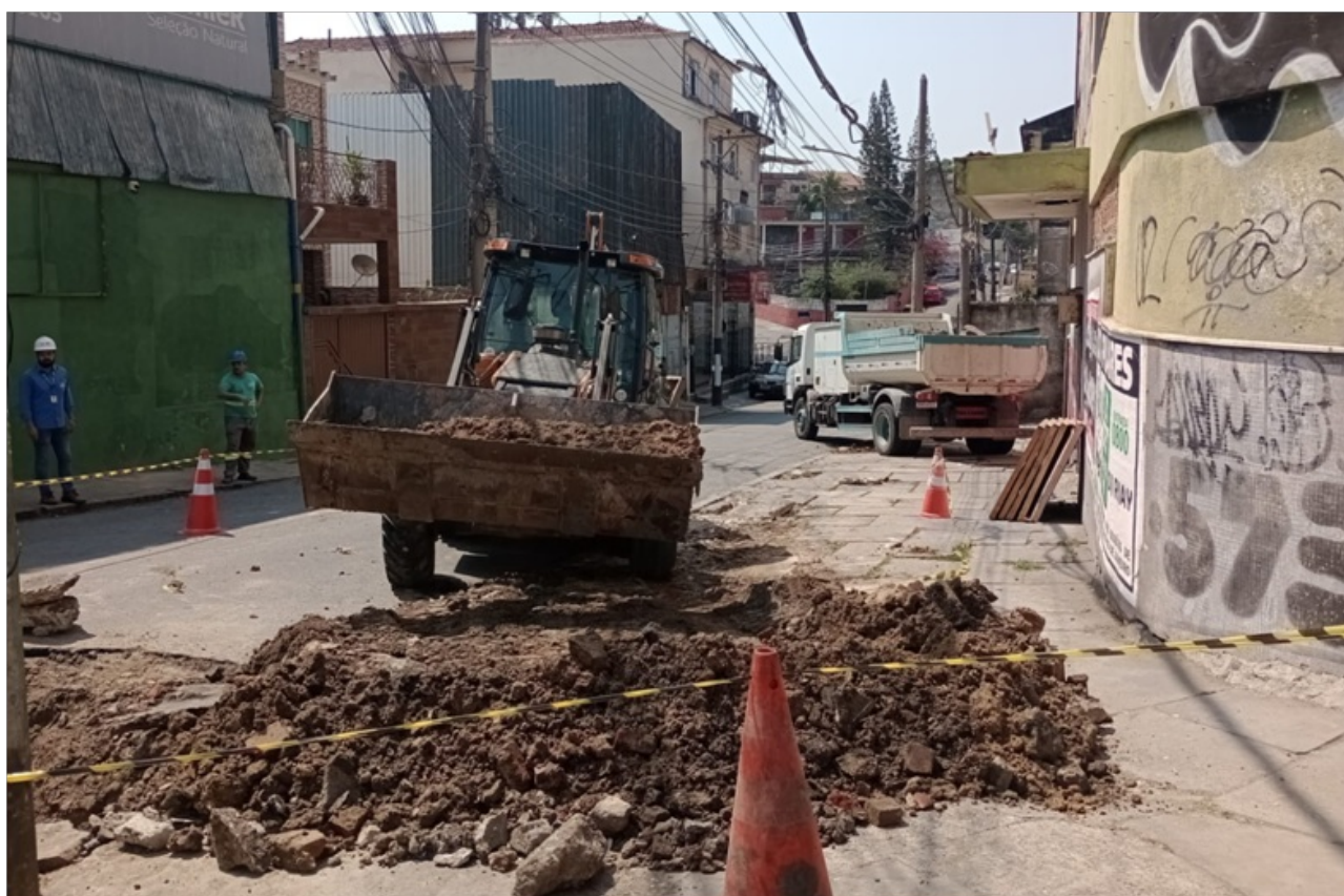
Foto 10 – Reaterro da escavação
