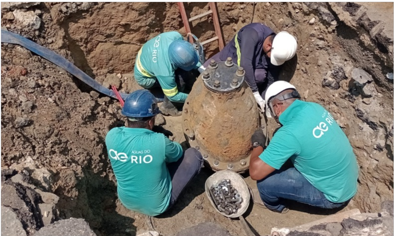
Foto 7 – Equipe reapertando os parafusos da “cabeça” da válvula
