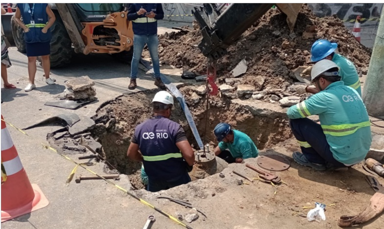
Foto 4 – Recolocação da “cabeça” da válvula após remoção da “cunha” e da haste
