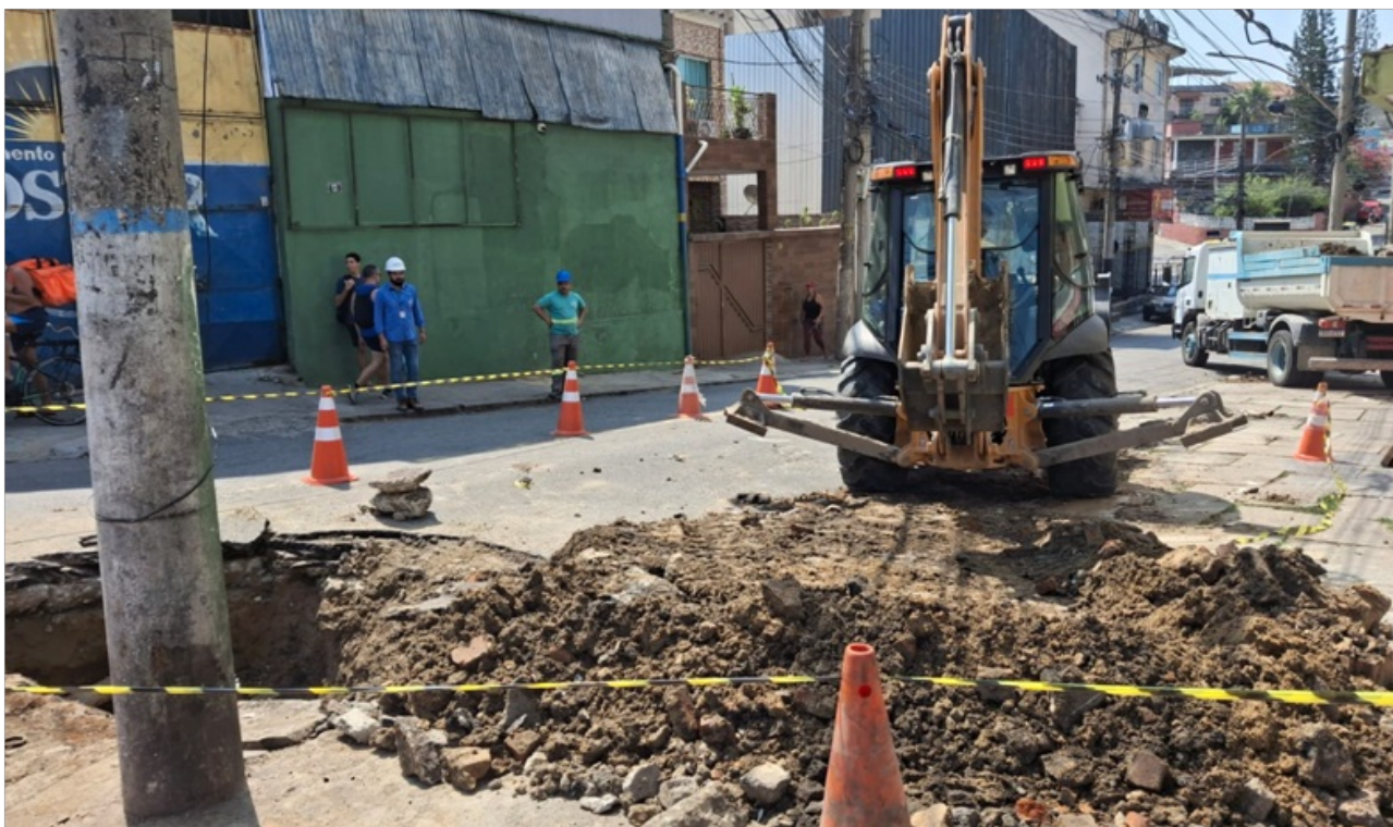
Foto 1 – Escavação sendo executada
