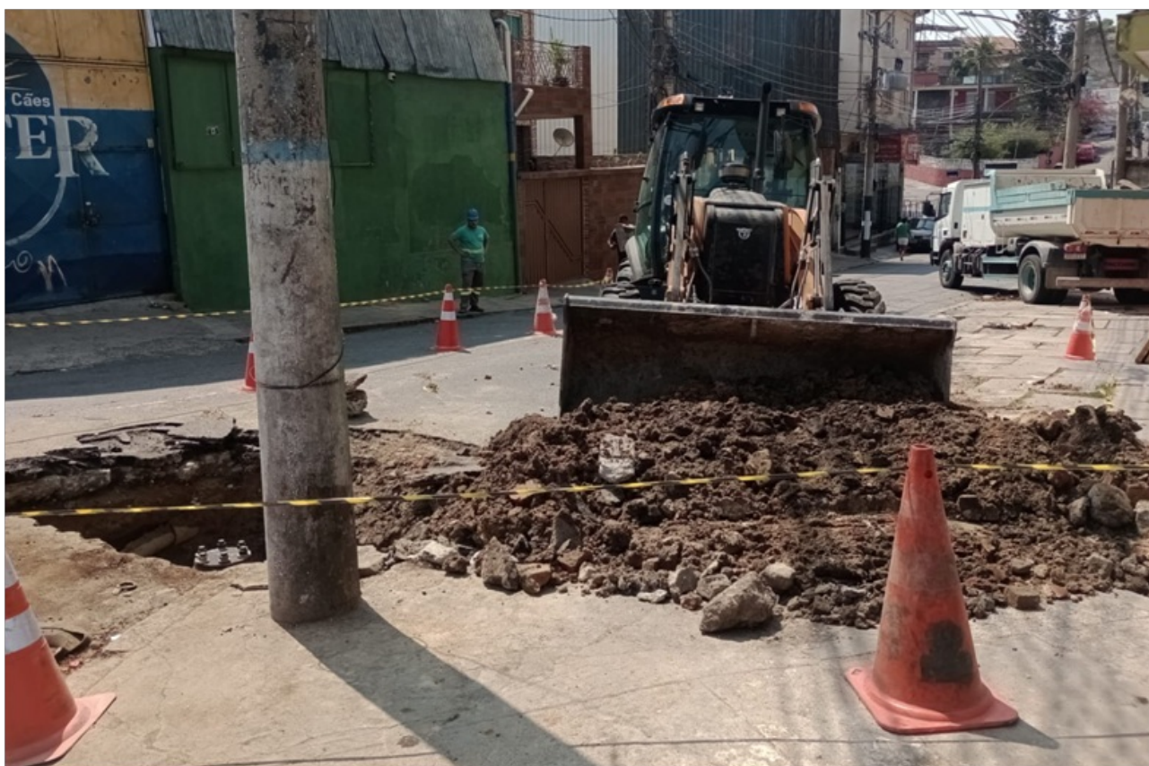
Foto 9 – Reaterro da escavação
