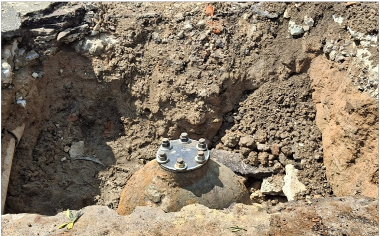
Foto 8 – Vedação de borracha e flange cego já instalados
