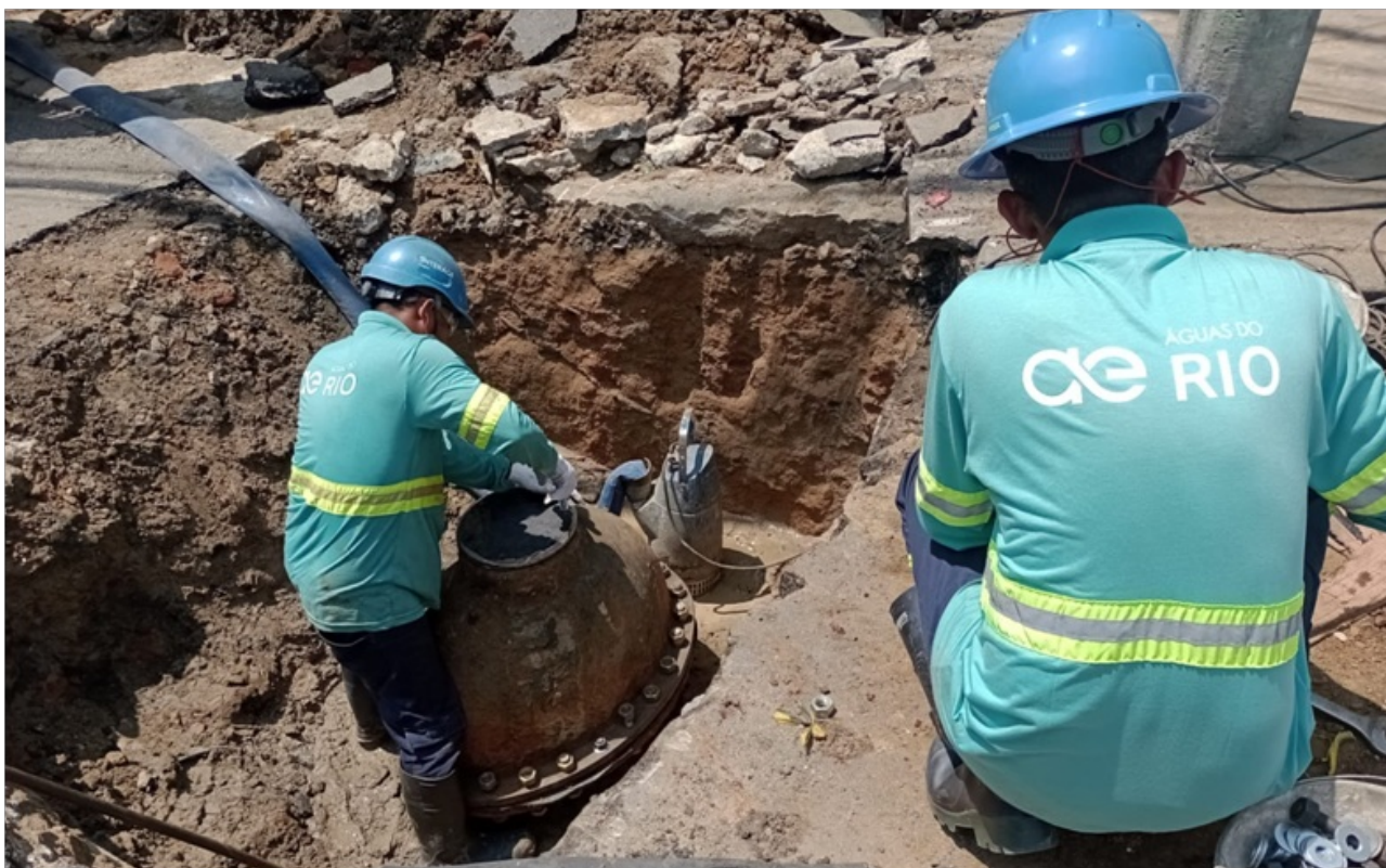
Foto 5 – Tamponamento da parte superior
