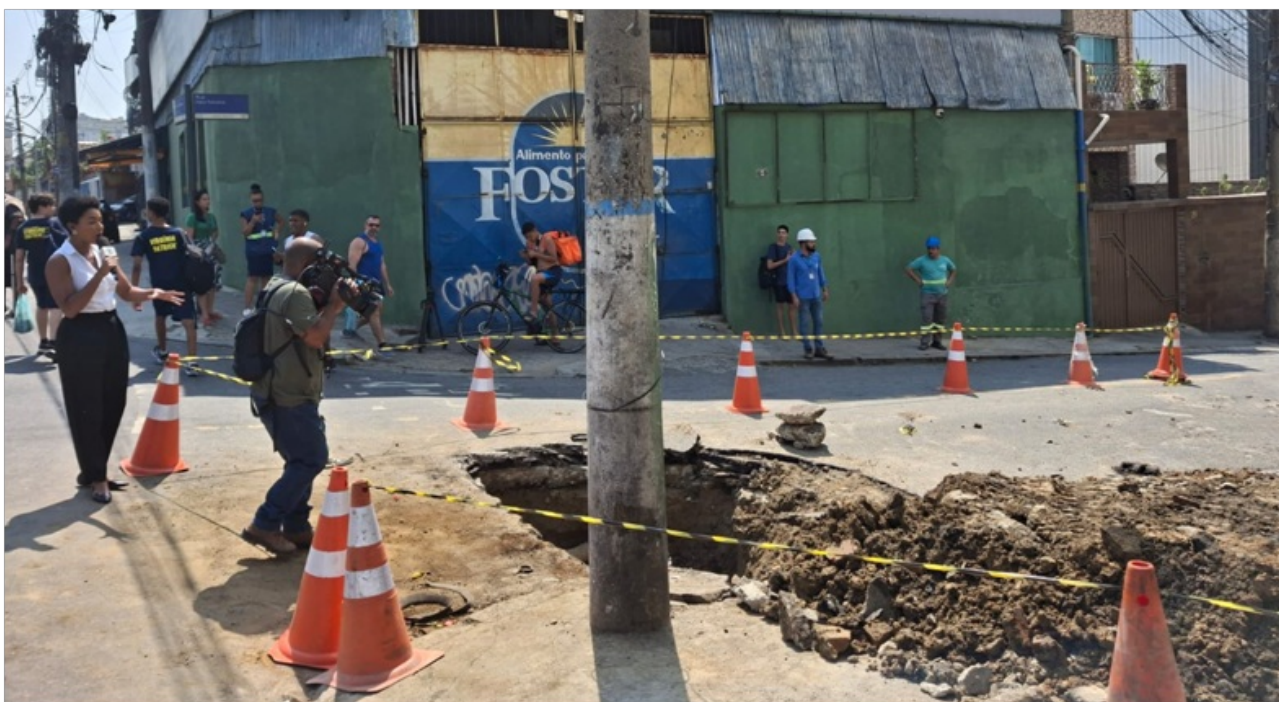
Foto 2 – Escavação sendo executada
