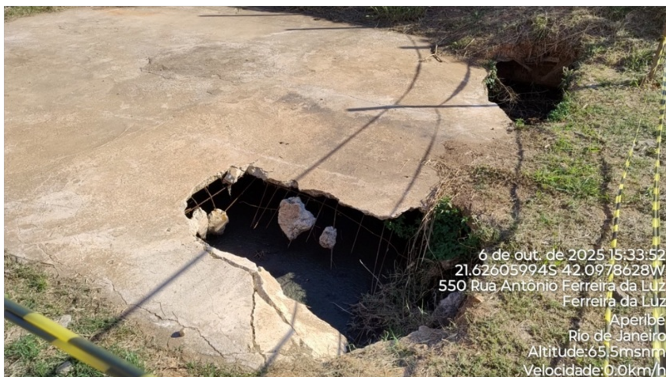
Foto 03 – Laje de cobertura da fossa danificada.
