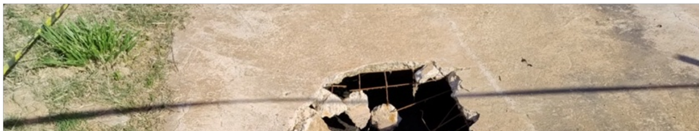
Foto 03 – Laje de cobertura da fossa danificada.
