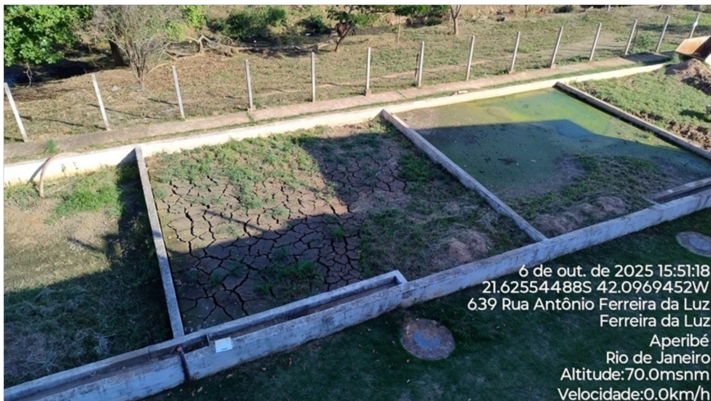
Foto 15 - Leitos de secagem do lodo.
