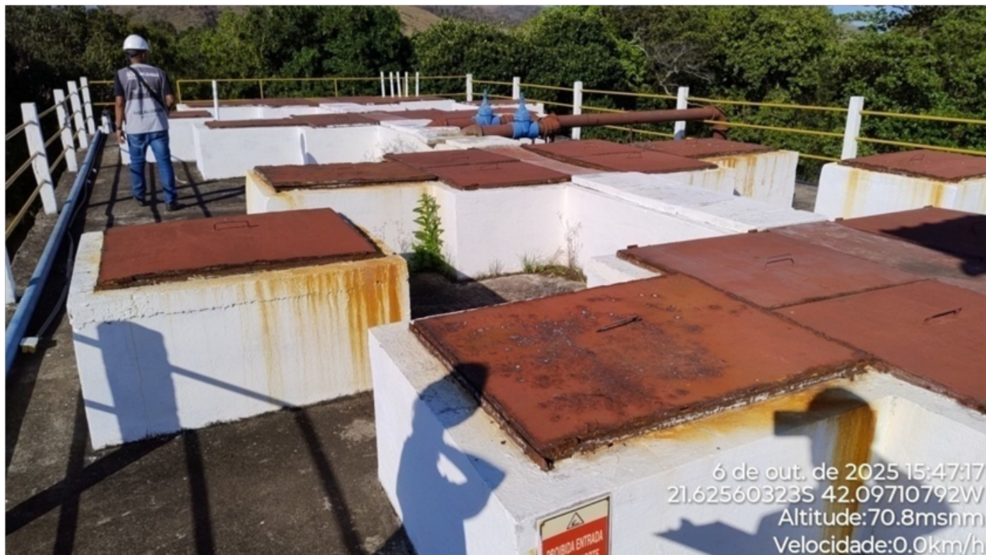
Foto 09 - Vista dos dois (02) módulos do Reator UASB.
