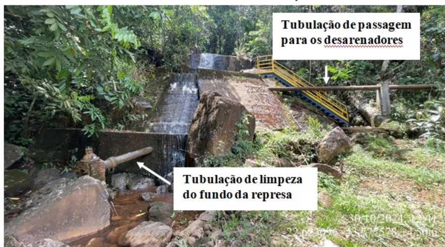
Foto 01 – Visão Geral da Barragem
