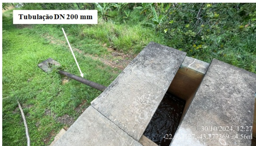
Foto 05 – Tubulação saindo da caixa
