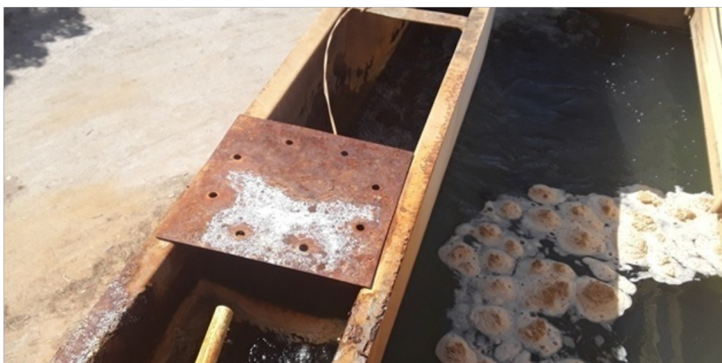
Foto 04 – Dosador do agente coagulante (Sulfato de alumínio).
