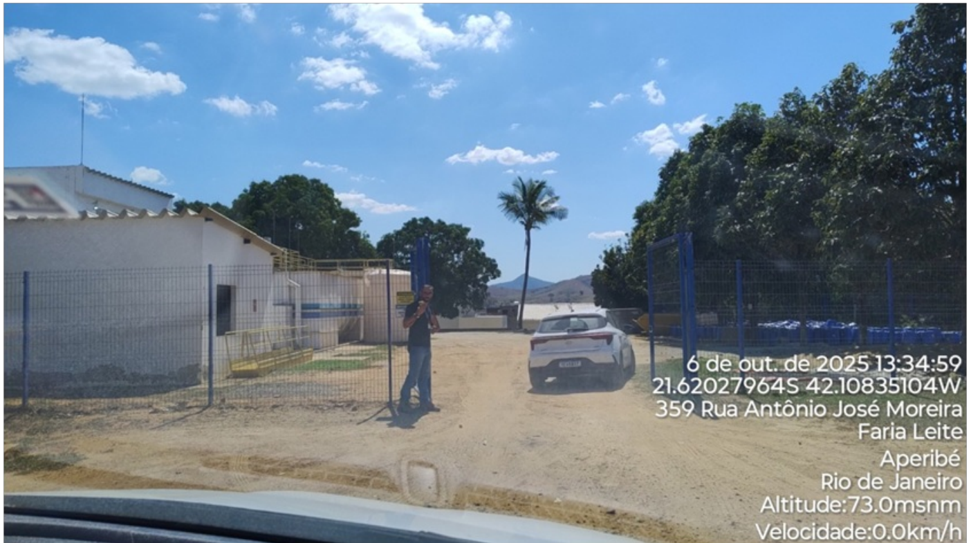
Foto 01- Entrada principal da Estação de Tratamento.
