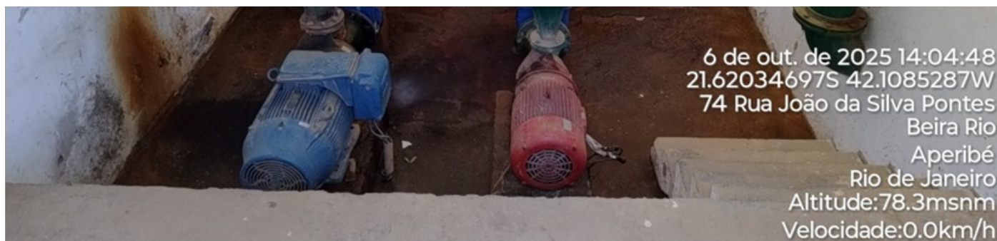
Foto 18 - Casa de bombas para lavagem dos filtros e EEAT para distribuição. No momento da fiscalização a EEAT apresentava um vazamento no selo da bomba, segundo informado pelos responsáveis da Concessionária.
