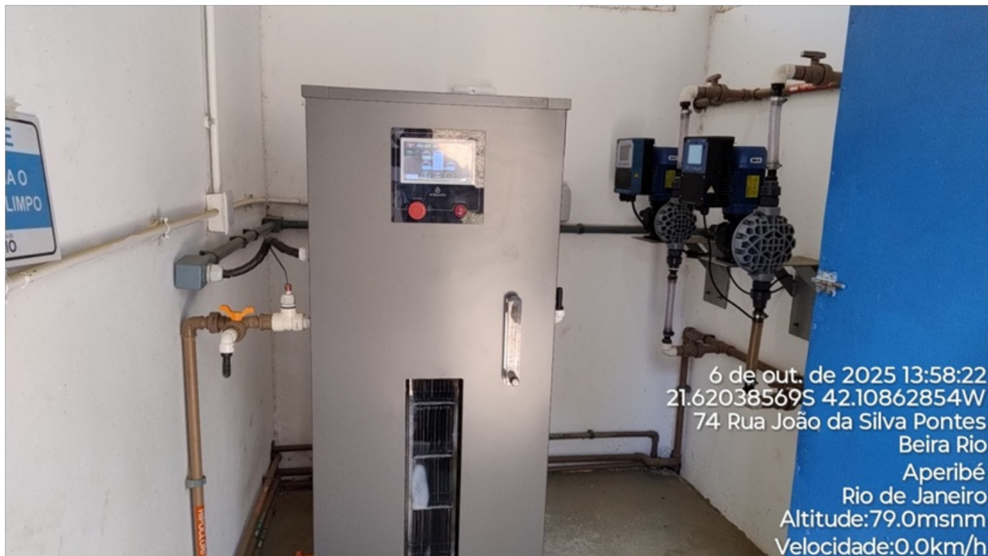
Foto 14 - Equipamento de produção do Hipoclorito de sódio.
