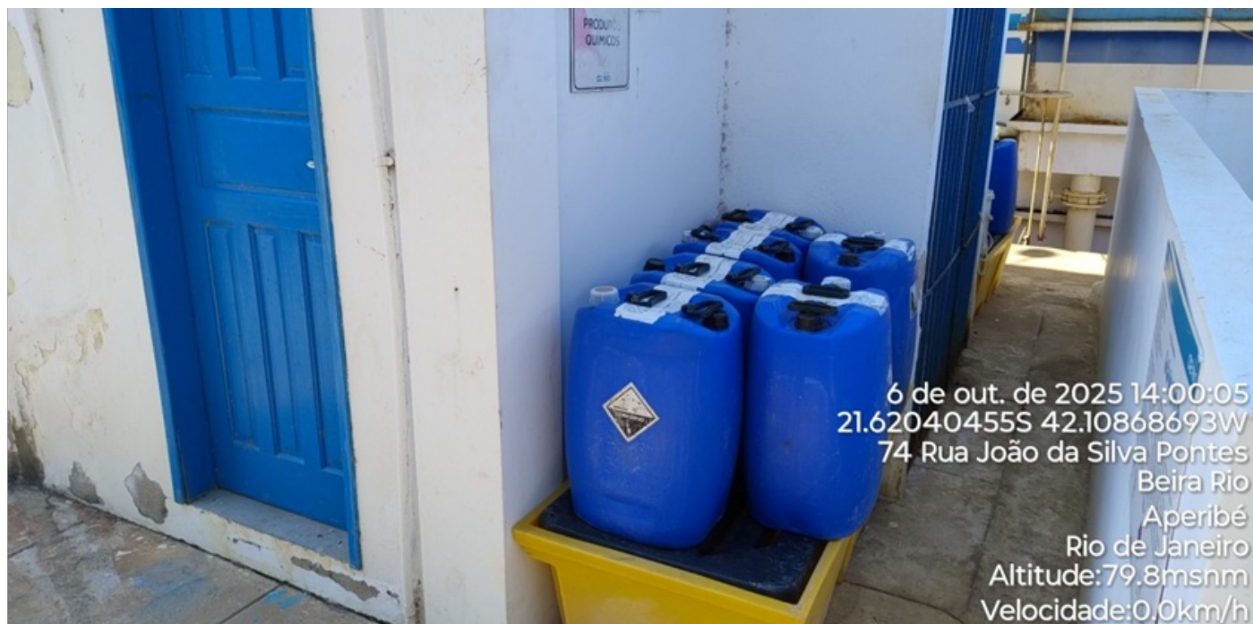
Foto 16 - Armazenamento do ácido fluossilícico.
