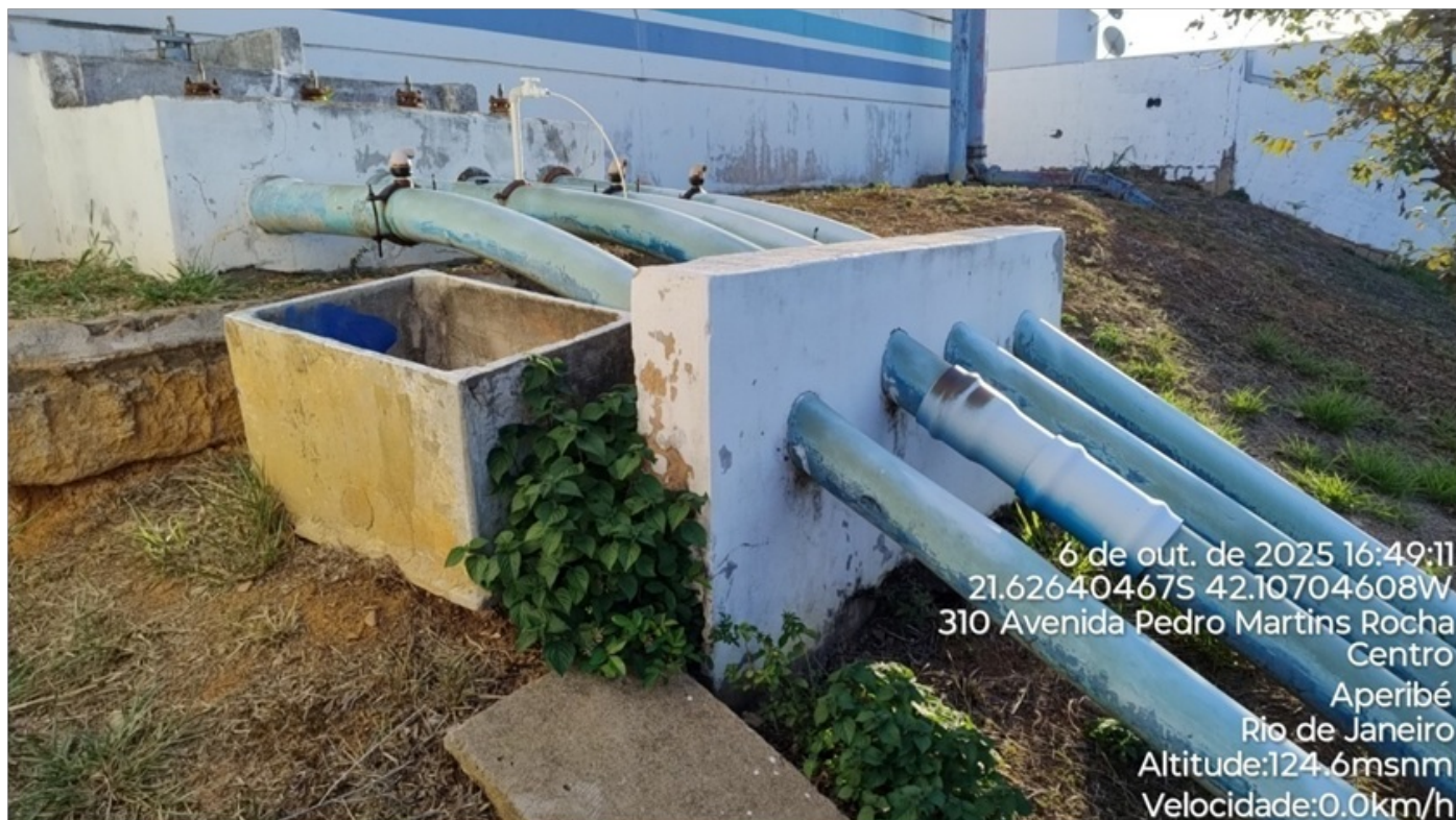
Foto 03 – Saídas de distribuição de 150 mm.
