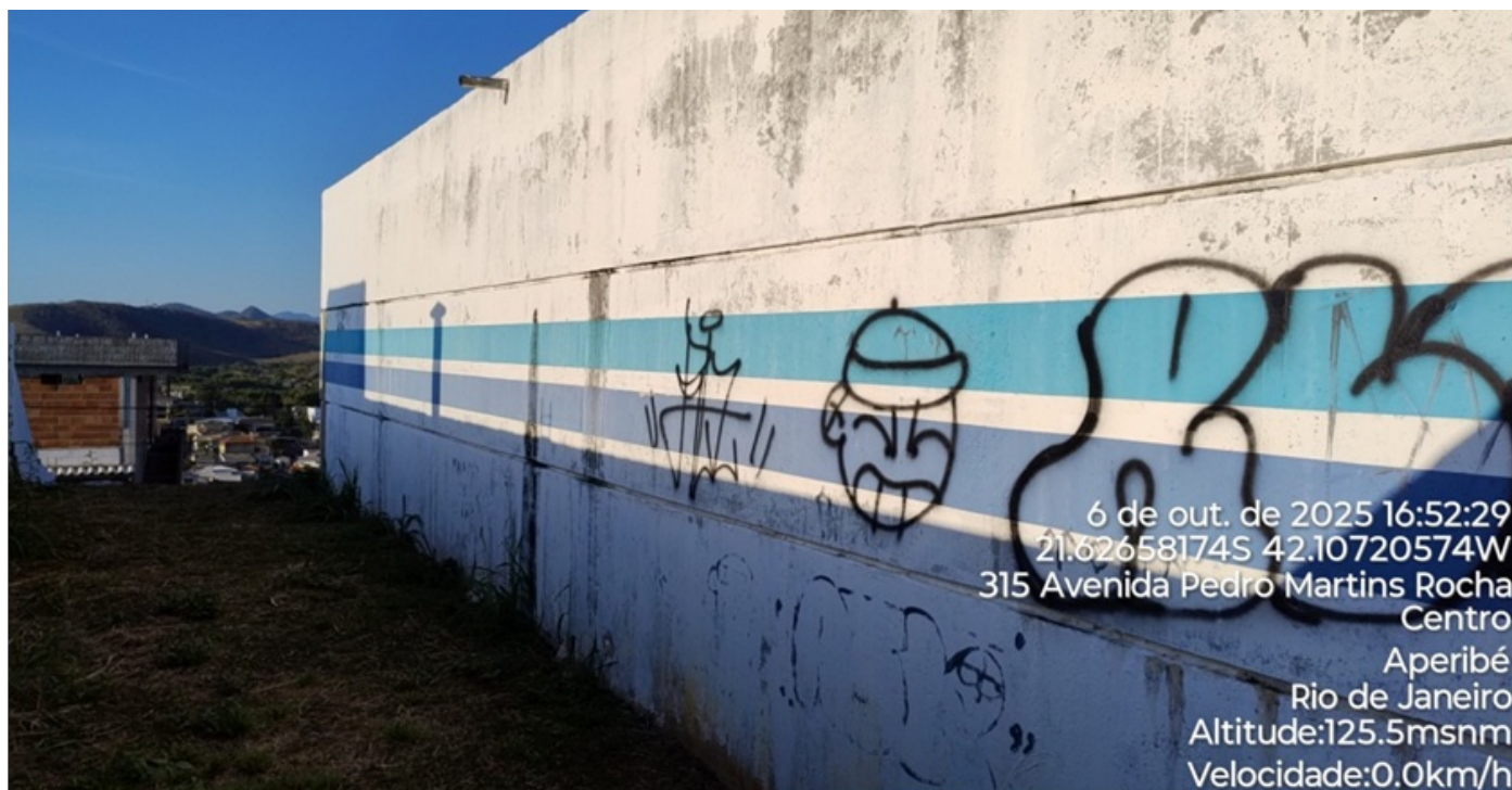
Foto 08 - Vista lateral do reservatório.
