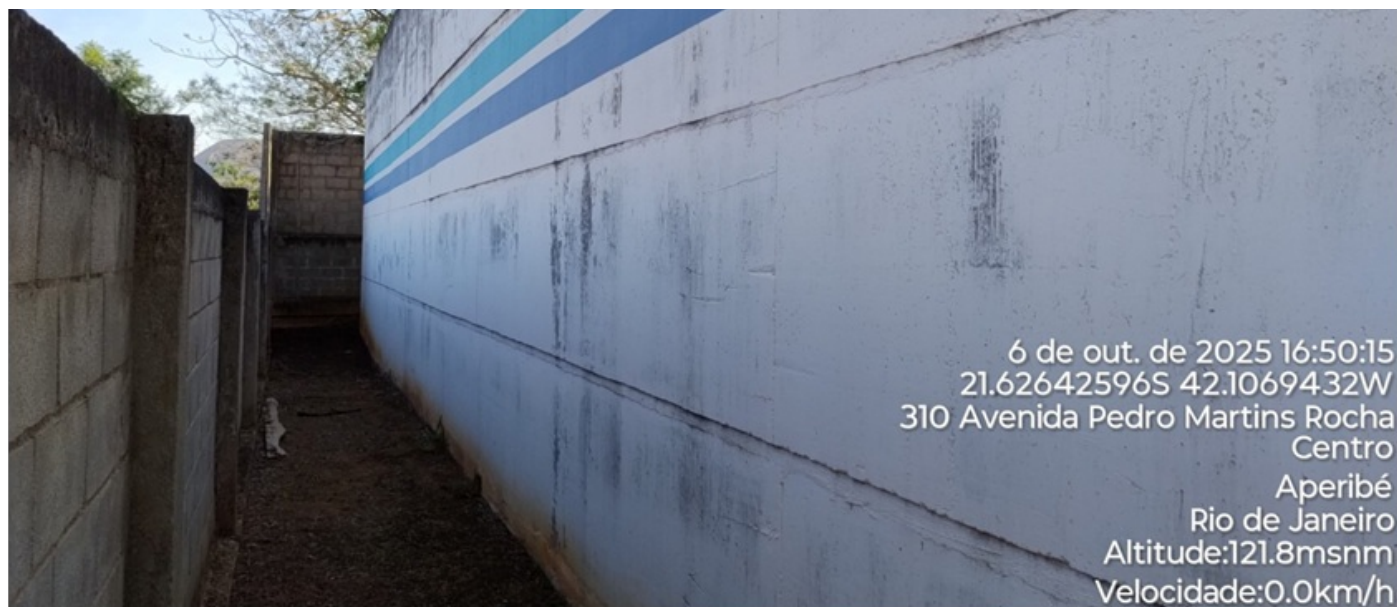
Foto 04 – Vista lateral do reservatório.
