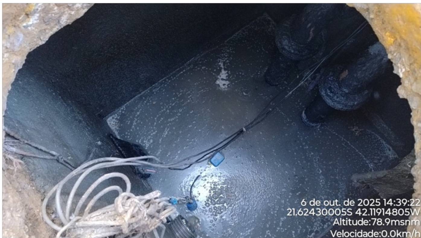
Foto 03 – Poço da motobomba submersível de recalque.
