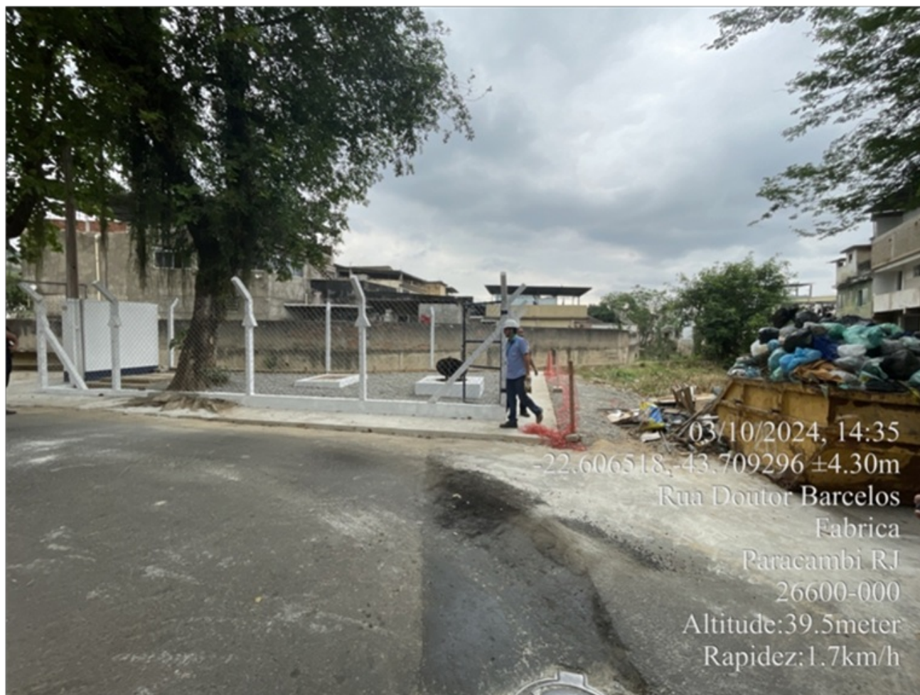
Foto 02 - Vista geral elevatória
