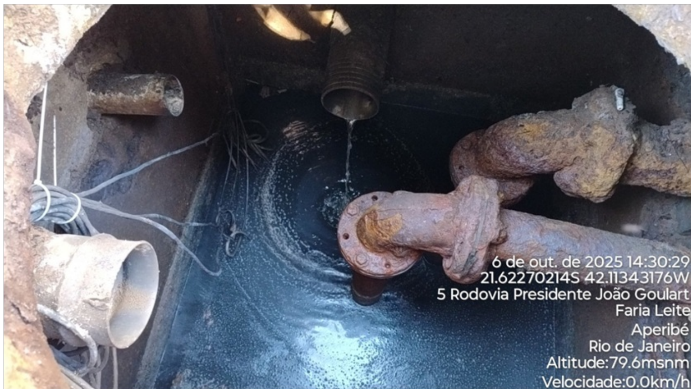
Foto 03 – Poço da motobomba submersível de recalque.
