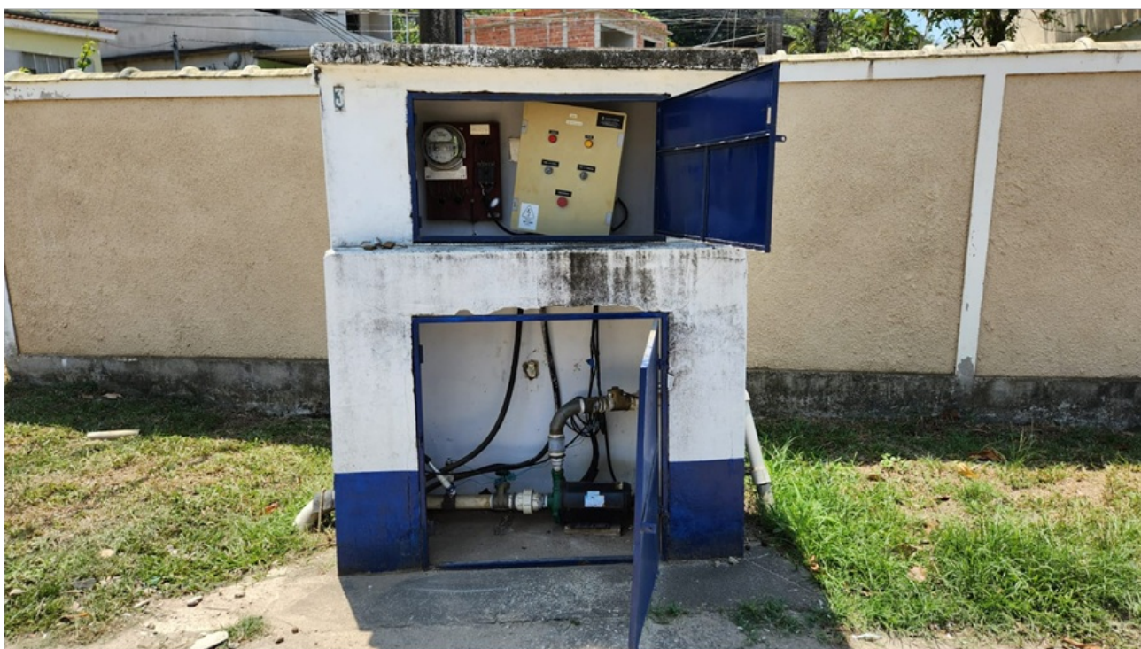
Foto 4 – Abrigo da motobomba
