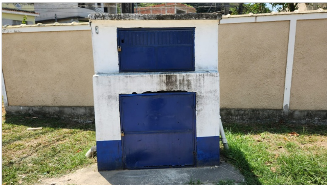
Foto 3 – Abrigo da motobomba
