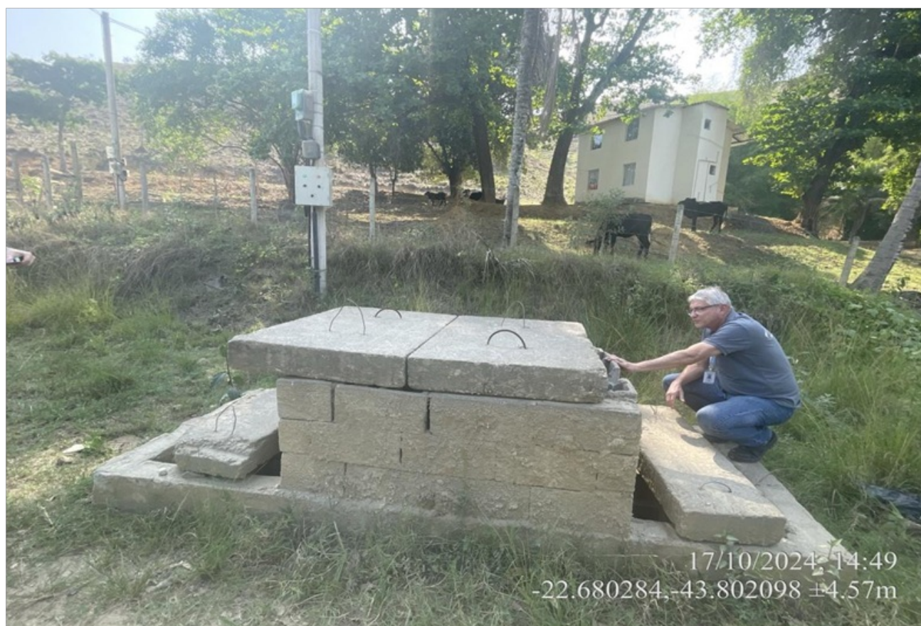
Foto 4 – Vista frontal do abrigo de alvenaria subterrâneo
