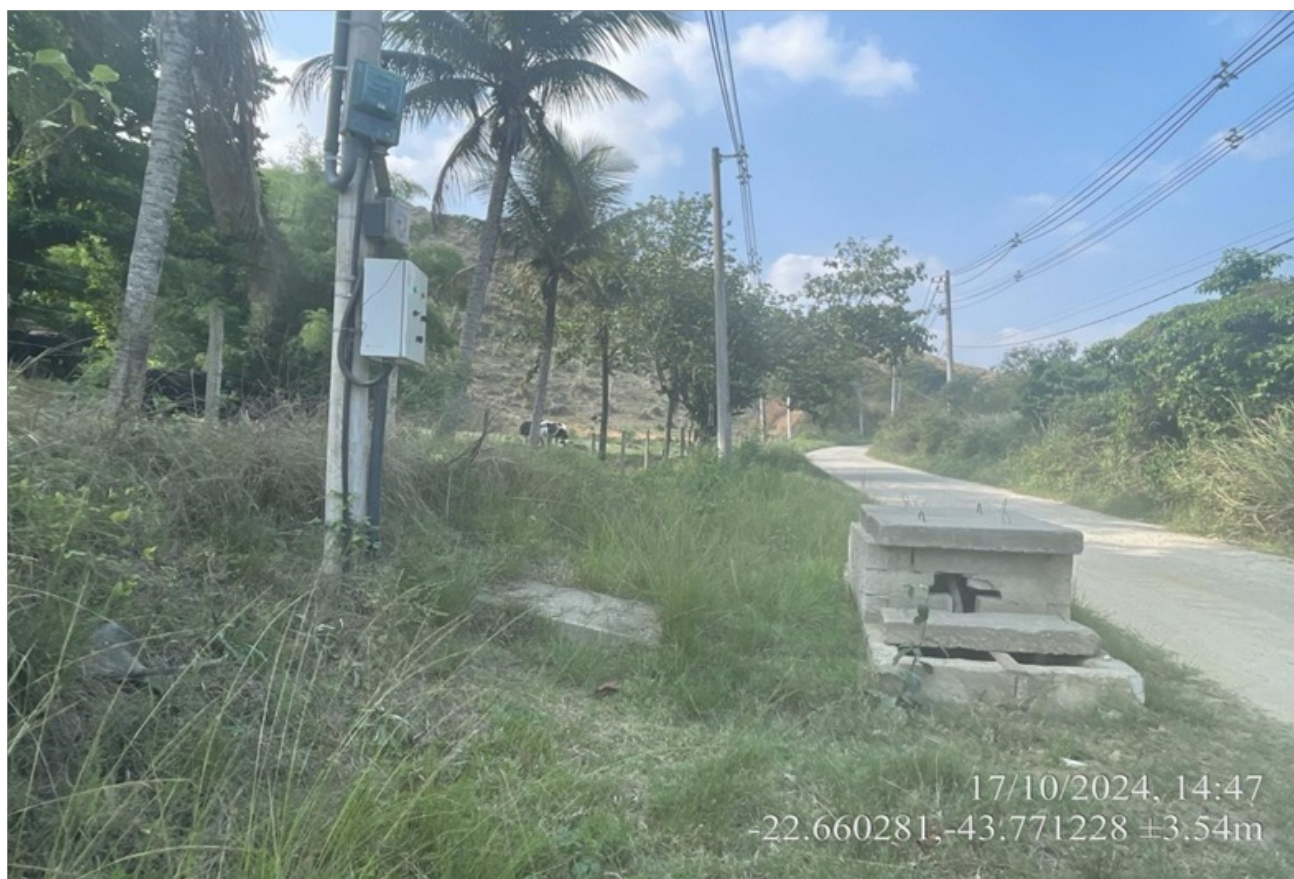
Foto 3 – Vista lateral do abrigo de alvenaria subterrâneo
