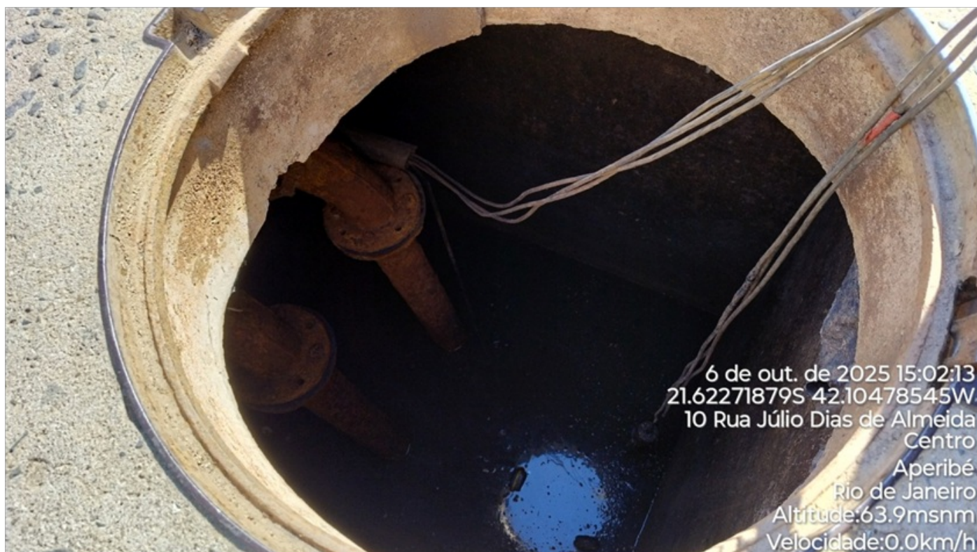
Foto 03 – Poço da motobomba submersível de recalque.
