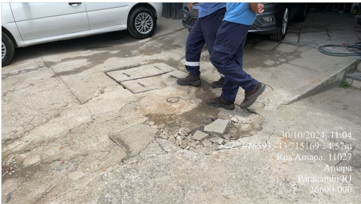
Foto 3 – Tampas de concreto
