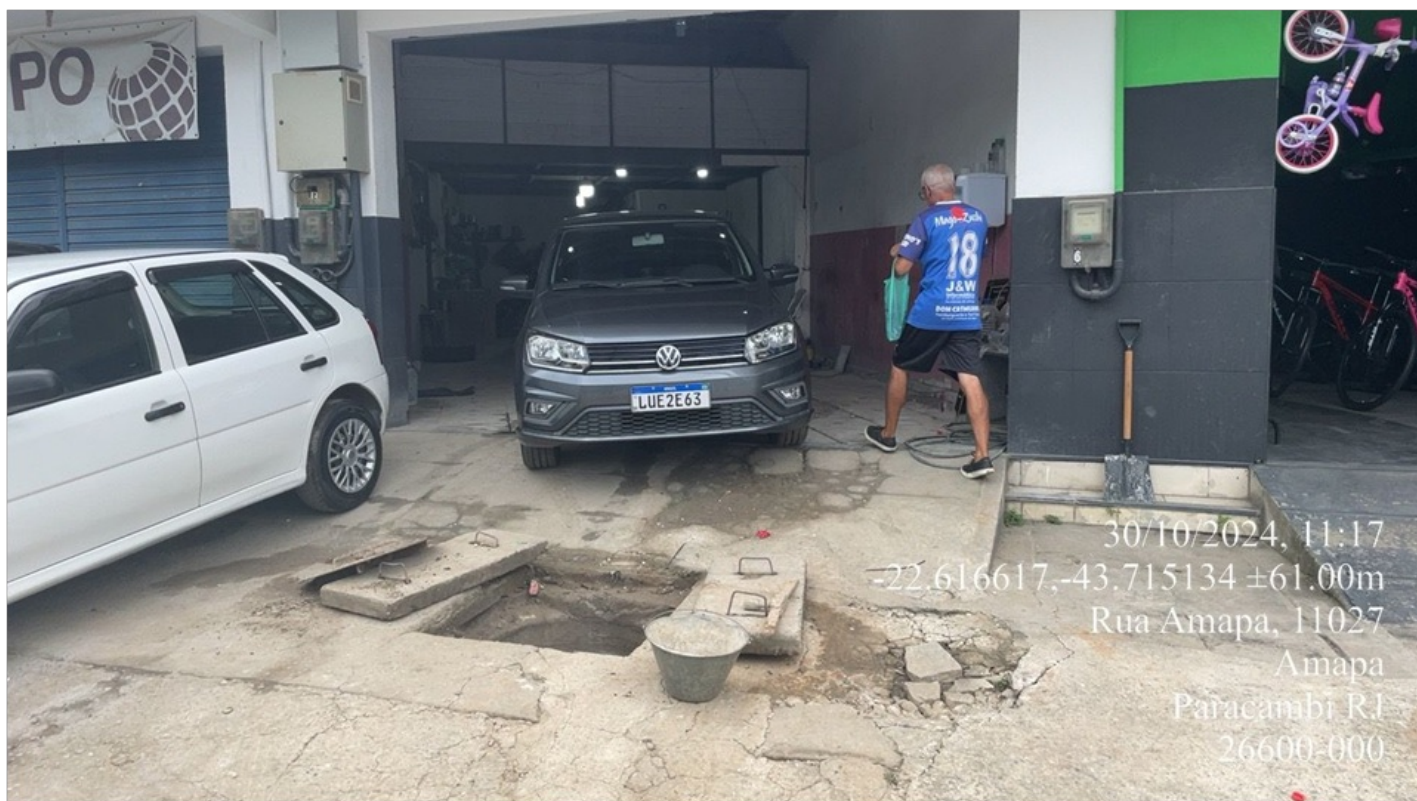
Foto 6 – Loja em frente ao abrigo da elevatória
