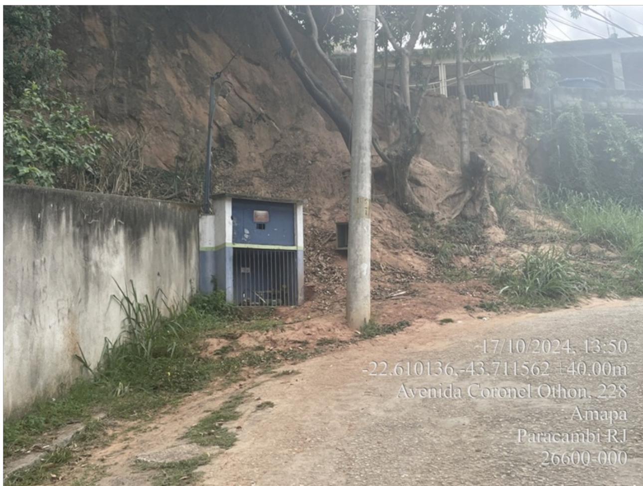
Foto 3 – Abrigo de alvenaria
