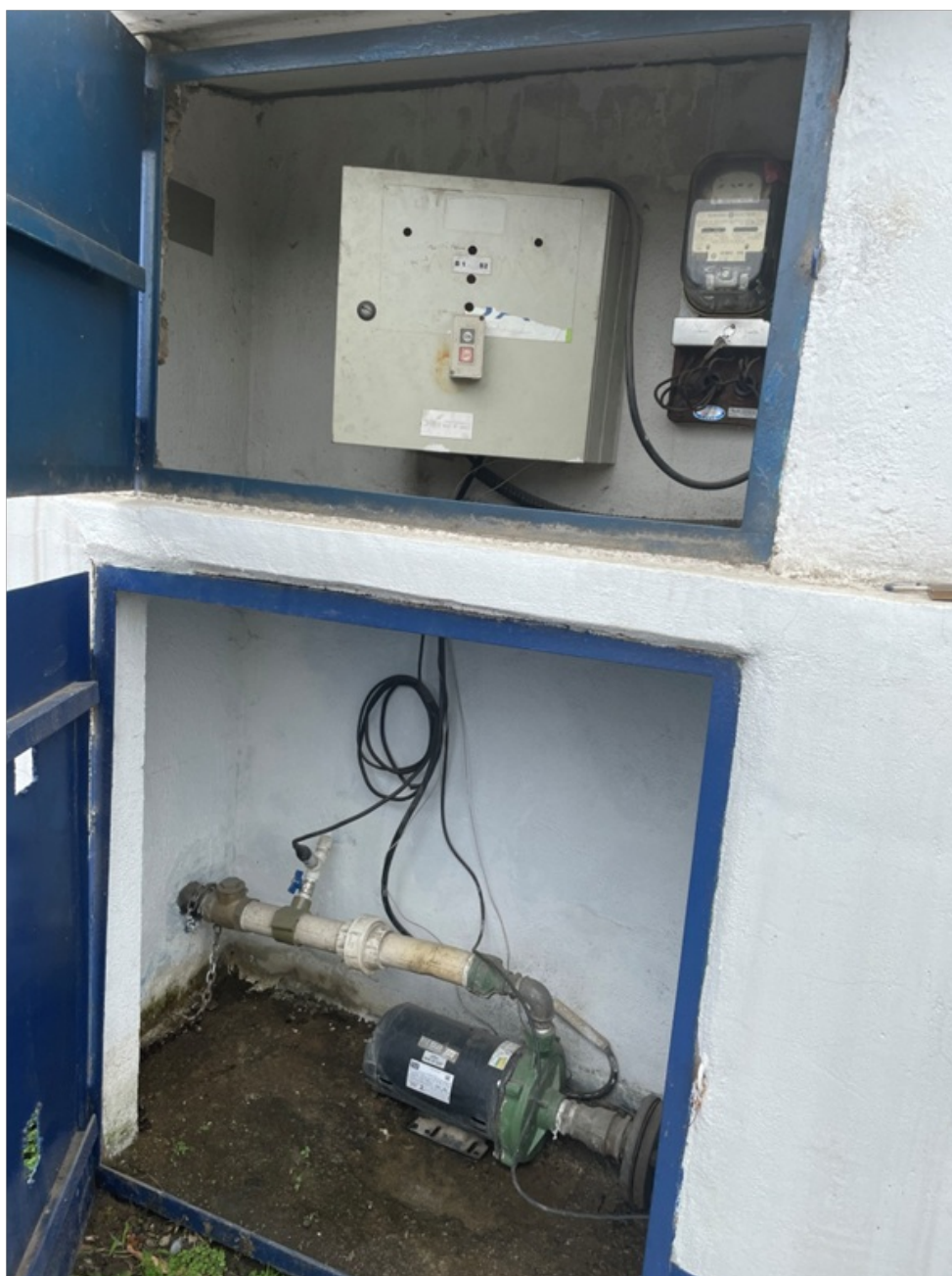
Foto 3 – Abrigo de alvenaria
