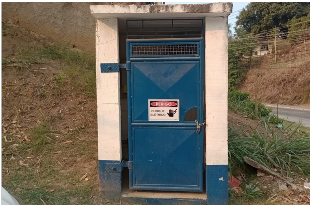
Foto 3 – Abrigo de alvenaria
