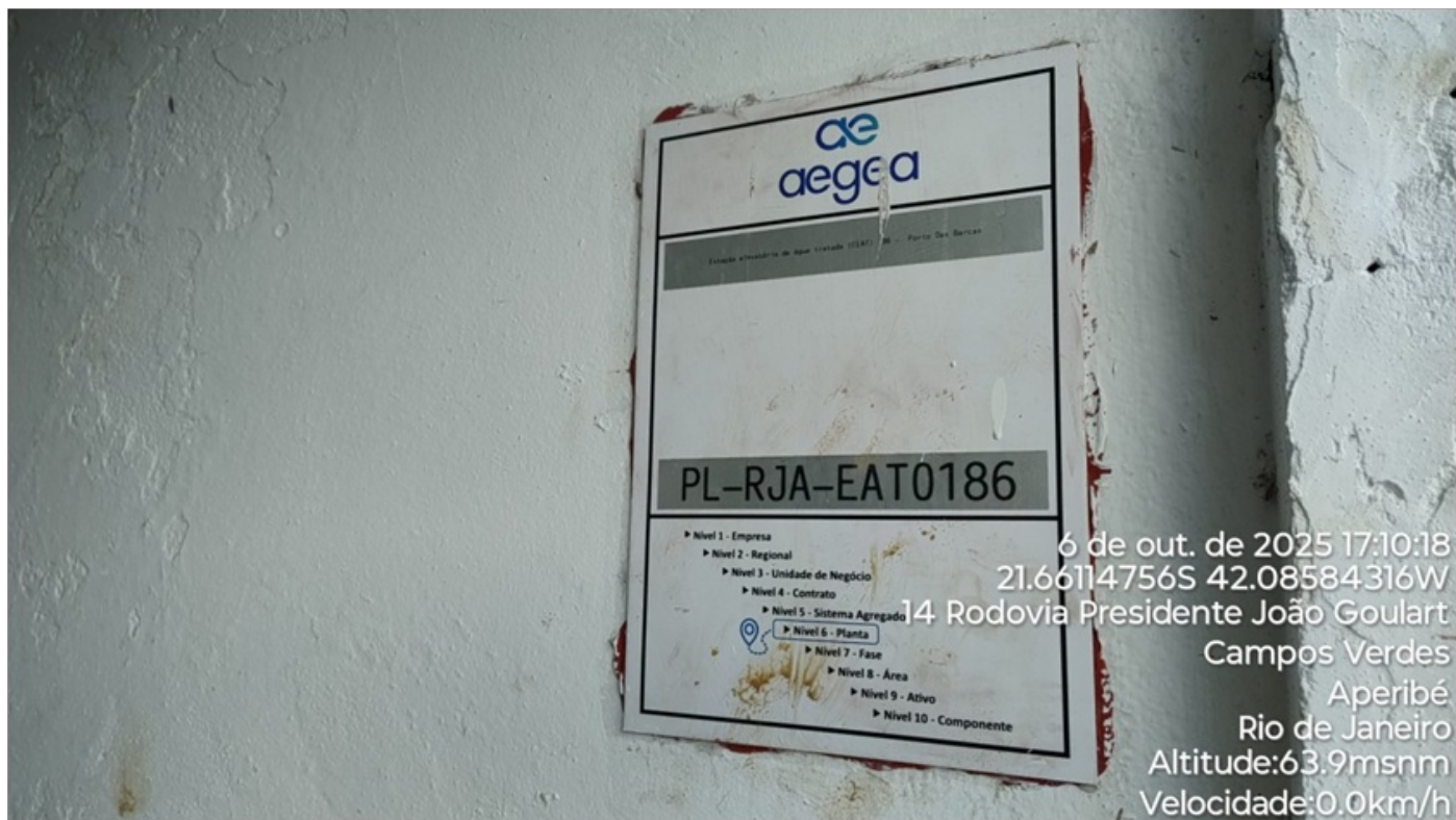
Foto 03 – Placa interna de identificação do bem reversível.
