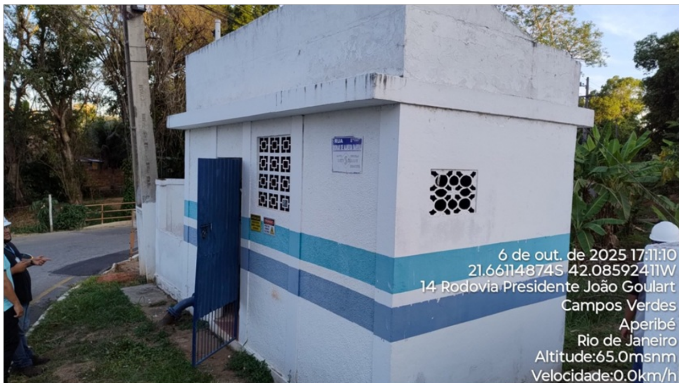
Foto 02 - Abrigo da EEAT.
