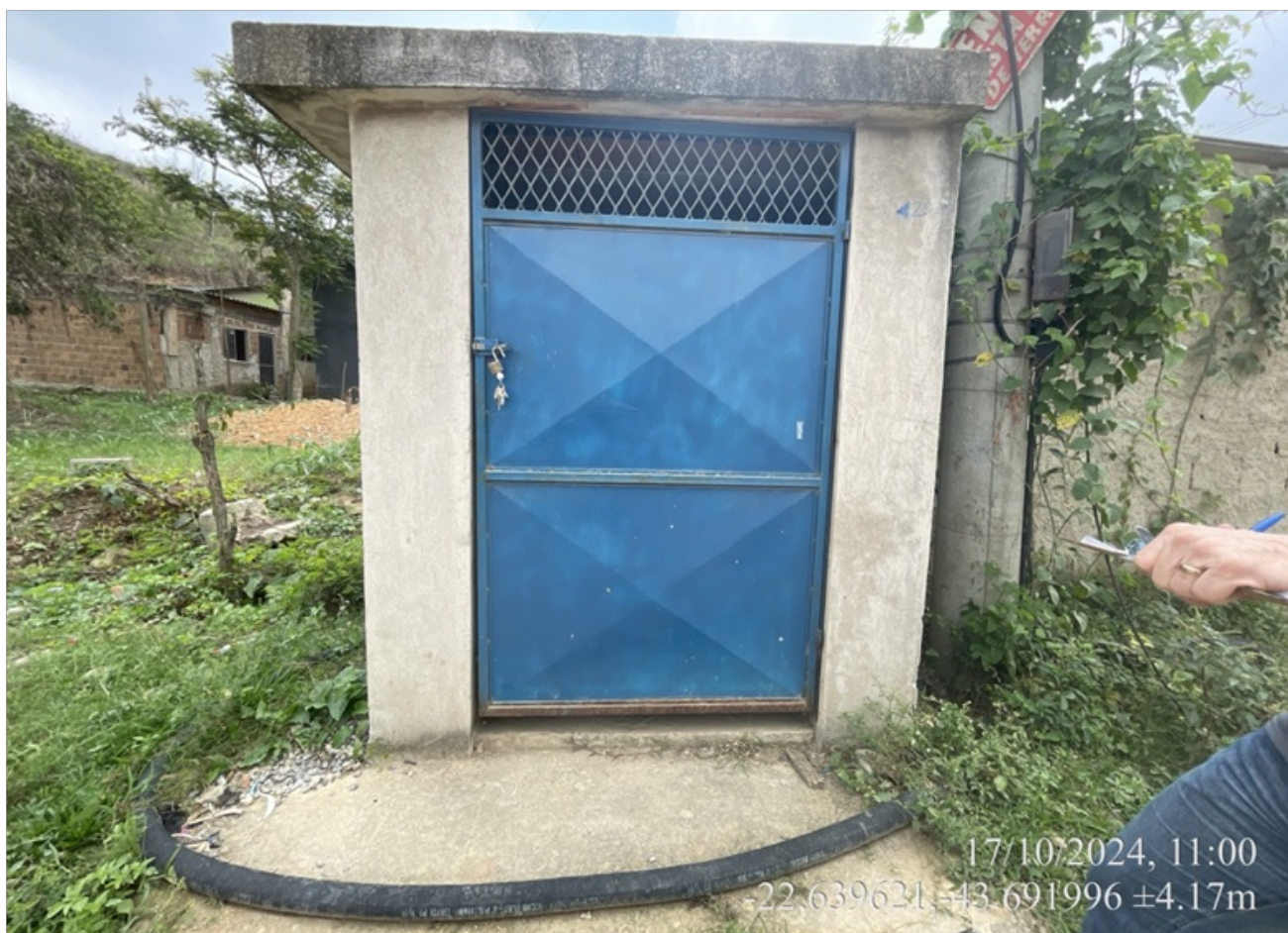
Foto 3 – Abrigo de alvenaria
